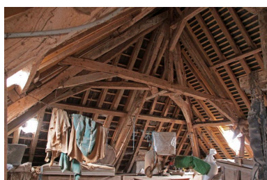
Maison, comble à surcroît : charpente (réemploi). Phot. Jean-Baptiste Darrasse IVR52_20107201395NUCA
