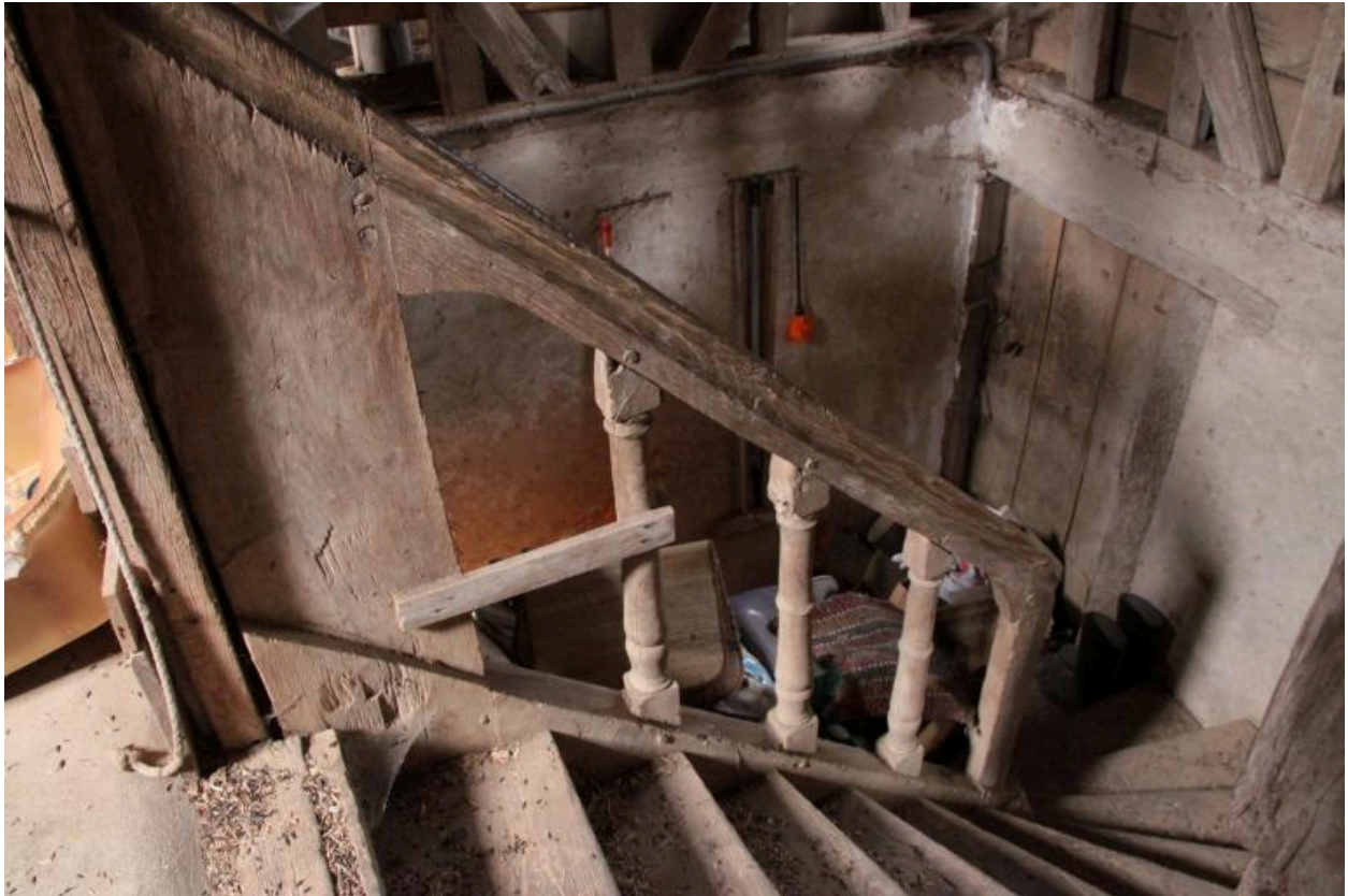
Maison : escalier menant au comble.
