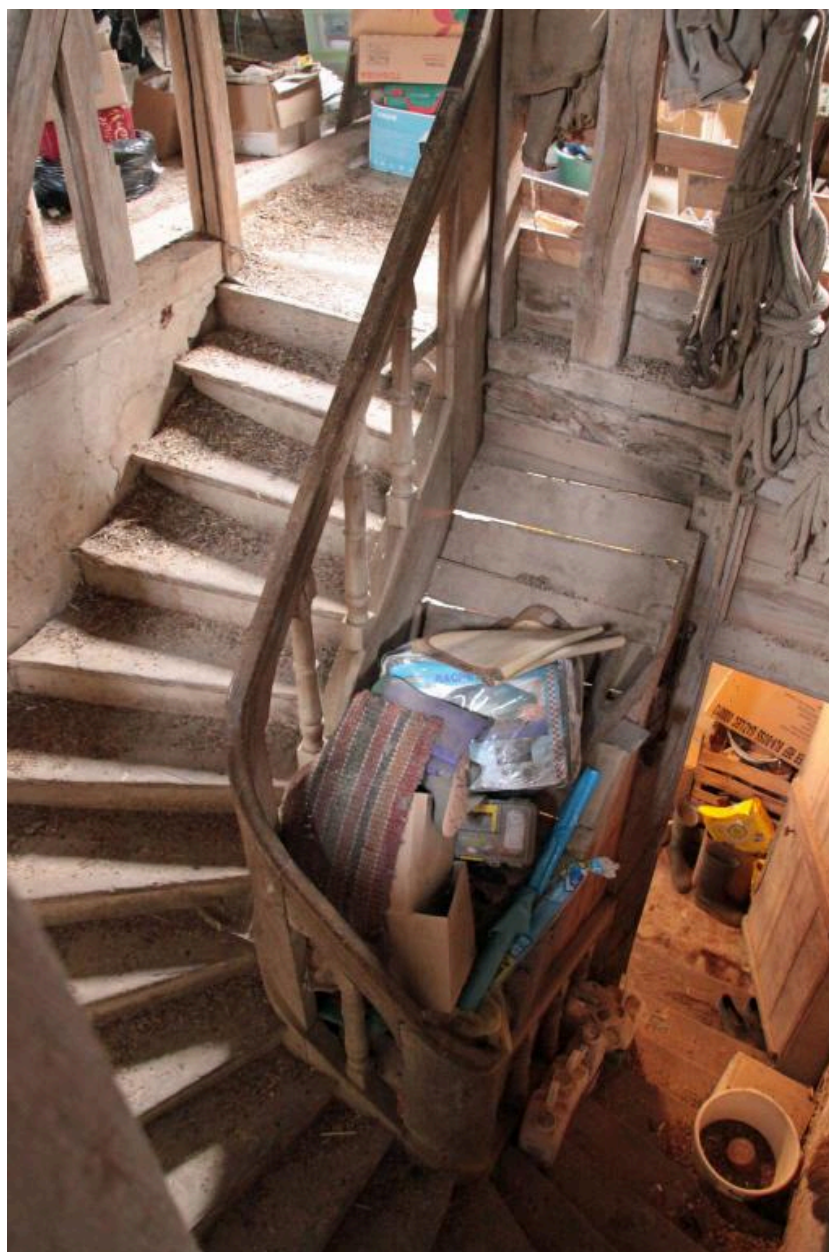
Maison, rez-de-chaussée : escalier central.
