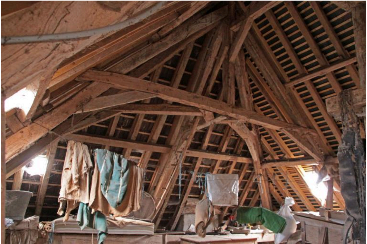
Maison, comble à surcroît : charpente (réemploi).
