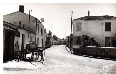
L'entrée est de la Grand rue vers 1950. Phot. Yannis (reproduction) Suire IVR52_20218501440NUCA
