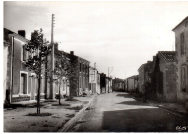
La Grand rue vue en direction de l'est, vers 1960. Phot. Yannis (reproduction) Suire IVR52_20218501382NUCA
