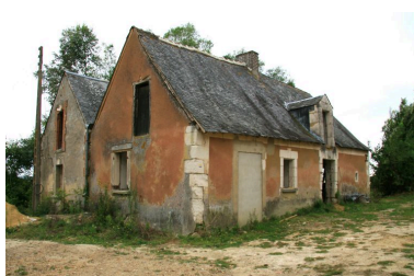
Parcelle 466 : la maison d'habitation et les étables sous un même toit. Phot. Jean-Baptiste Darrasse IVR52_20087202164NUCA
