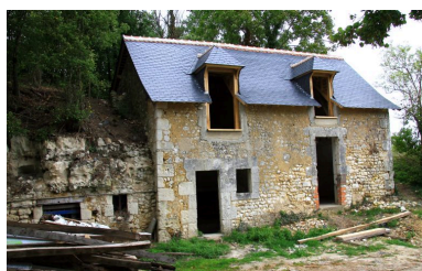
Parcelle 464 : maison d'habitation semi-troglodytique. Phot. Jean-Baptiste Darrasse IVR52_20087202173NUCA
