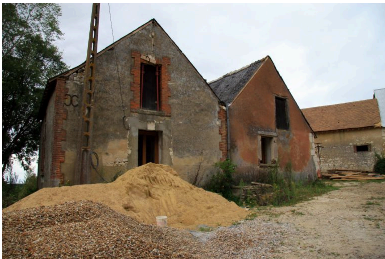
Parcelle 466 : la maison d'habitation adossée, pignons nord-est.
