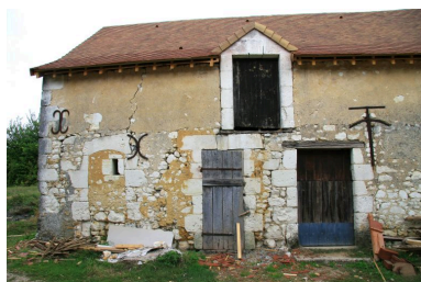
Parcelle 465 : les nouvelles étables rehaussées et remaniées. Phot. Jean-Baptiste Darrasse IVR52_20087202163NUCA
