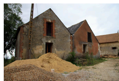
Parcelle 466 : la maison d'habitation adossée, pignons nord-est. Phot. Jean-Baptiste Darrasse IVR52_20087202171NUCA
