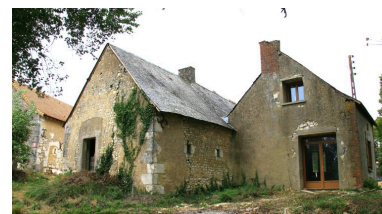
Parcelle 466 : la maison d'habitation adossée, pignons sud-ouest. Phot. Jean-Baptiste Darrasse IVR52_20087202168NUCA
