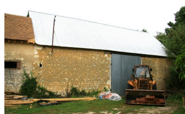
Parcelle 465 : la grange moderne. Phot. Jean-Baptiste Darrasse IVR52_20087202162NUCA
