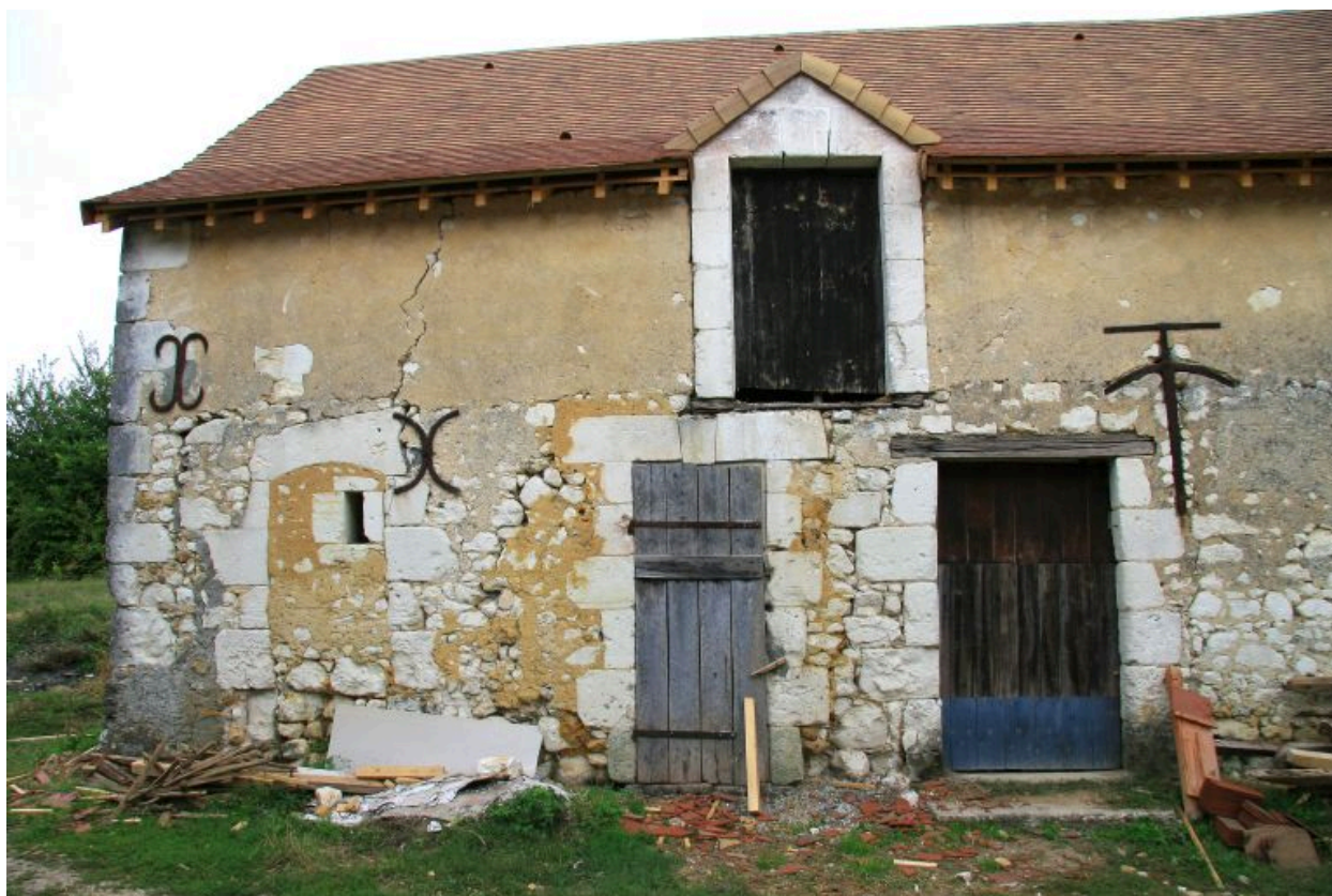
Parcelle 465 : les nouvelles étables rehaussées et remaniées.
