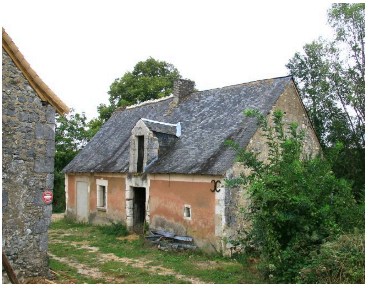
Parcelle 466 : la maison d'habitation, façade antérieure.
