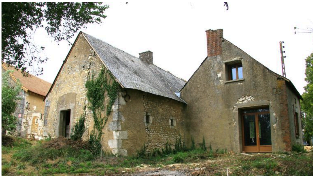
Parcelle 466 : la maison d'habitation adossée, pignons sud-ouest.
