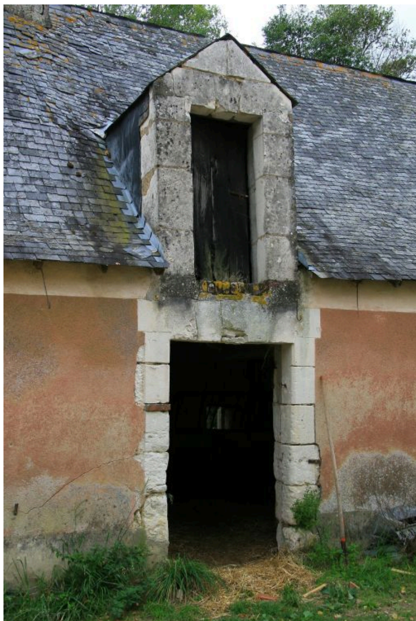
Parcelle 466 : la maison d'habitation, façade antérieure, détail.
