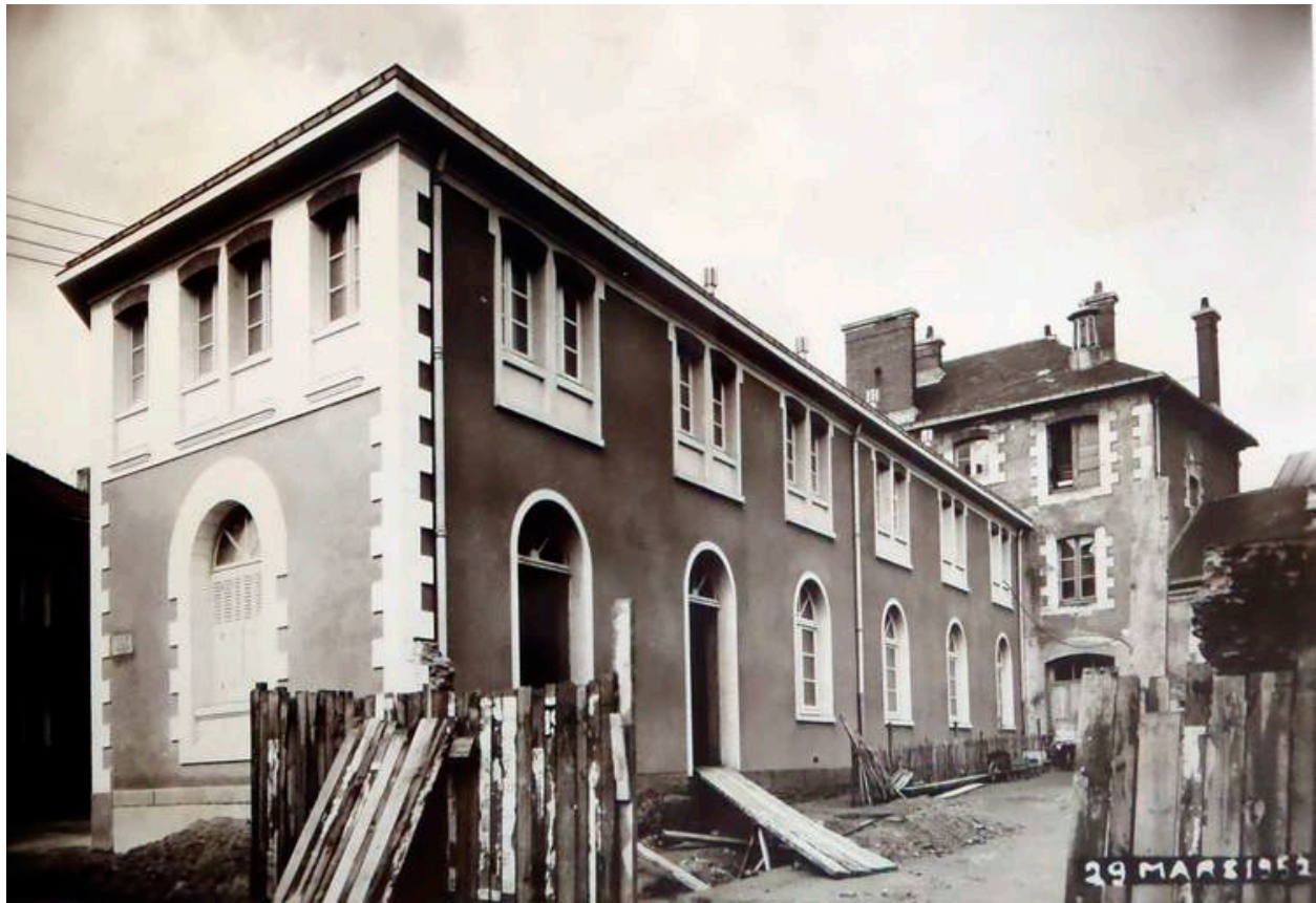
Arrière du bâtiment des douches et du réfectoire lors des travaux de réaménagement de 1952.
