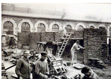
Construction des étendoirs, 1952. Phot. Patrick (reproduction) Jean IVR52_20134400908NUCA
