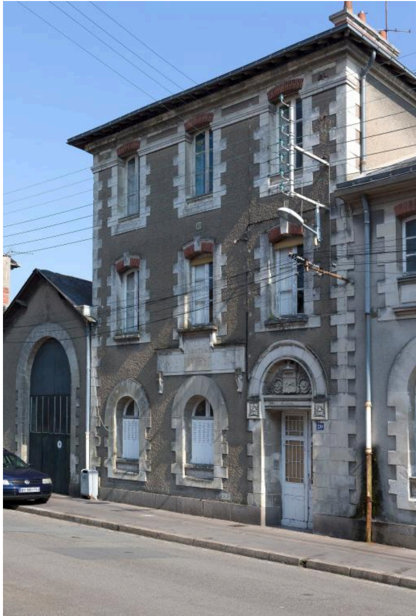
Bâtiment de secours (à gauche) et bâtiment des bains.
