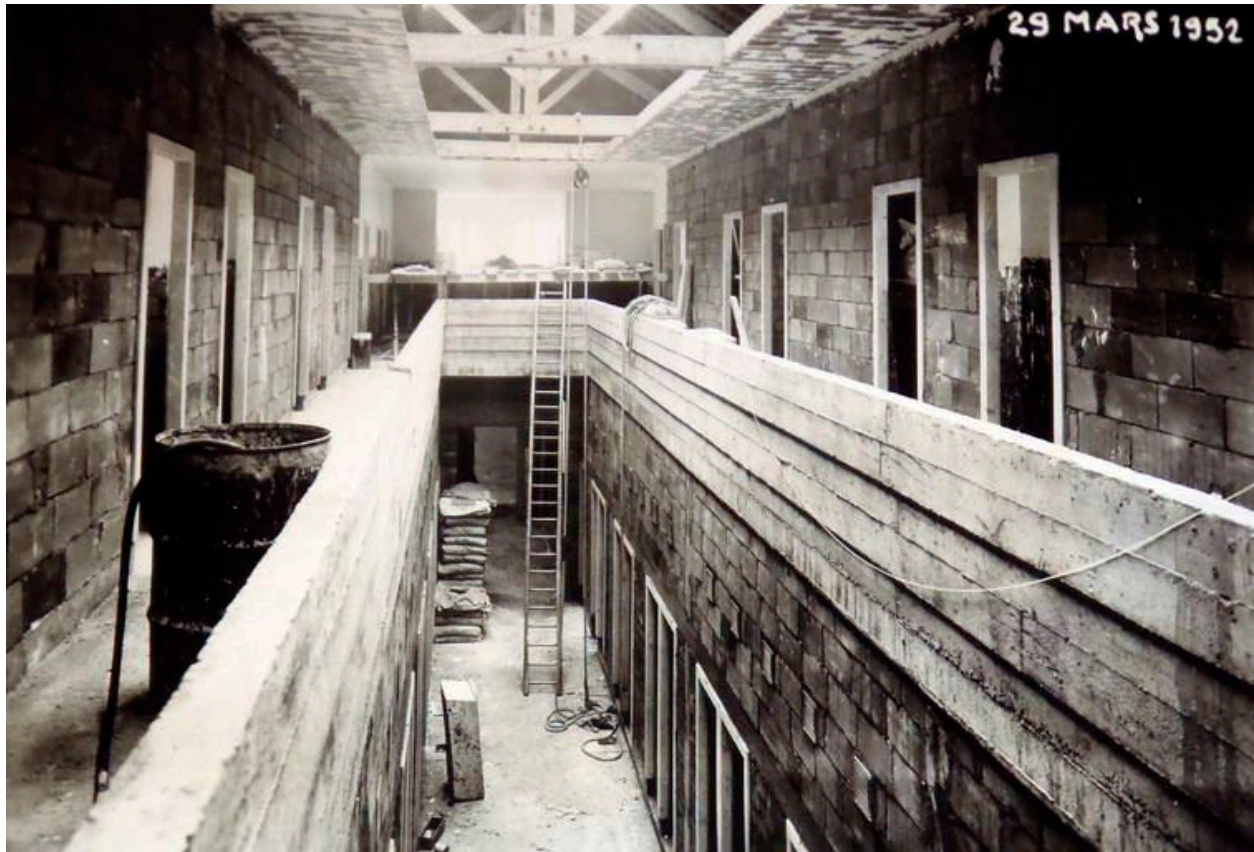
Travaux de réaménagement des salles de douches, 1952.
