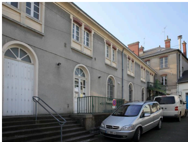
Arrière de l'ancien réfectoire. Phot. Denis Pillet IVR52_20134401268NUCA
