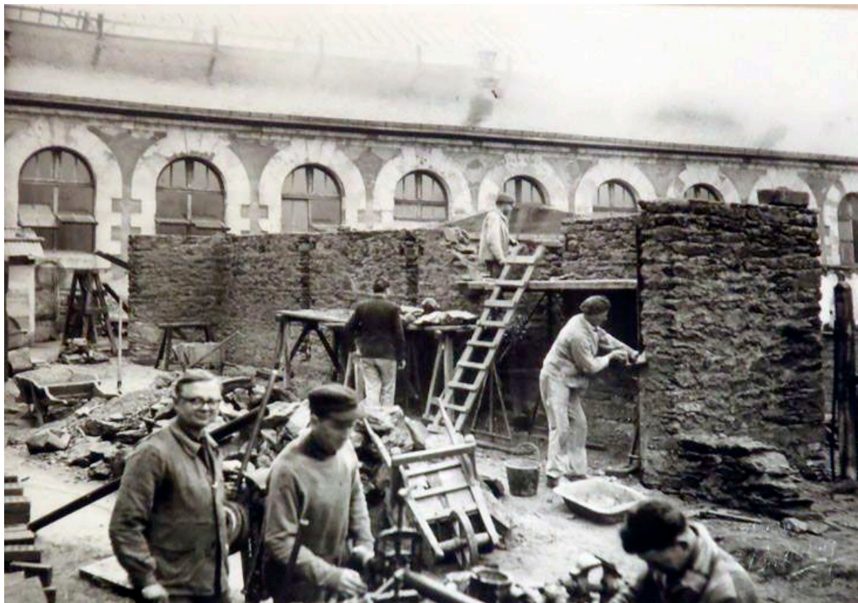
Construction des étendoirs, 1952.
