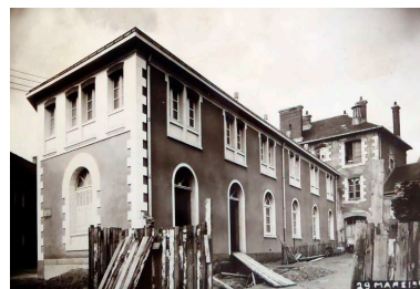
Arrière du bâtiment des douches et du réfectoire lors des travaux de réaménagement de 1952. Phot. Patrick (reproduction) Jean IVR52_20134400897NUCA
