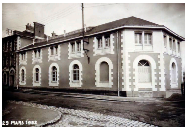
Bâtiment des douches et du réfectoire lors des travaux de réaménagement de 1952. Phot. Patrick (reproduction) Jean IVR52_20134400896NUCA
