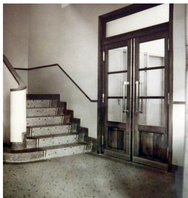
Porte d'accès au bâtiment des douches, 1952. Phot. Patrick (reproduction) Jean IVR52_20134400895NUCA
