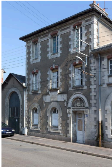
Bâtiment de secours (à gauche) et bâtiment des bains. Phot. Denis Pillet IVR52_20134401377NUCA
