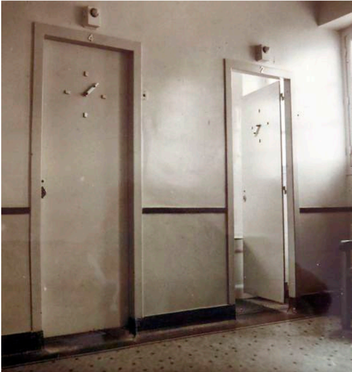
Portes d'accès aux douches avec la minuterie, 1952.
