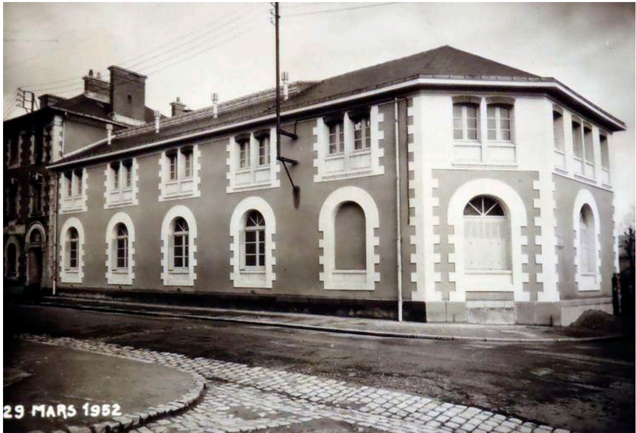
Bâtiment des douches et du réfectoire lors des travaux de réaménagement de 1952.
