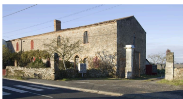
La borderie et l'entrée de la Cantrie. Phot. Yves Guillotin IVR52_20104403068NUCA
