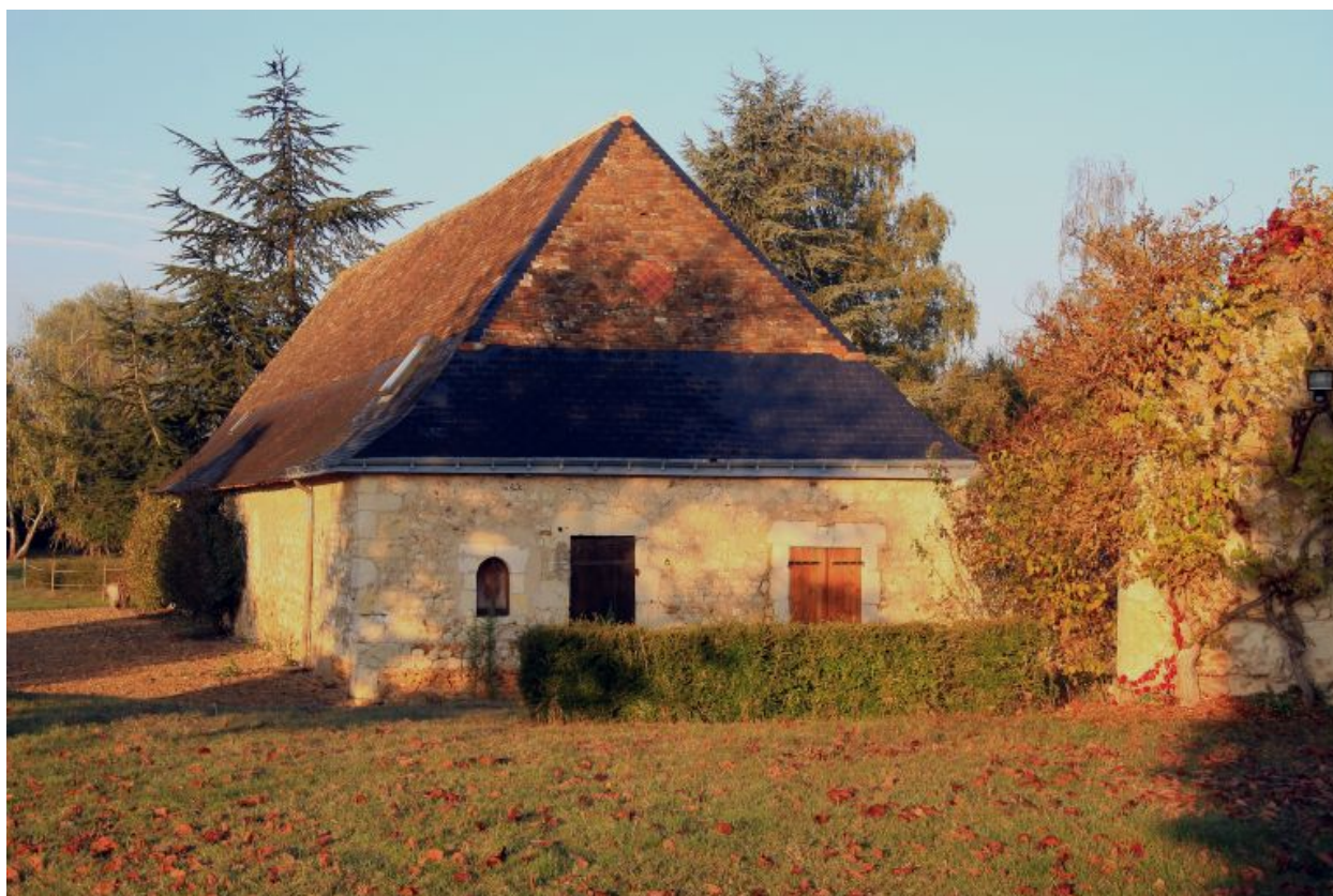
La grange : vue de volume prise de l'est.
