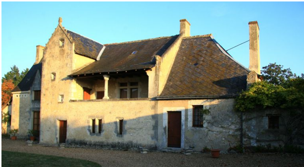
Vue de volume prise du portail.
