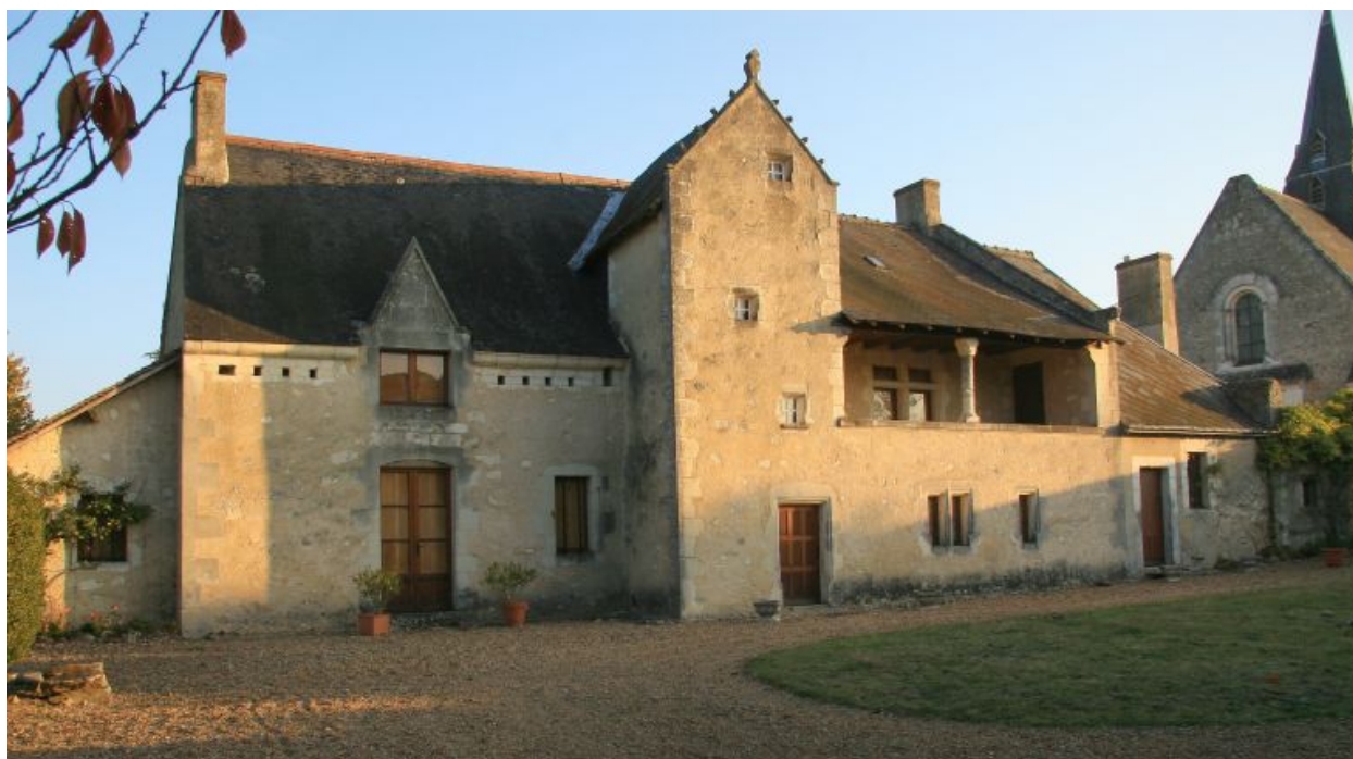
Vue d'ensemble de la façade sur cour.
