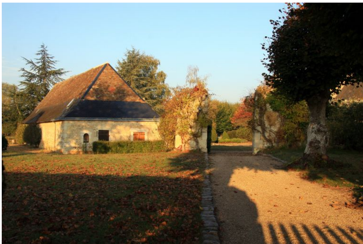
Portail d'entrée et la grange.
