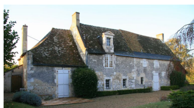
Façade postérieure sur le jardin. Phot. Jean-Baptiste Darrasse IVR52_20077202317NUCA
