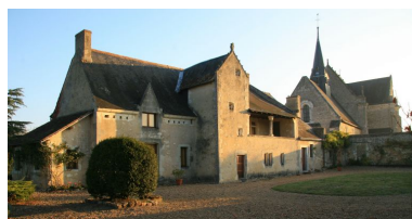
Vue d'ensemble du presbytère et de l'église. Phot. Jean-Baptiste Darrasse IVR52_20077202315NUCA
