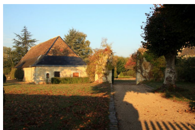
Portail d'entrée et la grange. Phot. Jean-Baptiste Darrasse IVR52_20077202320NUCA
