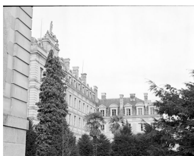
Façade antérieure est : vue d'ensemble depuis le sud-est. Phot. Jacques Le Callonnec IVR52_19755300002X
