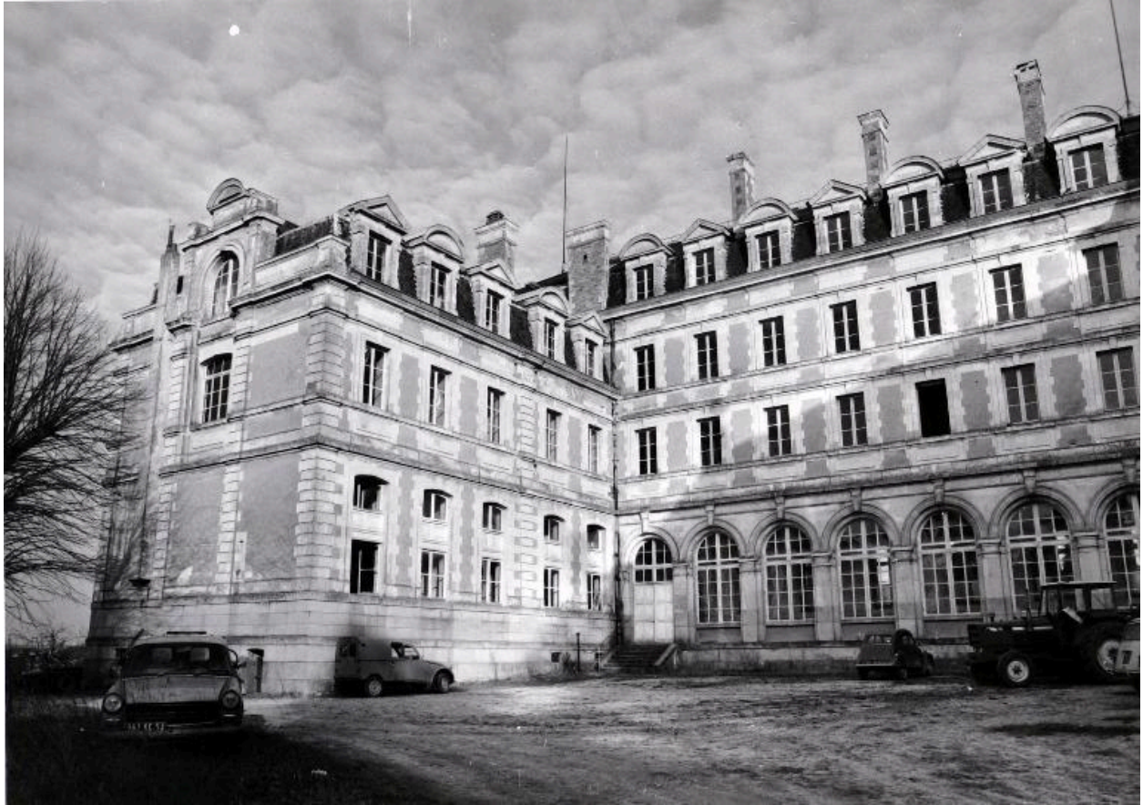
Façade postérieure du corps de logis principal : partie nord, façade postérieure de l'aile nord-ouest en retour d'équerre.
