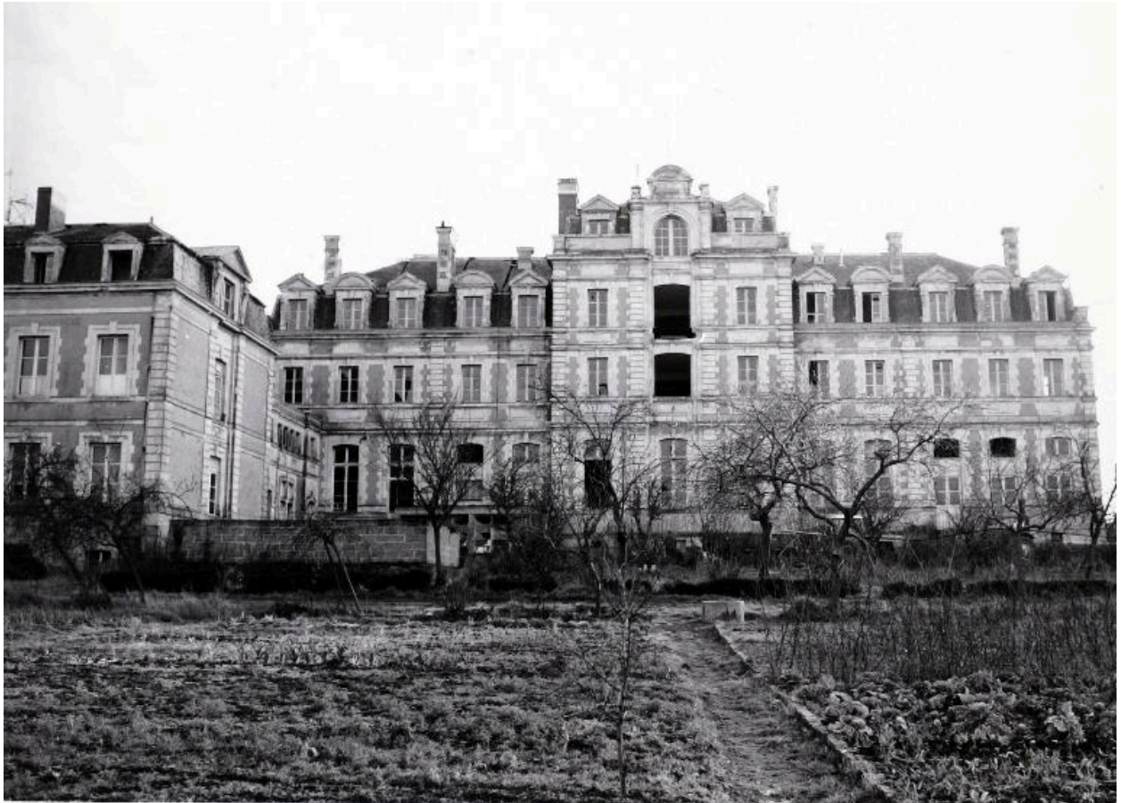
Façade nord : façade latérale nord du corps de logis principal flanqué de l'aile nord-est et nord-ouest.
