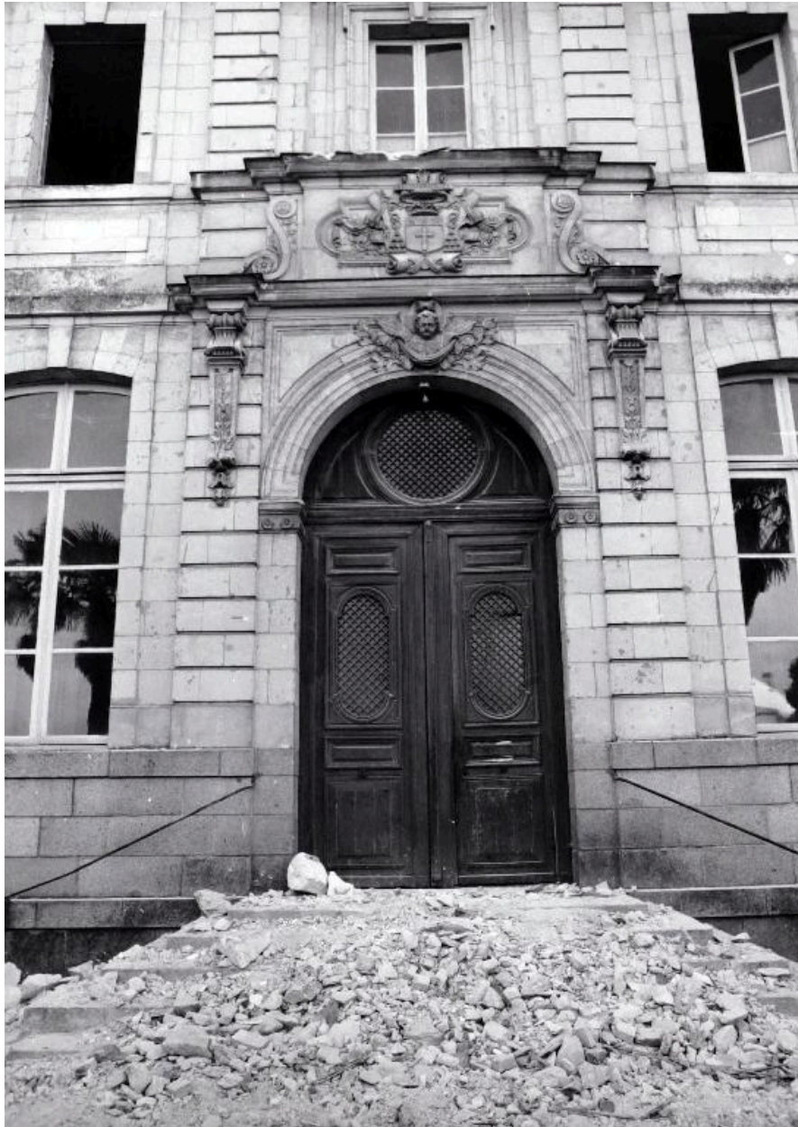
Façade antérieure est pavillon central : porte d'entrée.
