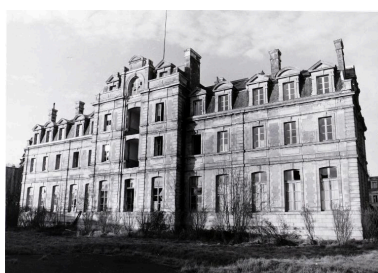
Façade sud : façade latérale sud du corps de logis principal flanqué de l'aile sud-ouest et de l'aile sud-est. Phot. Jacques Le Callonnec IVR52_19765300018X
