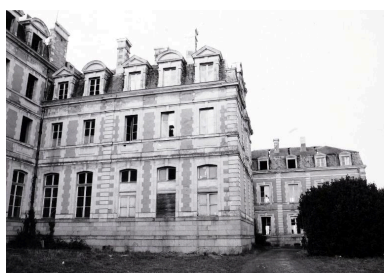
Façade sud : façade latérale sud du corps de logis principal flanqué de l'aile sud-ouest et de l'aile sud-est. Phot. Jacques Le Callonnec IVR52_19765300012X
