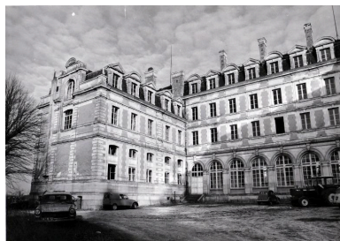
Façade postérieure du corps de logis principal : partie nord, façade postérieure de l'aile nord-ouest en retour d'équerre. Phot. Jacques Le Callonnec IVR52_19765300009X
