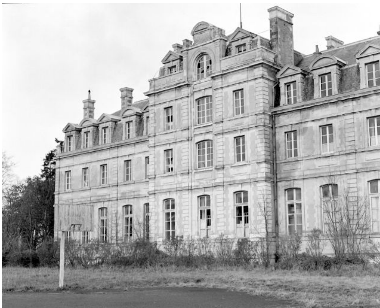
Façade sud : vue d'ensemble.
