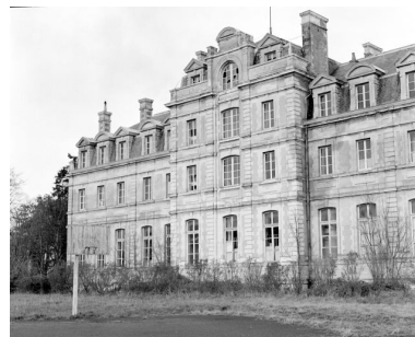
Façade sud : vue d'ensemble. Phot. Jacques Le Callonnec IVR52_19755300004X
