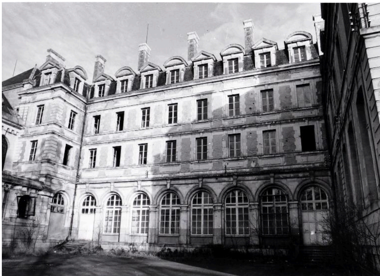
Corps de logis principal : façade postérieure partie sud.
