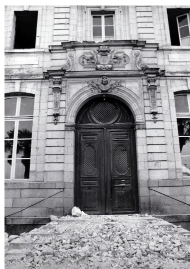
Façade antérieure est pavillon central : porte d'entrée. Phot. Jacques Le Callonnec IVR52_19765300014X
