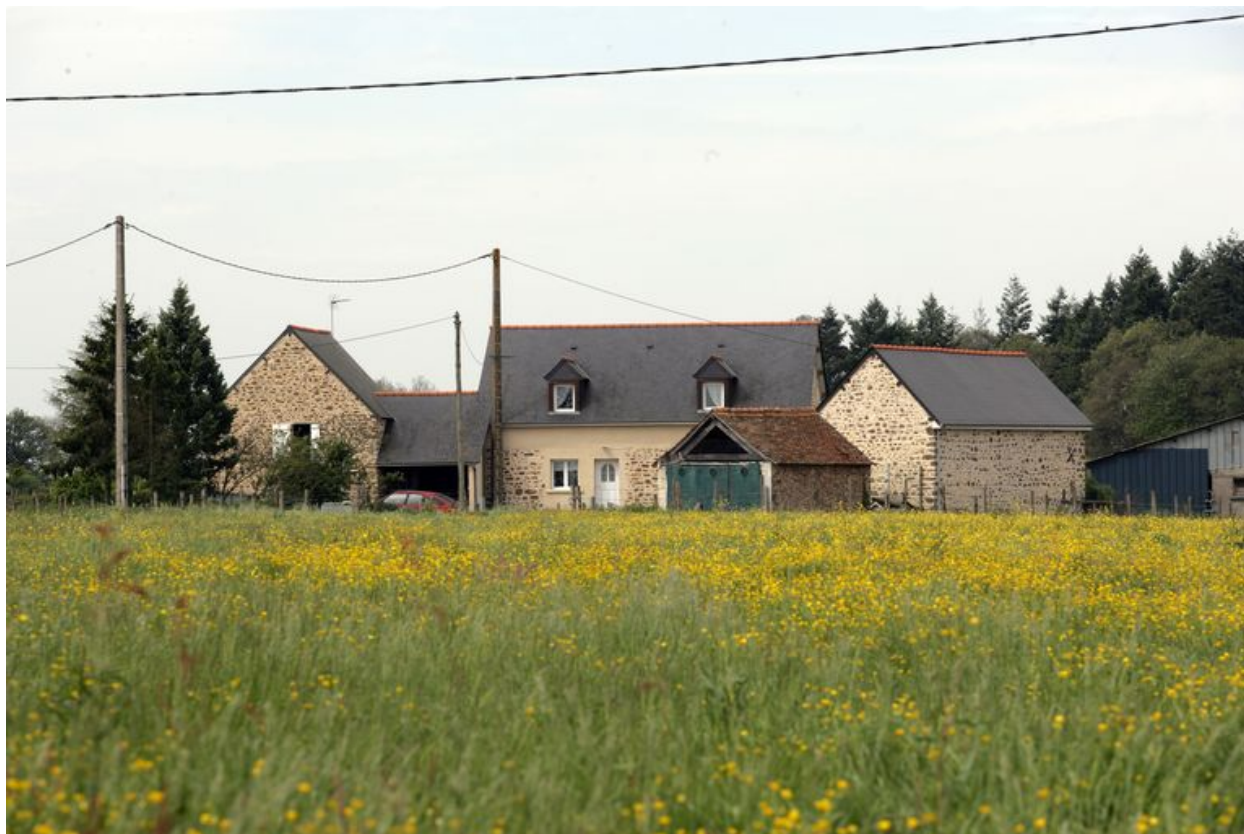
Vue d'ensemble depuis le chemin à l'est.
