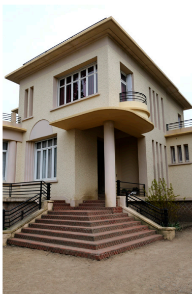
Maison d'Auguste Repussard : entrée principale. Phot. Bruno Rousseau, Phot. Youenn Communeau IVR52_20114900170NUCA
