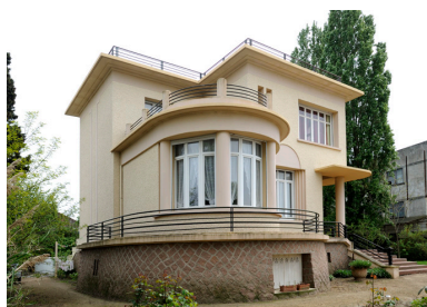
Maison d'Auguste Repussard, vue depuis le nord-ouest. Phot. Bruno Rousseau, Phot. Youenn Communeau IVR52_20114900174NUCA
