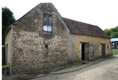
Les dépendances. Phot. Jean-Baptiste Darrasse IVR52_20067206985NUCA
