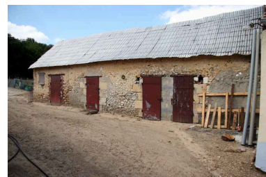
Les toits à poutres. Phot. Jean-Baptiste Darrasse IVR52_20067206984NUCA
