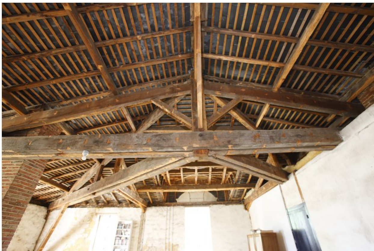
Vue de la charpente.
