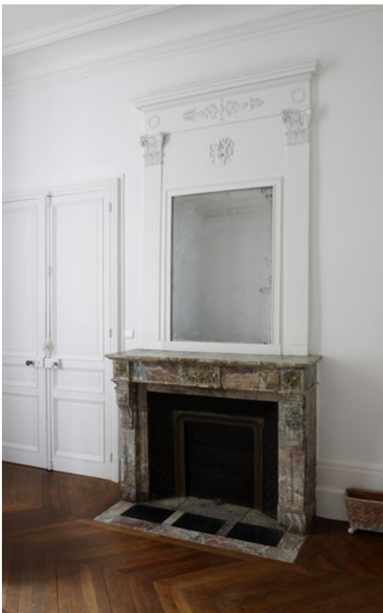
Cheminée de l'une des pièces du rez-de-chaussée.
