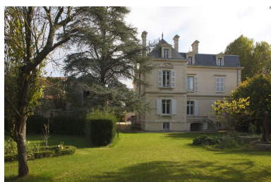
Façade ouest, donnant sur le jardin. Phot. Patrice Giraud IVR52_20088501246NUCA
