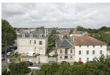
Vue prise de l'est, des toits d'une maison voisine montrant la façade rue du Docteur-Choyau. A gauche la maison, au centre les communs. Phot. Patrice Giraud IVR52_20088500903NUCA
