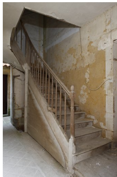
Escalier des communs. Phot. Patrice Giraud IVR52_20088501250NUCA
