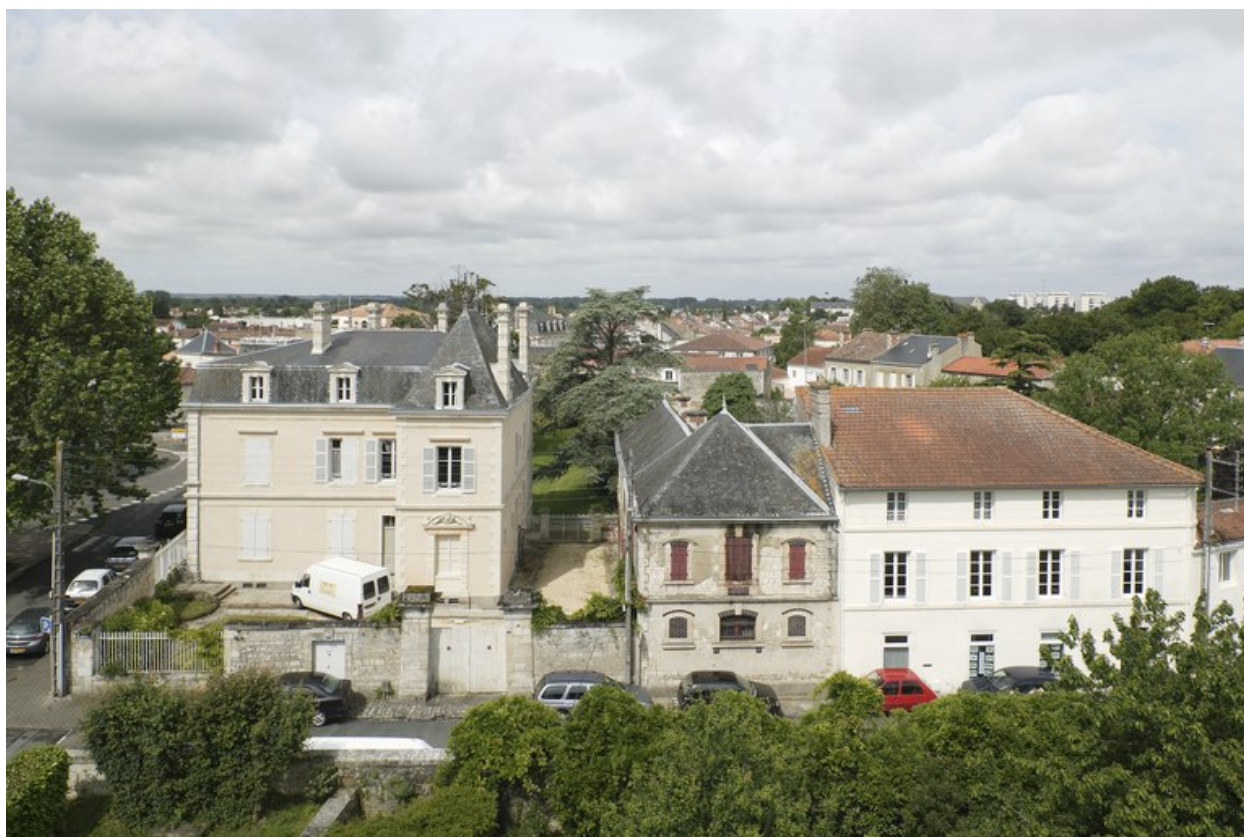
Vue prise de l'est, des toits d'une maison voisine montrant la façade rue du Docteur-Choyau. A gauche la maison, au centre les communs.
