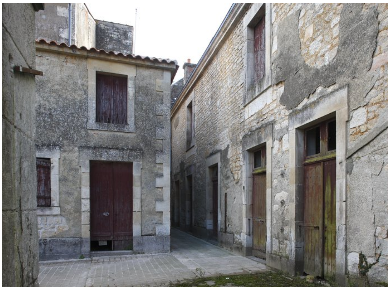
Vue des communs prise de l'ouest.
