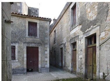
Vue des communs prise de l'ouest. Phot. Patrice Giraud IVR52_20088501243NUCA
