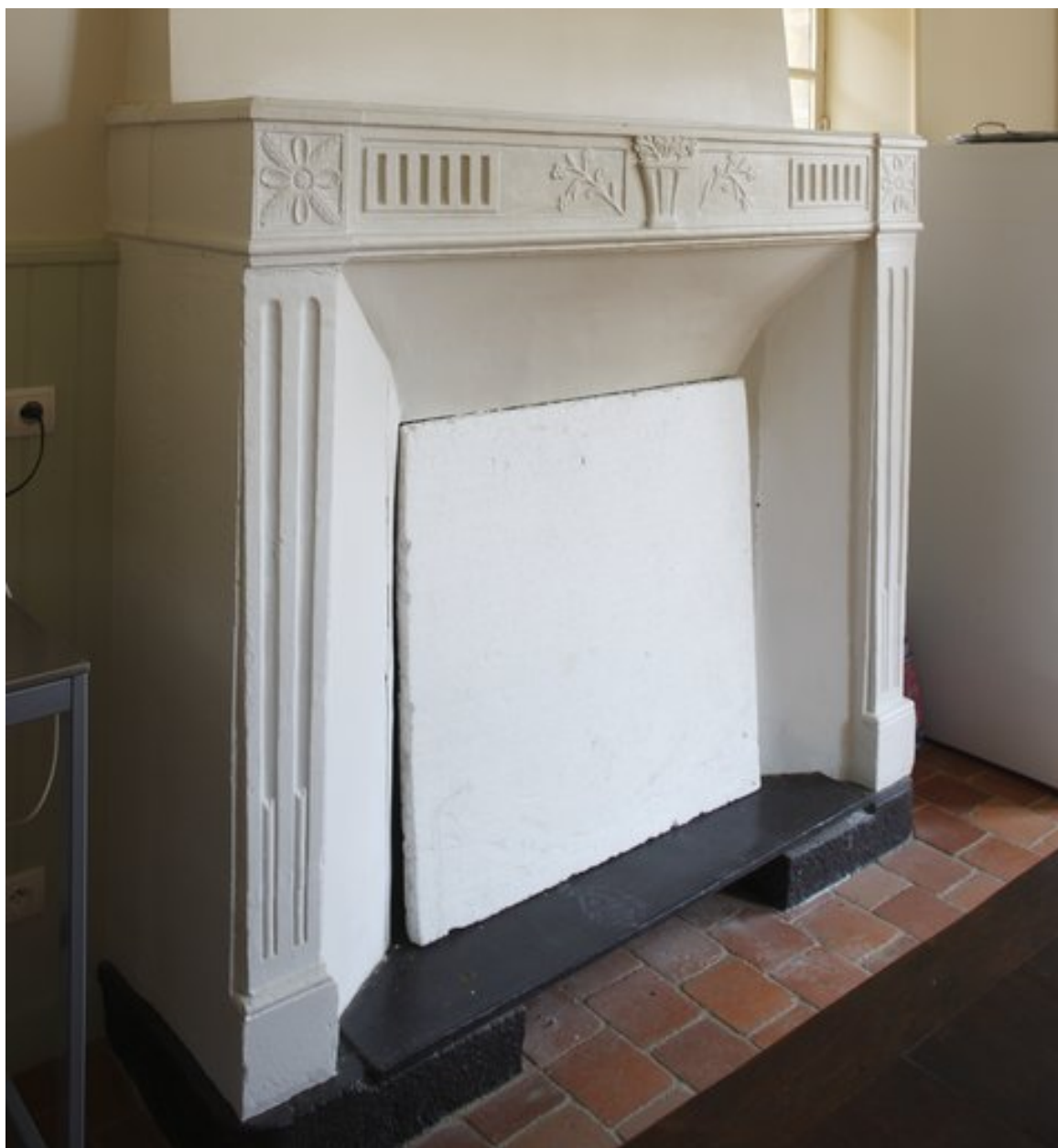
Cheminée de la cuisine.
