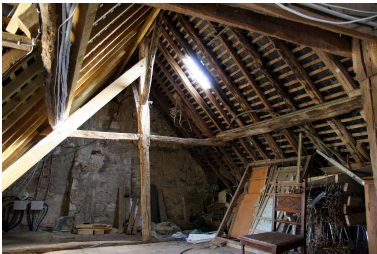
La maison : la charpente.
