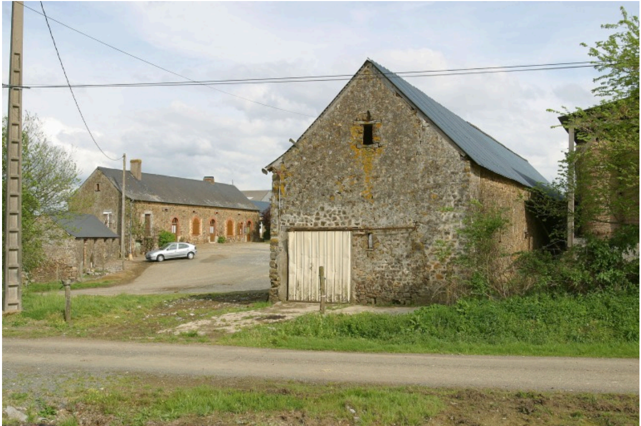
Vue d'ensemble depuis l'ouest : porcherie, logis, étable-grange.
