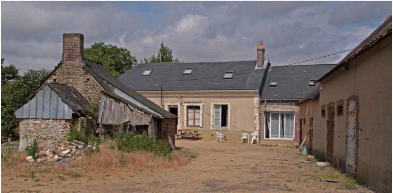
Vue d'ensemble de la maison et ses dépendances.
