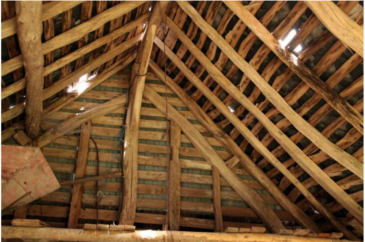
Le premier hangar : la charpente.
