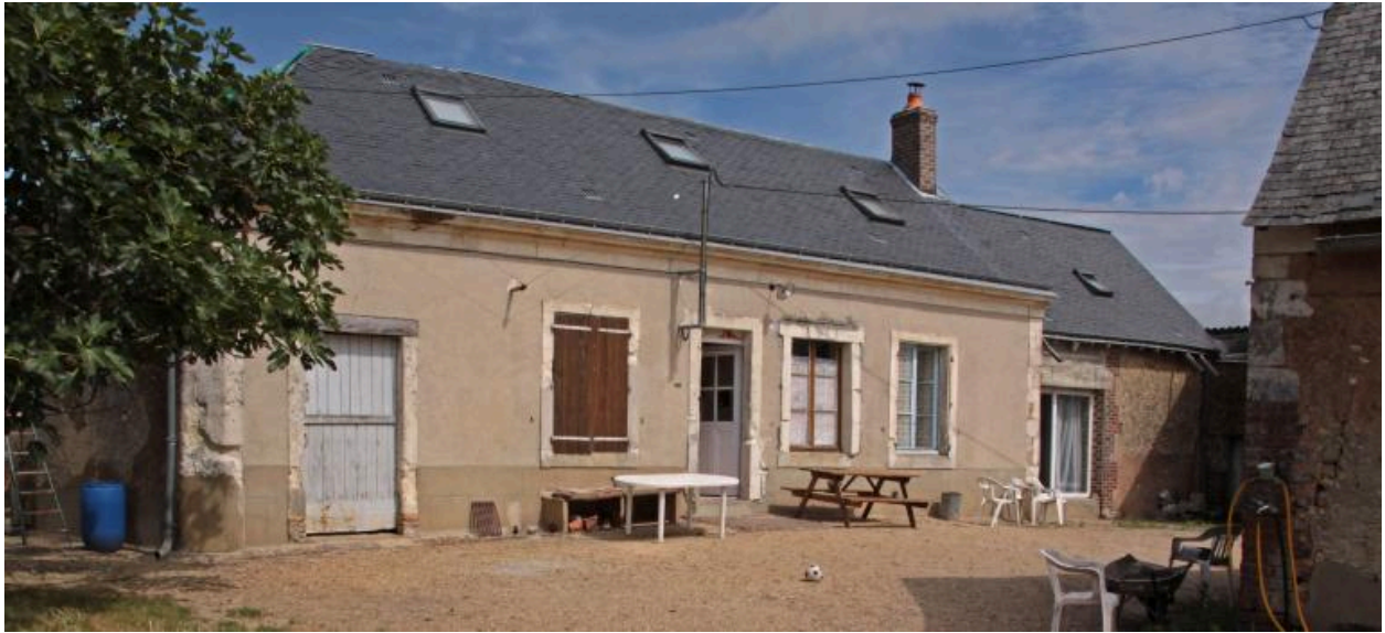
Maison : façade sur cour.
