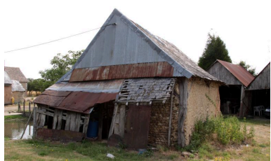
Le premier hangar : vue de volume. Phot. Jean-Baptiste Darrasse IVR52_20107201407NUCA
