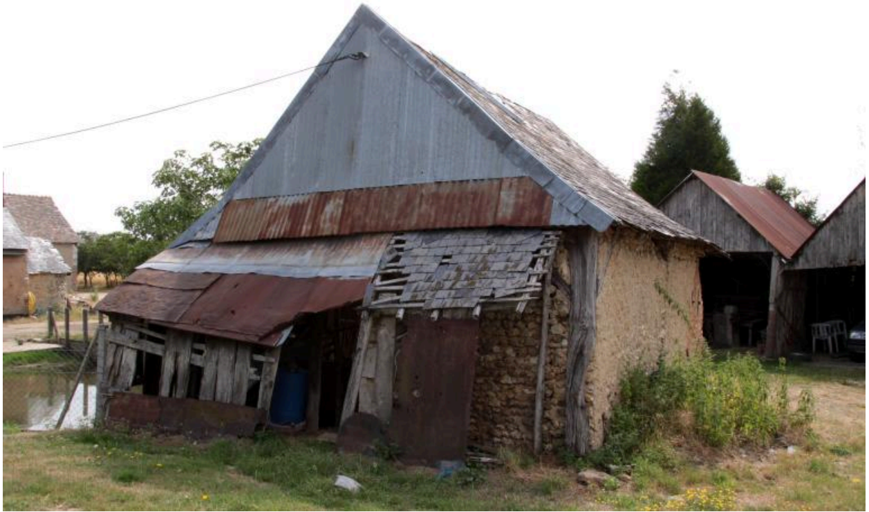
Le prmeier hangar : vue de volume.
