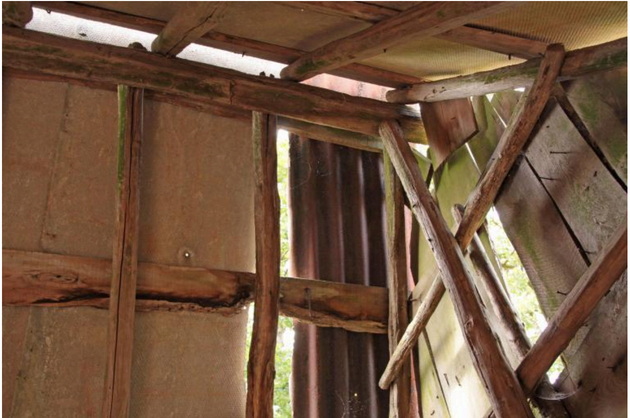
Le hangar 2 : faîtage et chevrons.
