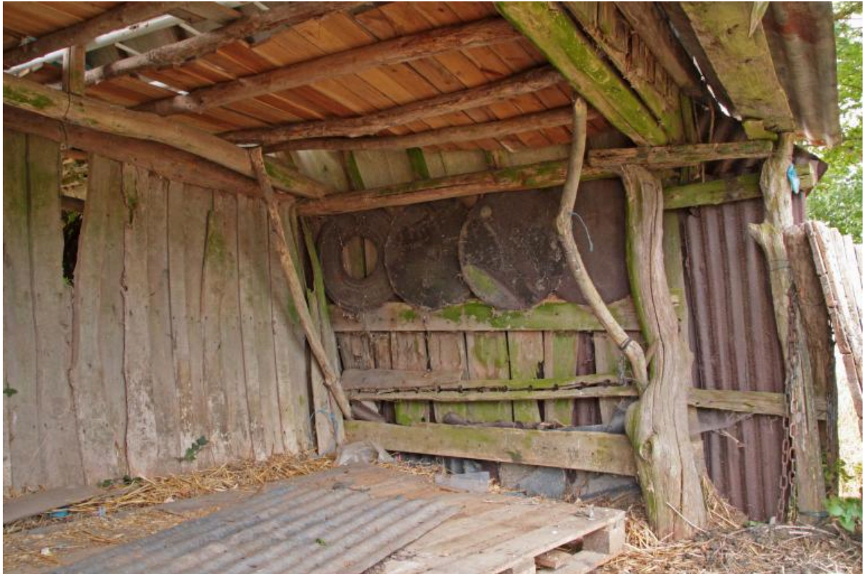
Les abris : vue intérieure.
