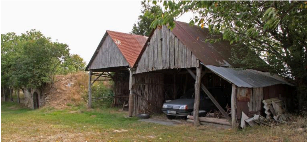
Petits hangars 2 et 3 : façades antérieures.
