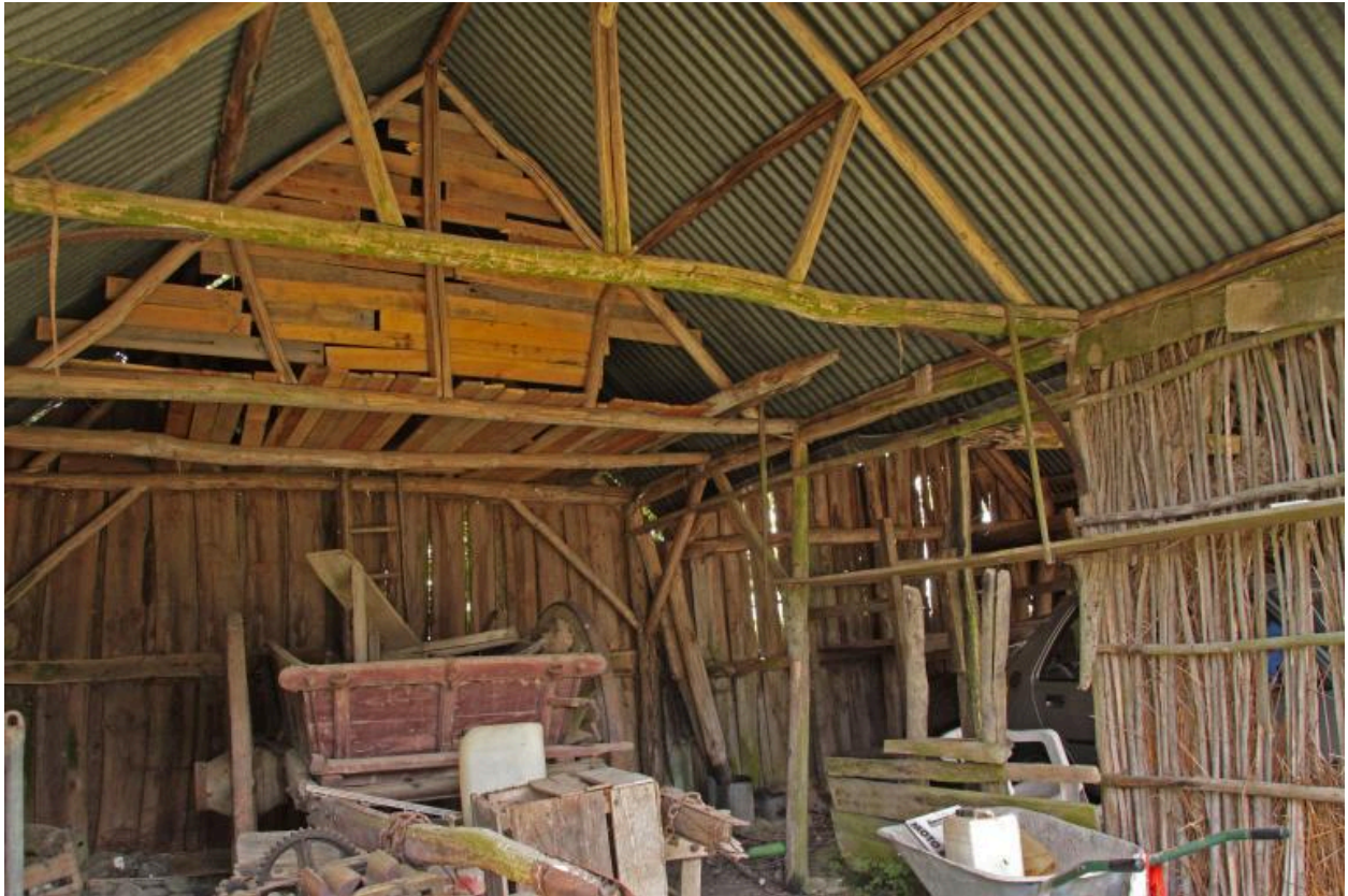
Le hangar 2 : structure de bois.
