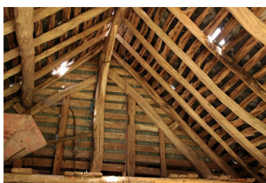
Le premier hangar : la charpente. Phot. Jean-Baptiste Darrasse IVR52_20107201413NUCA
