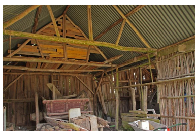
Le hangar 2 : structure de bois. Phot. Jean-Baptiste Darrasse IVR52_20107201414NUCA
