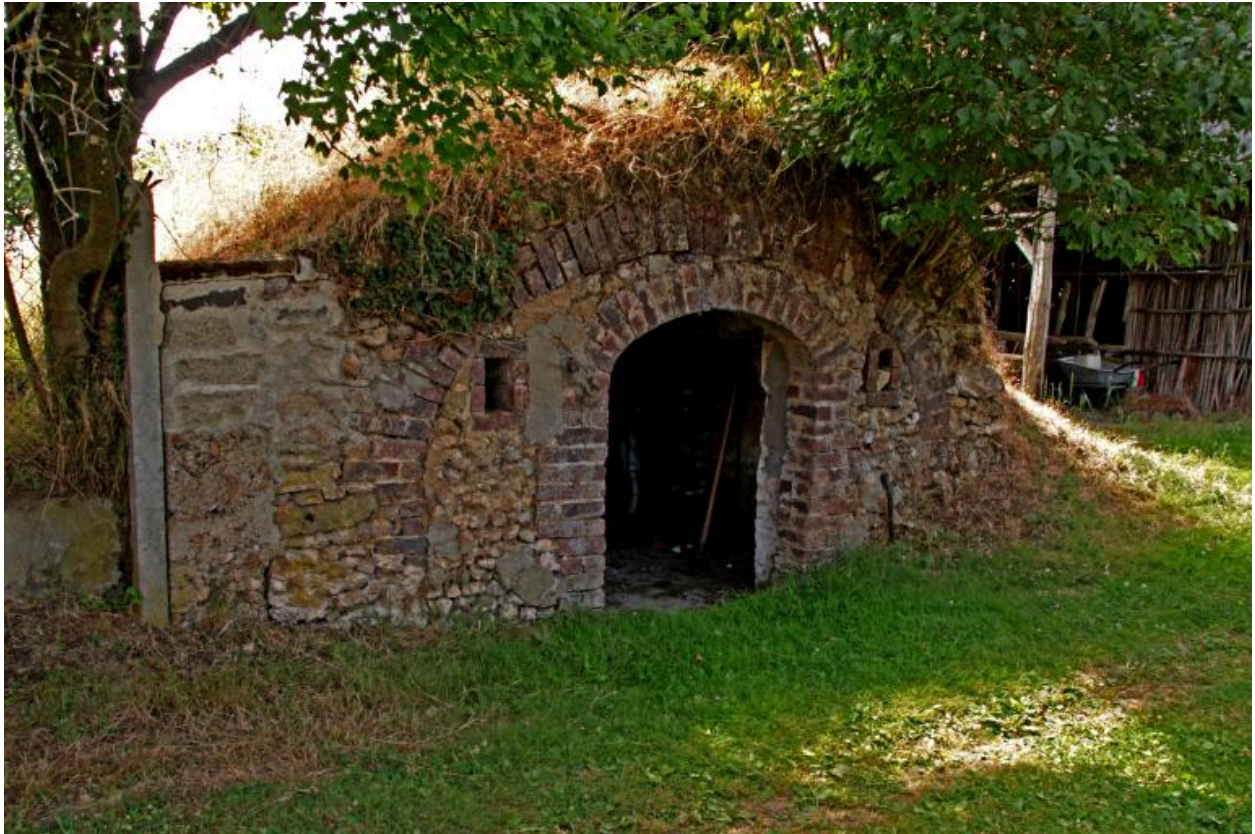
Cellier semi enterré.
