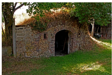
Cellier semi enterré. Phot. Jean-Baptiste Darrasse IVR52_20107201405NUCA
