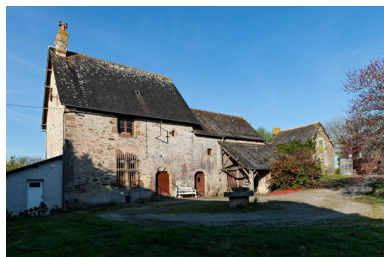
Façade sud du manoir de Glandsemé. Phot. Yves Guillotin IVR52_20195300520NUCA
