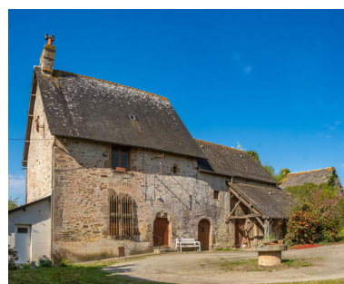
Manoir du Haut-Glandsemé, vue d'ensemble Phot. Pierre-Bernard Fourny IVR52_20225300627NUCA
