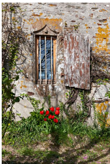
Fenêtre du rez-de-chaussée de la façade nord du manoir de Glandsemé. Phot. Yves Guillotin IVR52_20195300458NUCA
