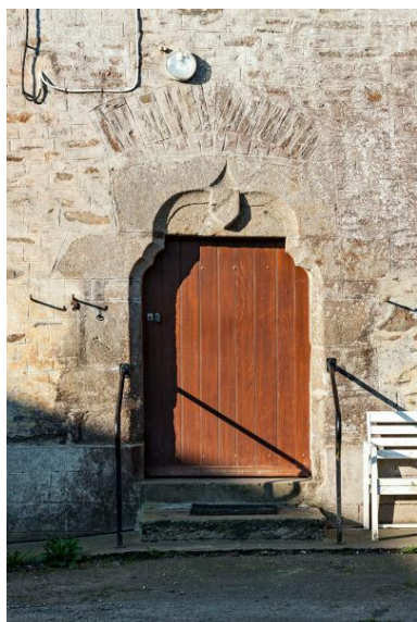
Porte de la façade nord. Phot. Yves Guillotin IVR52_20195300517NUCA
