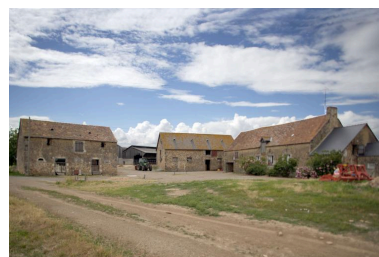
Vue d'ensemble depuis le chemin à l'est : l'étable à chevaux, l'étable à vaches-grange, le logis-étable. Phot. François Lasa IVR52_20055301977NUCA
