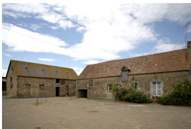
L'étable à vaches- grange et le logis-étable. Phot. François Lasa IVR52_20055301975NUCA
