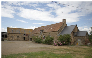
L'étable à vaches- grange et le logis-étable. Phot. François Lasa IVR52_20055301976NUCA
