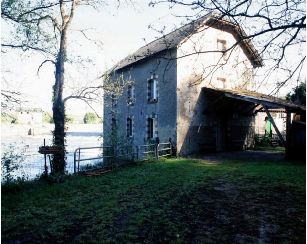
Les façades sud-ouest et sud-est. Au second plan, le barrage et la maison éclusière.
