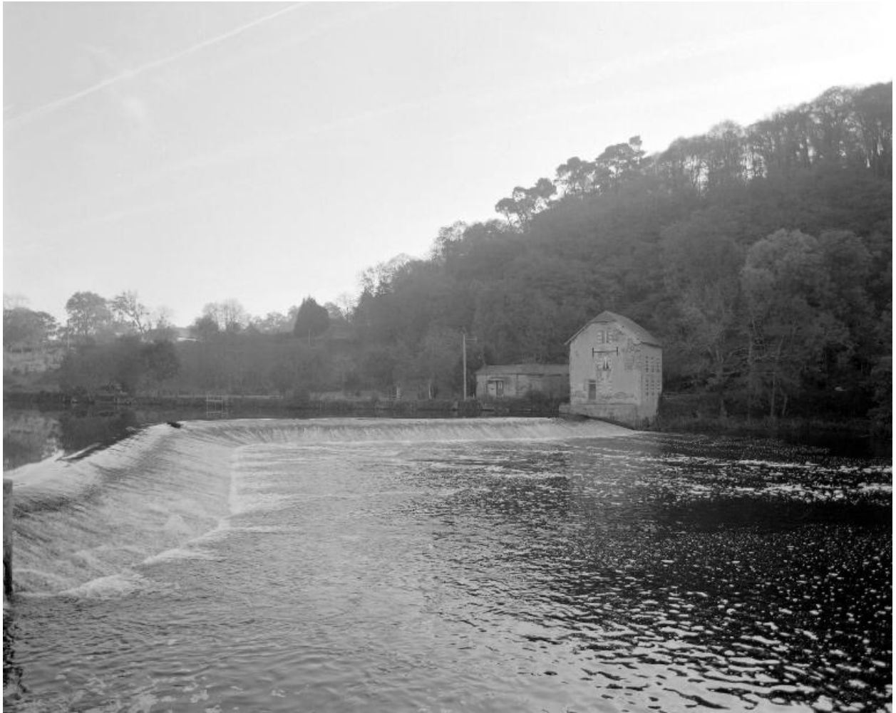
Vue depuis la rive droite : façade nord-ouest.
