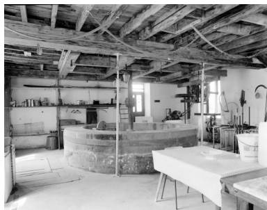
La poquerie qui contenait le mécanisme de transmission du moulin, vue du sud. Phot. François Lasa IVR52_20025300622X
