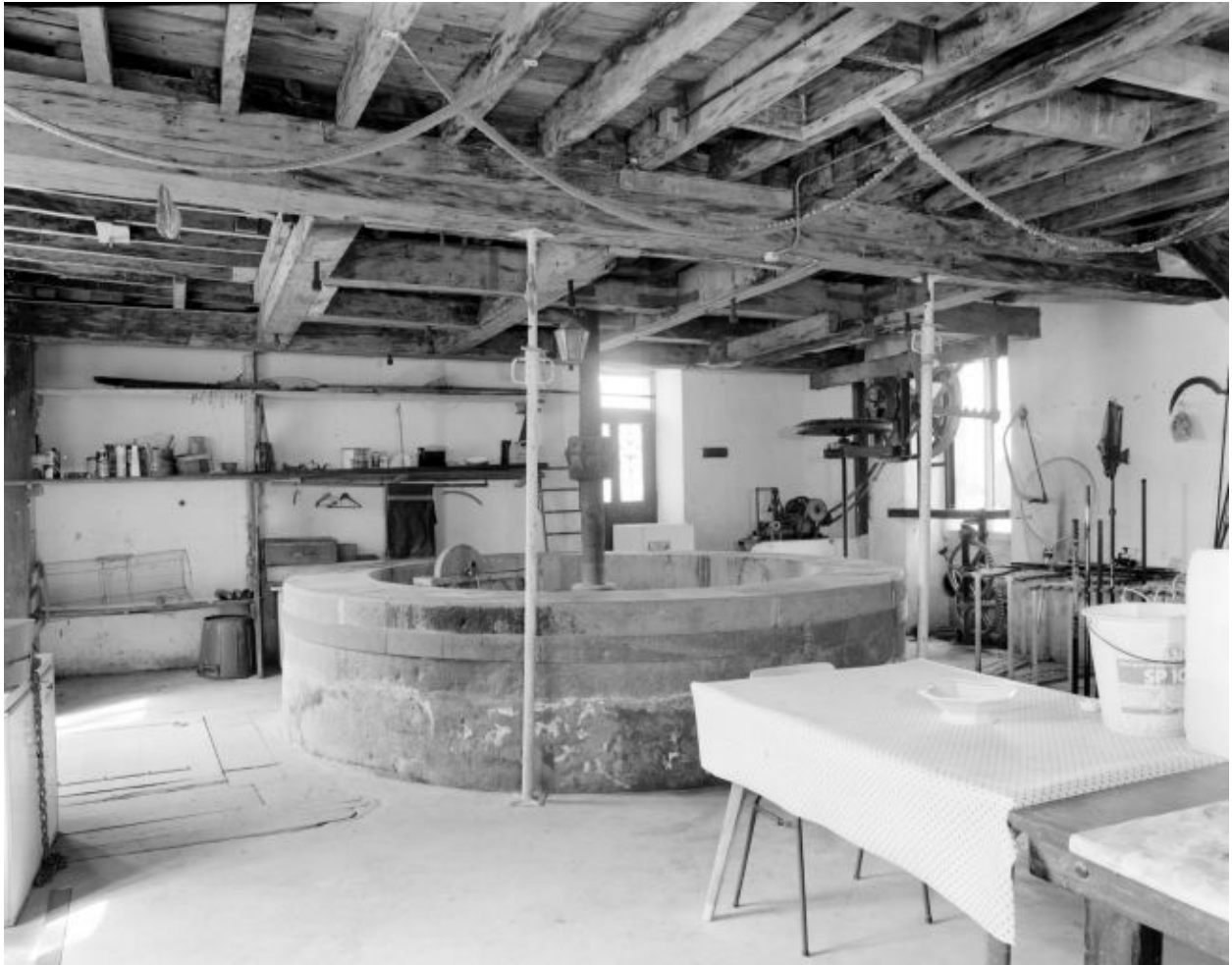
La poquerie qui contenait le mécanisme de transmission du moulin, vue du sud.
