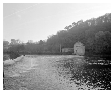
Vue depuis la rive droite : façade nord-ouest. Phot. François Lasa IVR52_20015300532X
