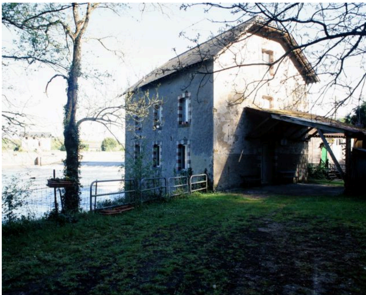
Les façades sud-ouest et sud-est. Au second plan, le barrage et la maison éclusière.
