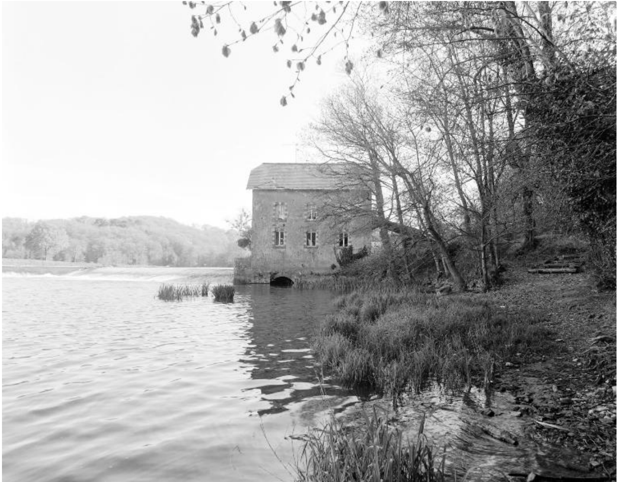
La façade sud-ouest (aval).
