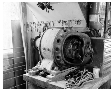
Rez-de-chaussée : générateur électrique. Phot. François Lasa IVR52_20025300624X
