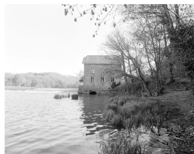
La façade sud-ouest (aval). Phot. François Lasa IVR52_20025300508XB
