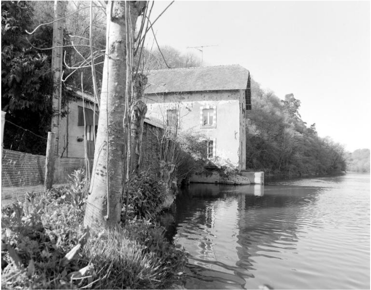
La façade nord-est (amont).
