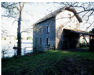
Les façades sud-ouest et sud-est. Au second plan, le barrage et la maison éclusière. Phot. François Lasa IVR52_20025300510XA
