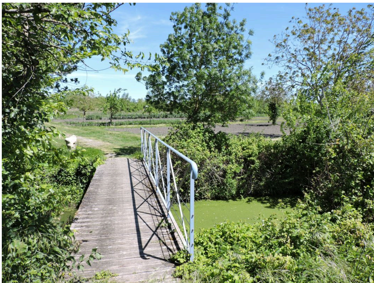
La passerelle vue depuis l'ouest.
