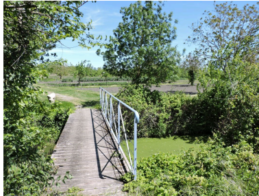
La passerelle vue depuis l'ouest.
