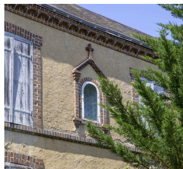
Un détail de la façade et la niche. Phot. Pierre-Bernard Fourny IVR52_20197201640NUCA
