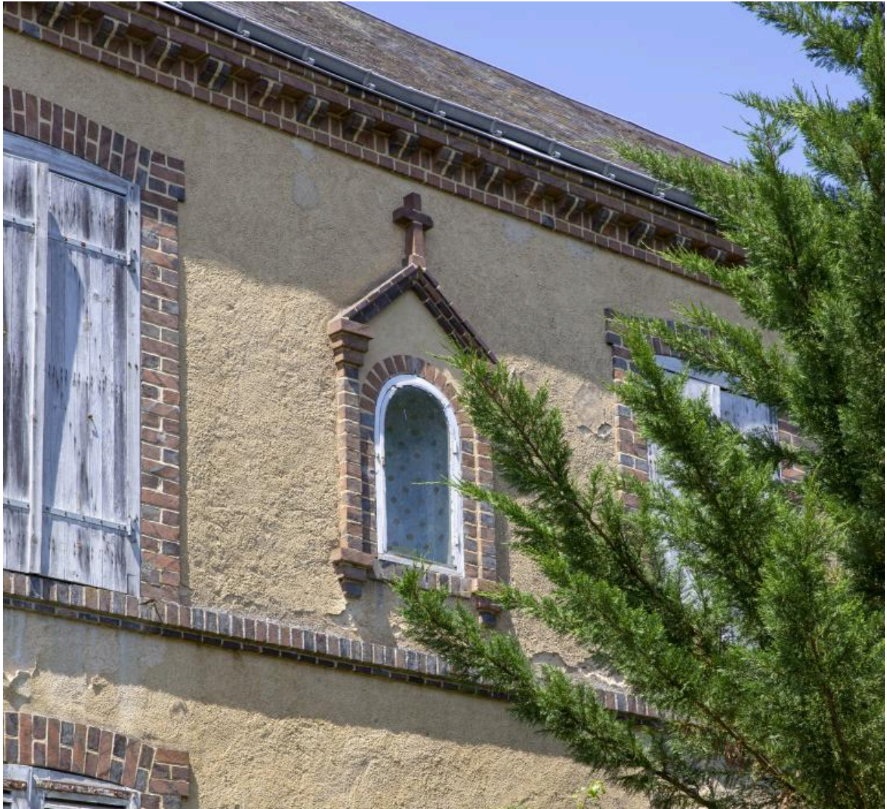
Un détail de la façade et la niche.
