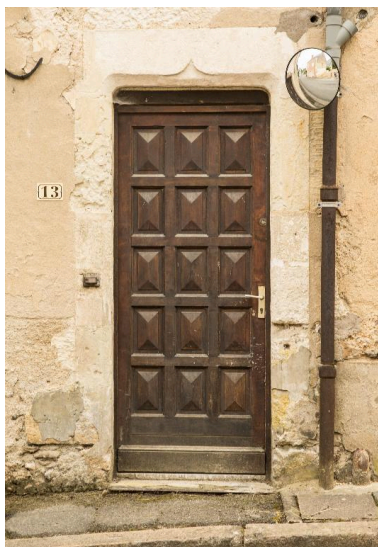
Rez-de-chaussée sur rue, porte surmontée d'une accolade en pierre. Phot. Pierre-Bernard Fourny IVR52_20187200543NUCA
