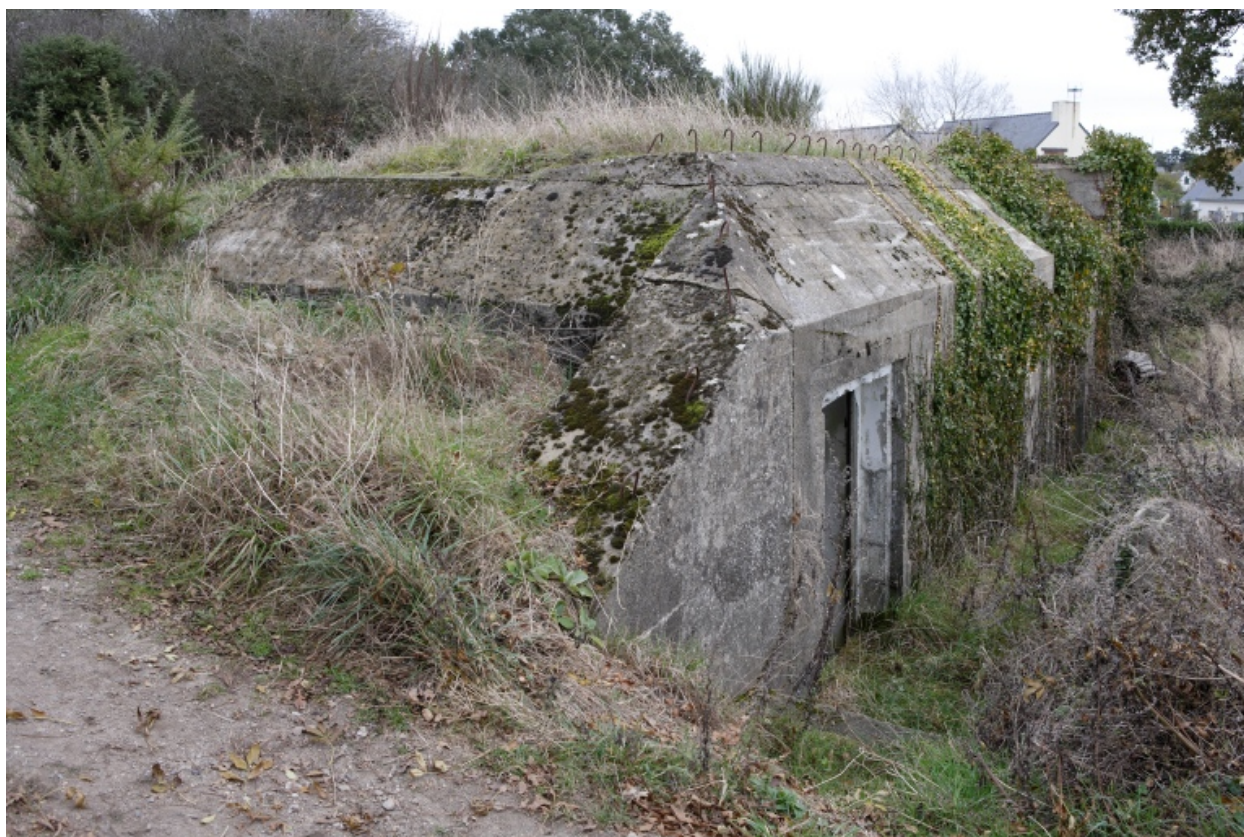
Vue de la casemate de l'abri n° 1 (chemin du Rouelleau).
