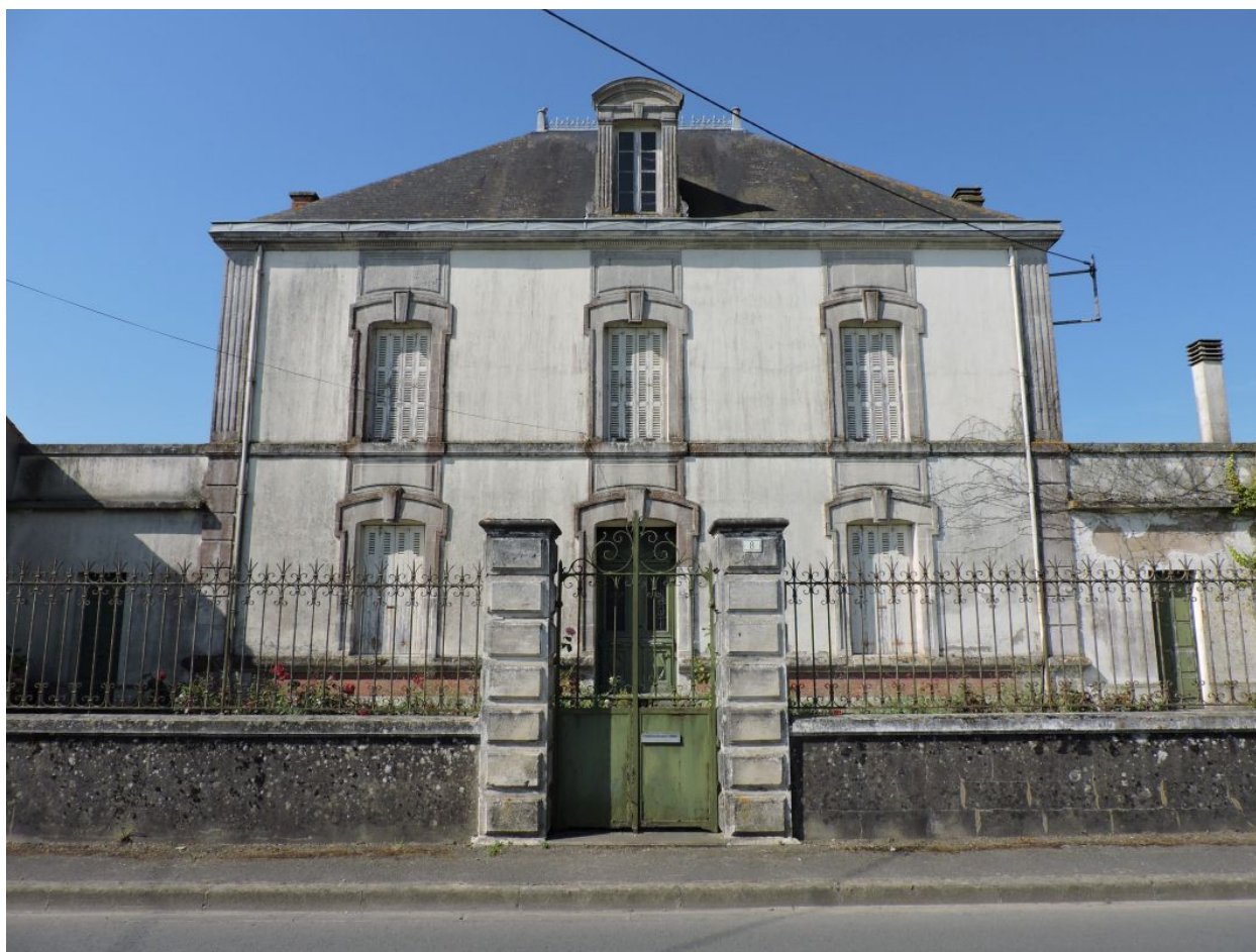
Vue d'ensemble de la façade.
