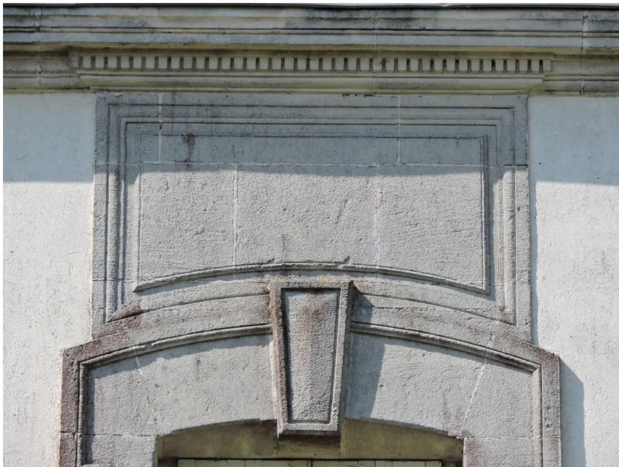
Détail : corniche à denticules, plein de travée appareillé, clé de linteau saillante, encadrement mouluré.
