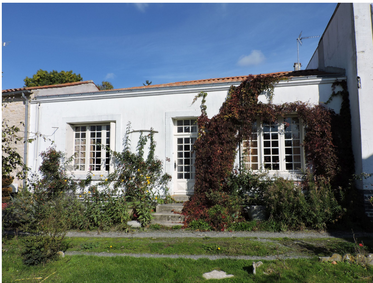
L'aile sud-ouest, vue depuis le sud.
