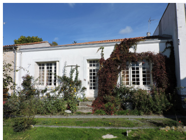
L'aile sud-ouest, vue depuis le sud.
