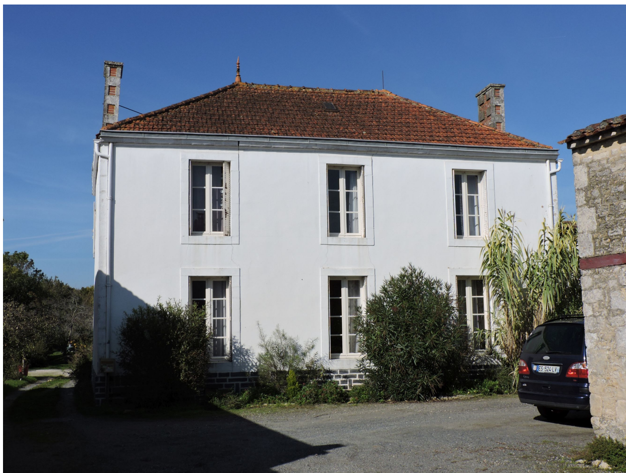
Le corps principal de la maison vu depuis le sud-est.
