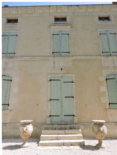
Détail de la façade sud-ouest, côté parc, et de son décor. Phot. Yannis Suire IVR52_20198502466NUCA
