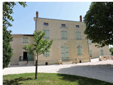
Le logis vu depuis le sud-ouest, côté parc. Phot. Yannis Suire IVR52_20198502464NUCA
