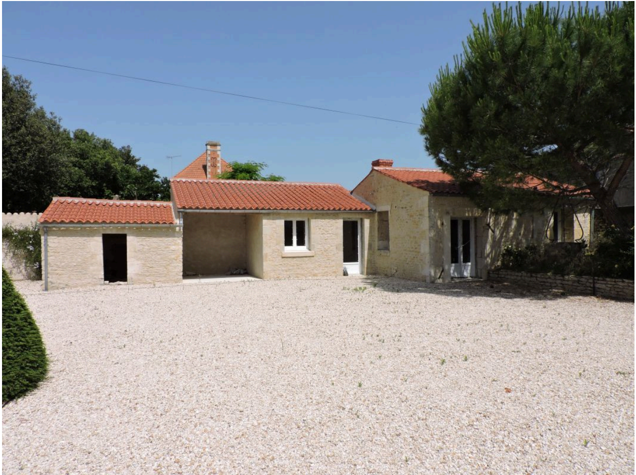
Anciens communs dans l'angle nord de la cour.
