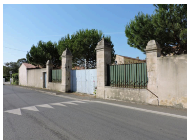
L'entrée de la propriété rue Georges Clemenceau, avec portail, vues depuis le nord. Phot. Yannis Suire IVR52_20198502335NUCA
