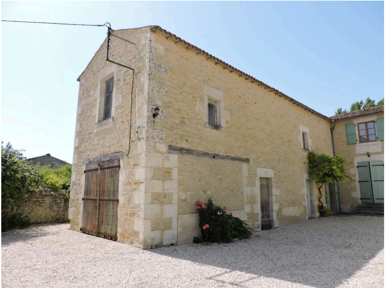
L'aile gauche de communs, ancien garage à voitures à chevaux.
