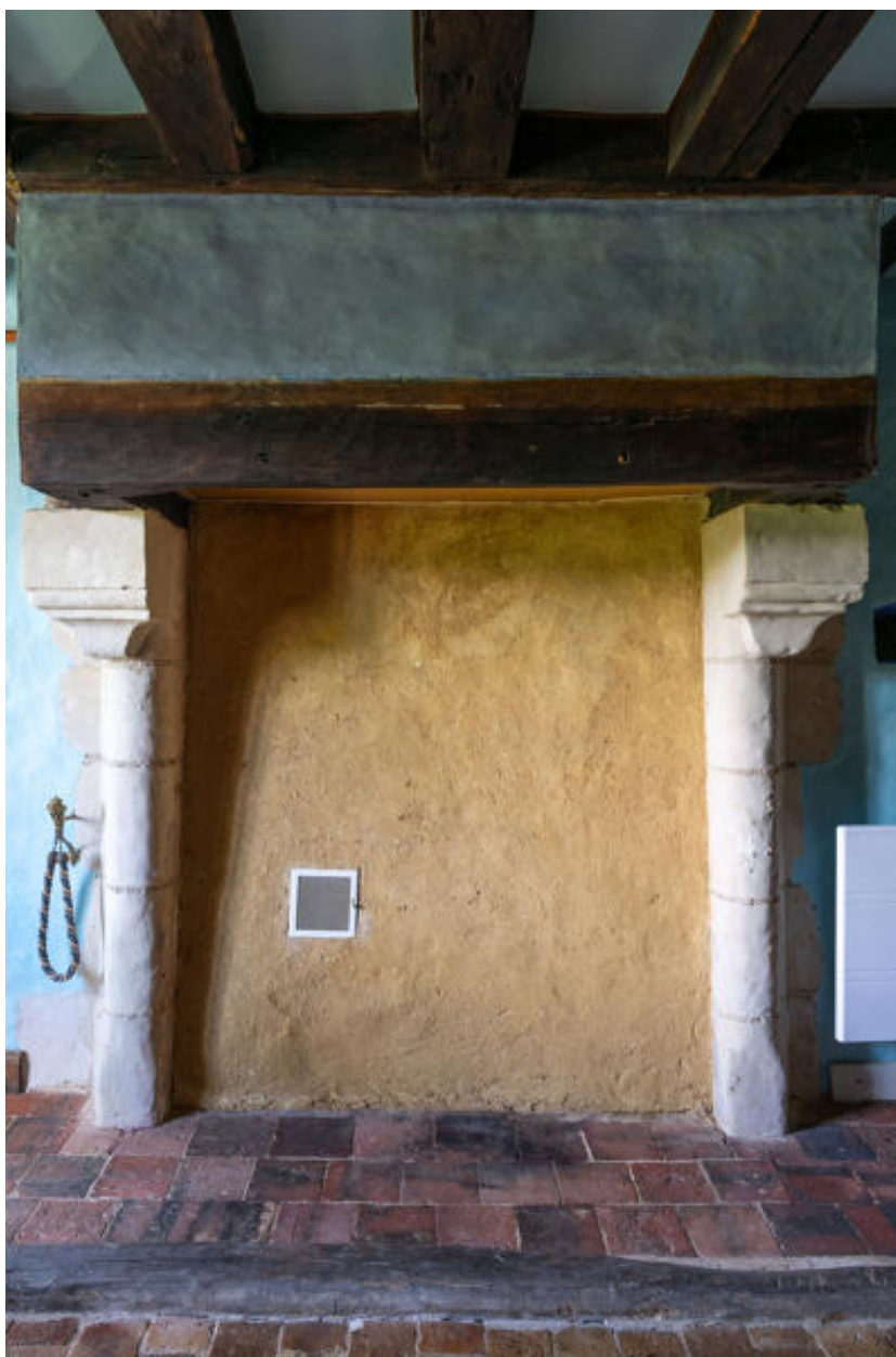
Logis : cheminée de l'étage, pignon ouest.
