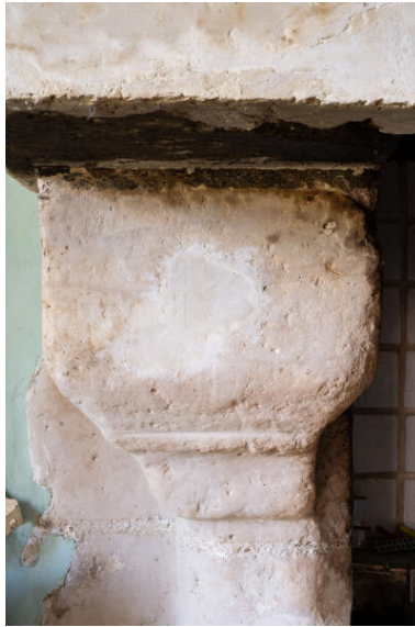
Logis : cheminée du rez-de-chaussée, pignon ouest ; détail de console. Phot. Jeanne Minier IVR52_20257200511NUCA
