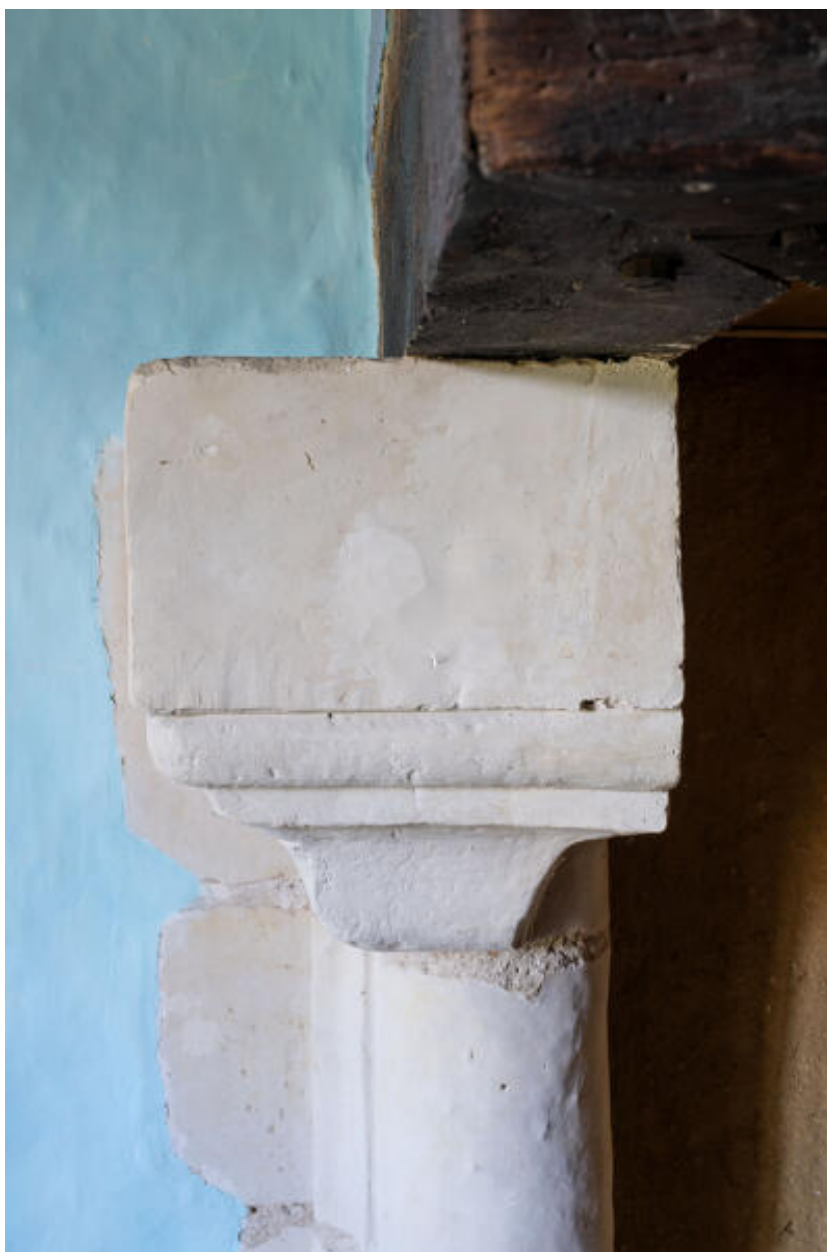
Logis : cheminée de l'étage, pignon ouest ; détail de console.
