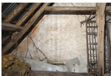
Pignon, côté gauche : traces d'un décor végétal bicolore.
