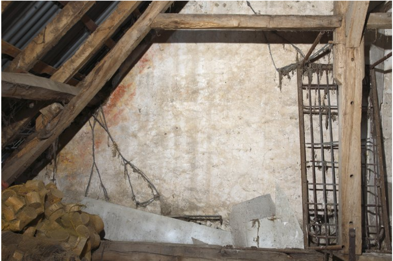
Pignon, côté gauche : traces d'un décor végétal bicolore.
