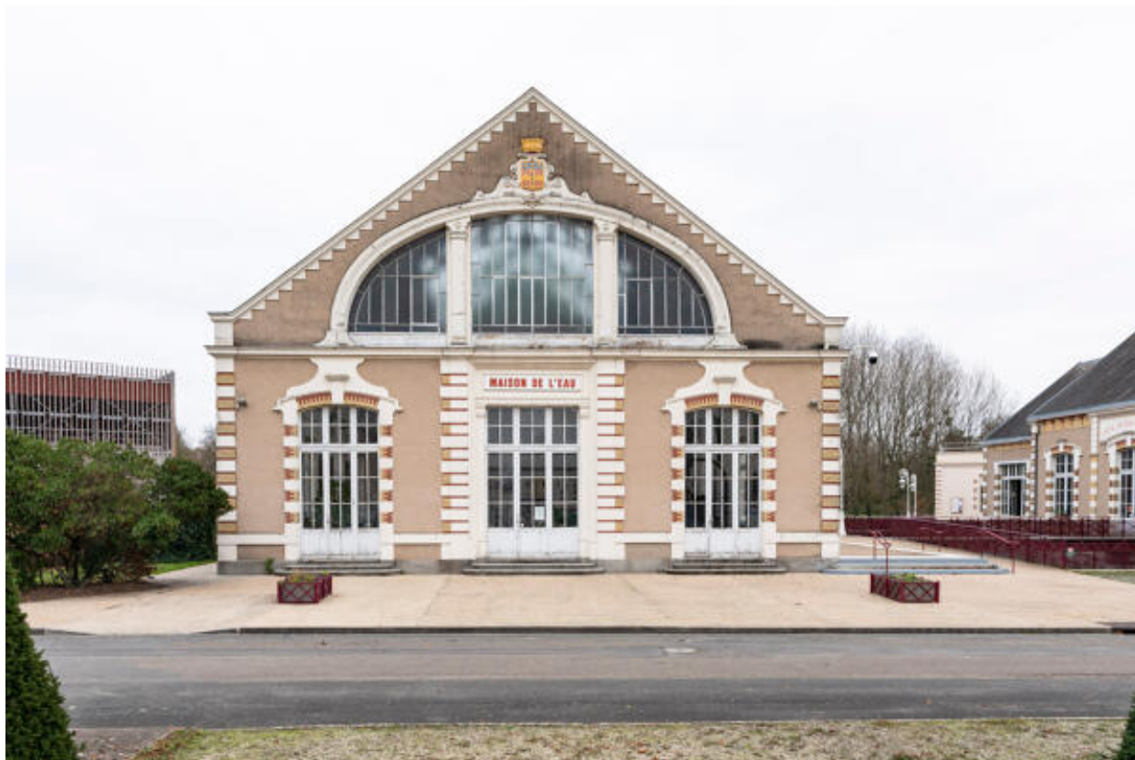
Vue de l'usine des eaux.
