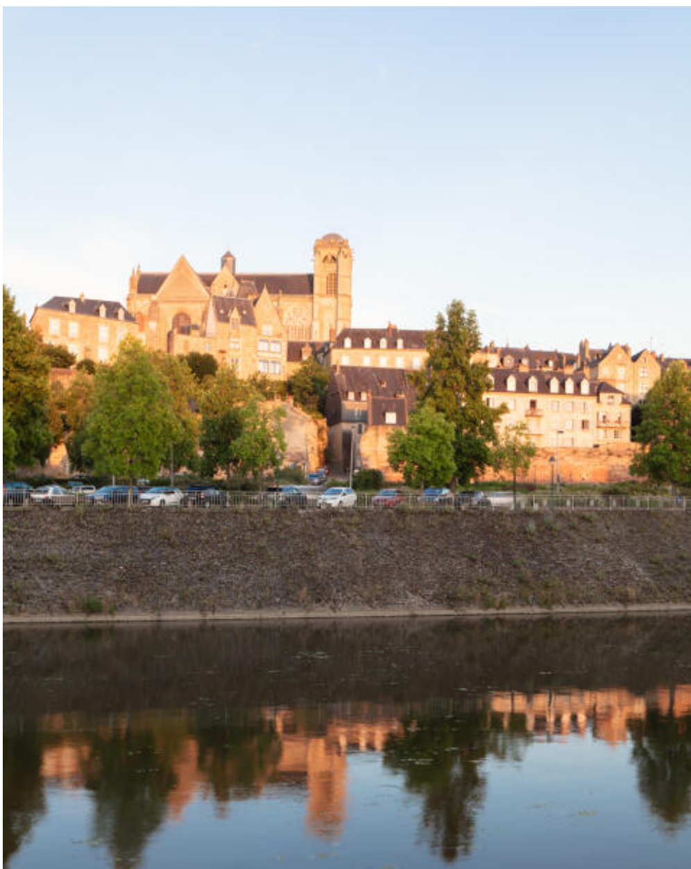
Vue de la ville close depuis la rive ouest de la Sarthe.
