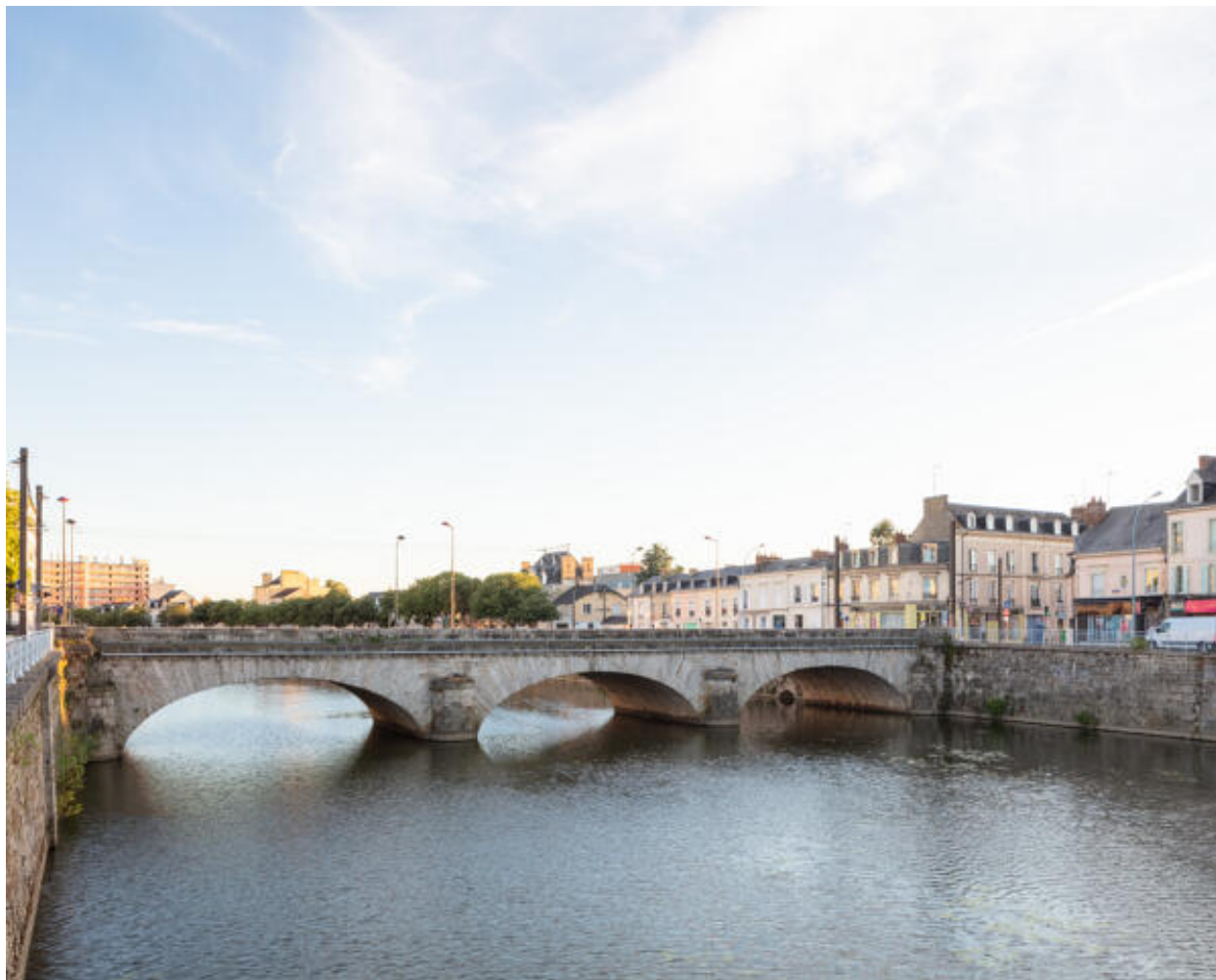
Vue du pont dit Gambetta.
