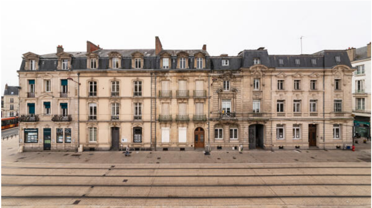
Alignement de maisons, boulevard René-Levasseur.
