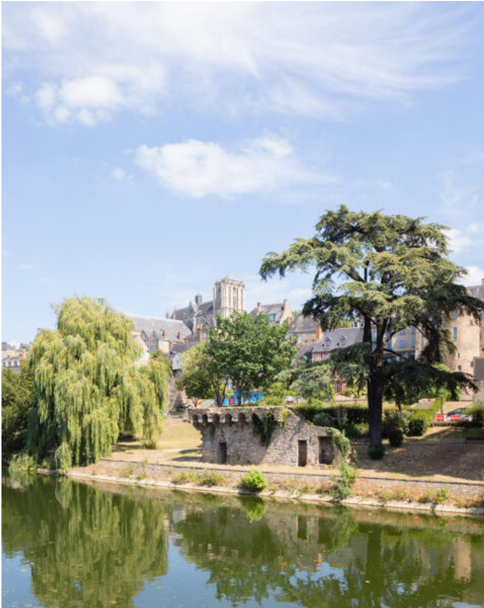
Vue des vestiges de l'enceinte des Tanneries.
