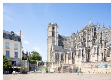
Vue de la cathédrale et du grand escalier depuis la place des Jacobins. Phot. Paul Hamelin IVR52_20227200902NUCA
