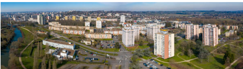
Vue de la Z.U.P. des Sablons.
