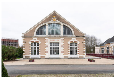
Vue de l'usine des eaux. Phot. Thierry Seldubuisson IVR52_20227201792NUCA
