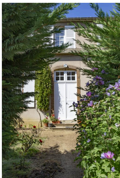
Ancienne mairie de Saint-Georges-du-Plain. Phot. Pierre-Bernard Fourny IVR52_20197202166NUCA
