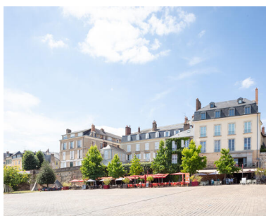
Vue du front bâti surplombant l'enceinte médiévale depuis la place des Jacobins. Phot. Paul Hamelin IVR52_20227200901NUCA
