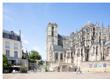
Vue de la cathédrale et du grand escalier depuis la place des Jacobins. Phot. Paul Hamelin IVR52_20227200902NUCA
