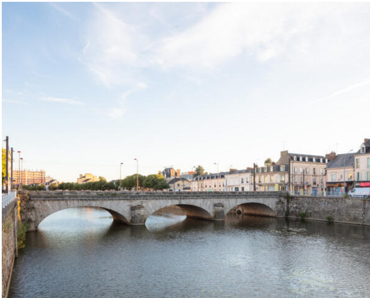
Vue du pont dit Gambetta.
