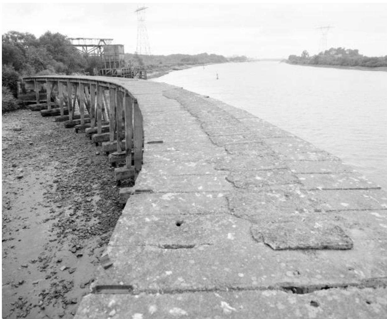
Vue générale de l'estacade amont (état en 1997).
