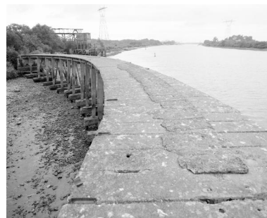
Vue générale de l'estacade amont (état en 1997). Phot. Bernard Renoux IVR52_19974402661X
