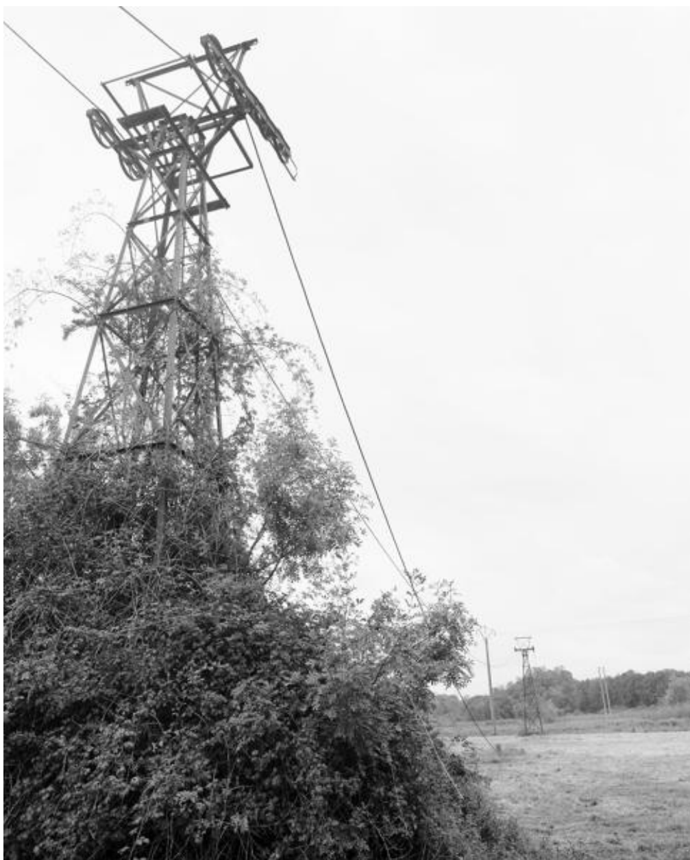
Vue d'ensemble de deux pylônes du transporteur automatique par câbles (état en 1997).
