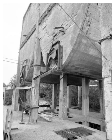
Vue de détail des trémies (état en 1997). Phot. Bernard Renoux IVR52_19974402656X
