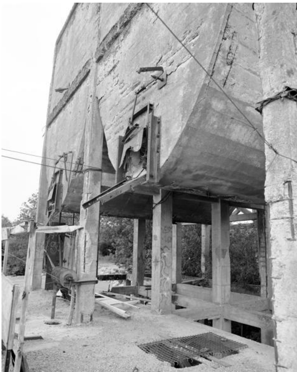
Vue de détail des trémies (état en 1997).
