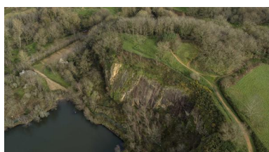
Vue aérienne du front de taille. Phot. Yves Guillotin IVR52_20204400633NUCA
