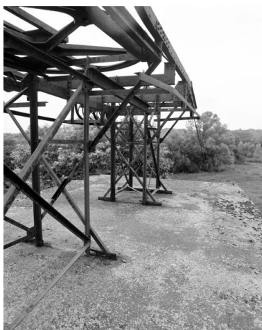
Vue de la jonction entre le câble et le monorail de la station d'arrivée du transporteur automatique (état en 1997). Phot. Bernard Renoux IVR52_19974402659X
