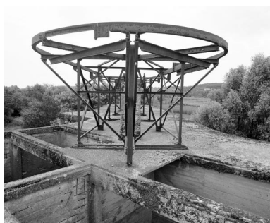
Vue du monorail de la station d'arrivée du transporteur automatique par câbles (état en 1997). Phot. Bernard Renoux IVR52_19974402658X
