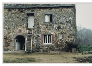
Une photographie avant travaux, façade antérieure, par l'architecte Bouflet, années 1990.
