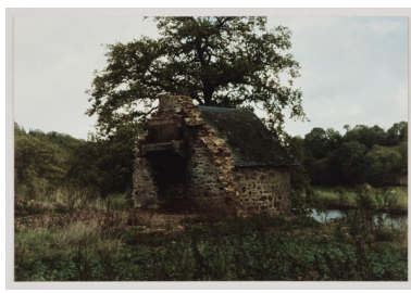
Une photographie avant travaux, four, par l'architecte Bouflet, années 1990.
