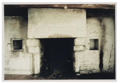
Une photographie avant travaux, cheminée de l'étage, par l'architecte Bouflet, années 1990.
