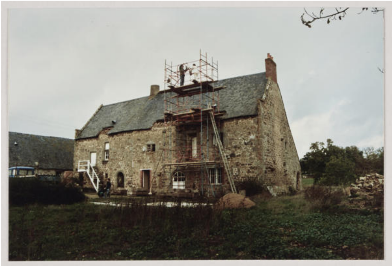
Une photographie avant travaux, façade antérieure, par l'architecte Bouflet, années 1990.
