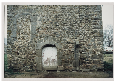
Une photographie avant travaux, pignon ouest, par l'architecte Bouflet, années 1990.
