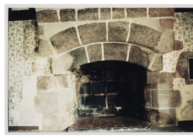
Une photographie avant travaux, cheminée du rez-de-chaussée, par l'architecte Bouflet, années 1990.
