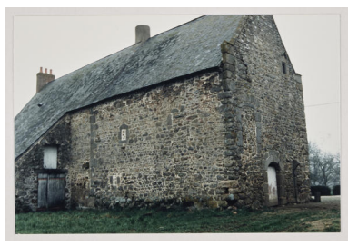
Une photographie avant travaux, façade postérieure, par l'architecte Bouflet, années 1990.
