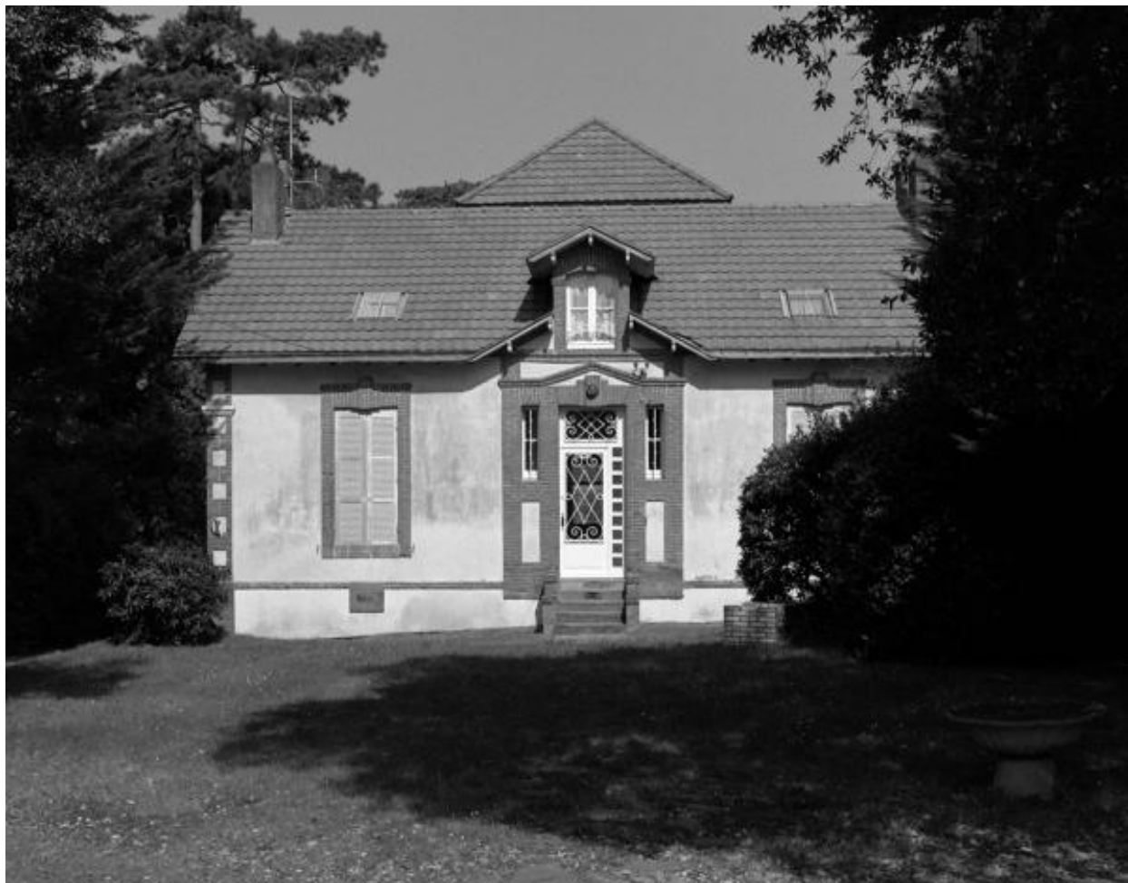
Villa le Vallon, élévation sud-est sur rue.
