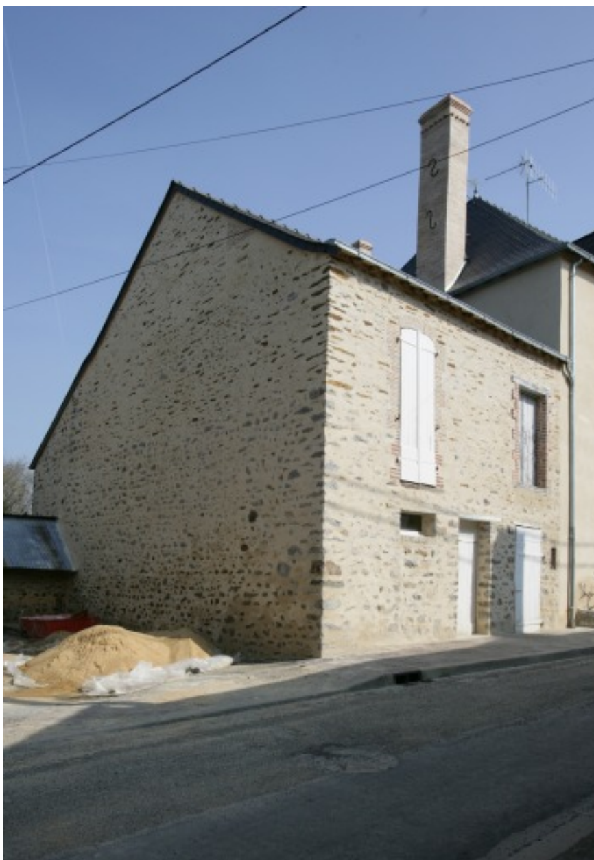
Vue depuis la rue, après les travaux de ravalement.
