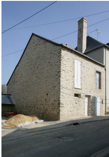
Vue depuis la rue, après les travaux de ravalement. Phot. François Lasa IVR52_20055301027NUCA
