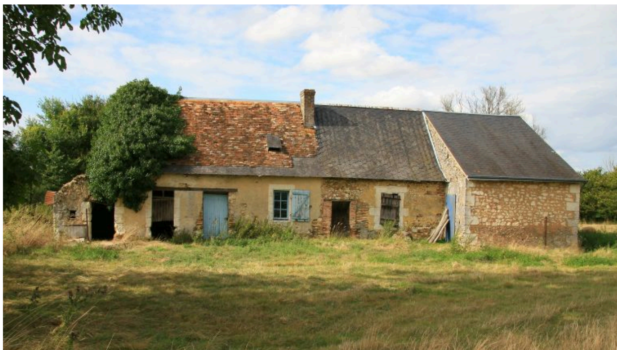
Maison n° 1 : façade sur cour.
