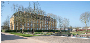
Vue du bâtiment principal de la caserne Chanzy. Phot. Pierre-Bernard Fourny IVR52_20197200439NUCA
