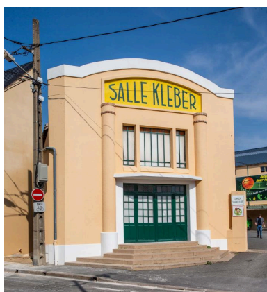
Vue de la salle Kléber. Phot. Pierre-Bernard Fourny IVR52_20197200546NUCA
