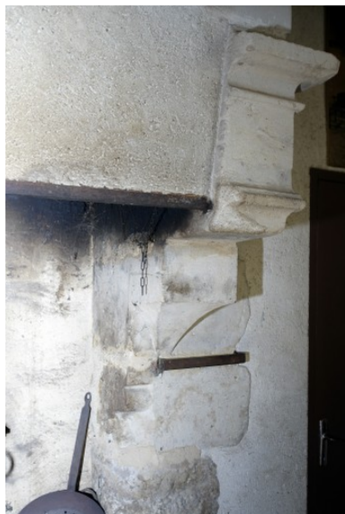
Détail de la cheminée : le corbeau droit. Phot. François Lasa IVR52_20075301413NUCA
