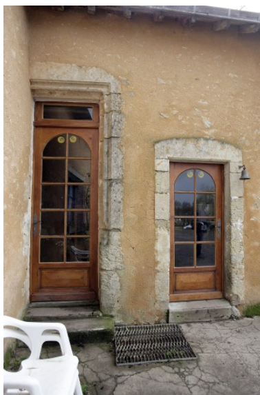
Détail de l'élévation ouest du logis : la porte et la fenêtre. Phot. François Lasa IVR52_20075301414NUCA
