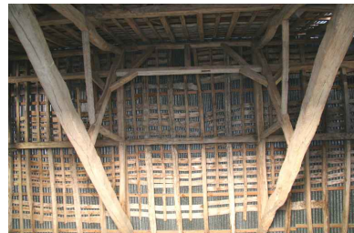
la grange-étable : travée centrale de la charpente. Phot. Jean-Baptiste Darrasse IVR52_20067205696NUCA
