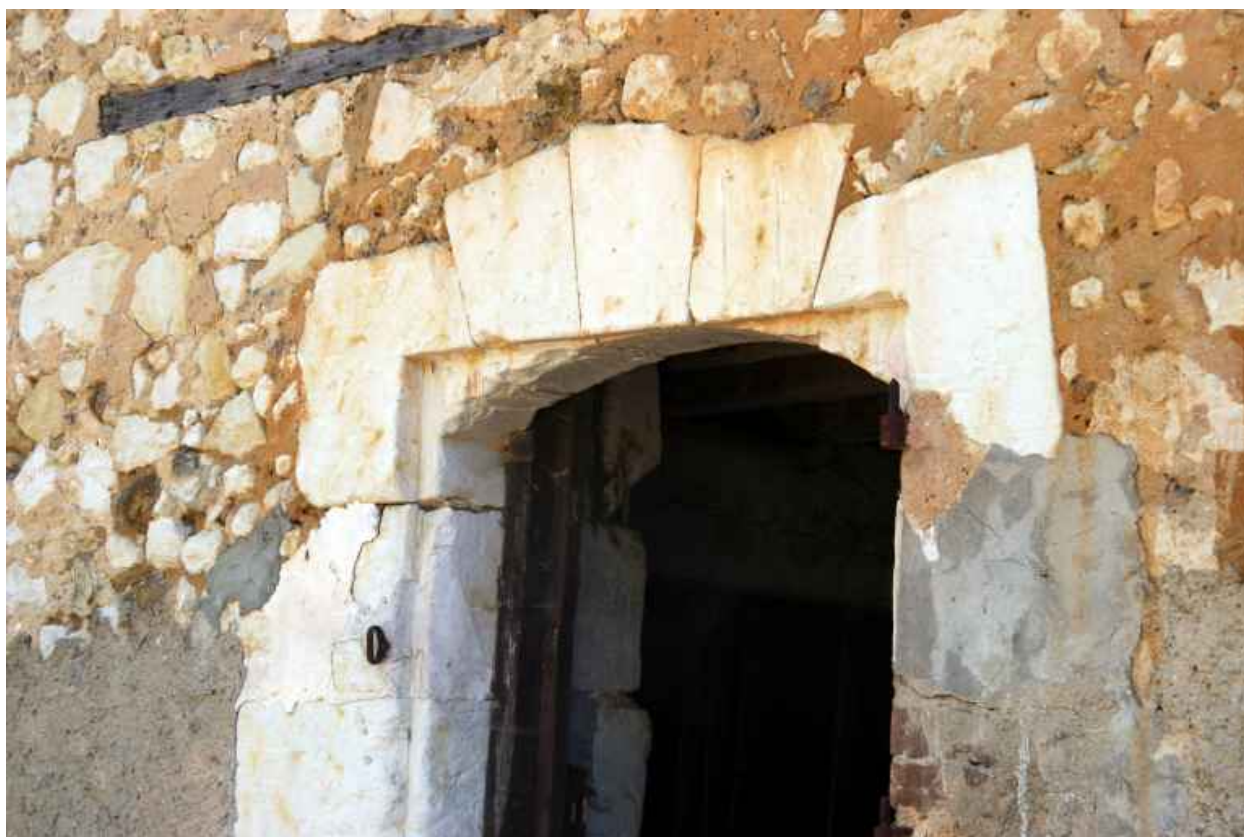
La grange-étable : détail du linteau remanié.
