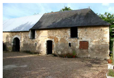
La grange-étable : partie la plus ancienne. Phot. Jean-Baptiste Darrasse IVR52_20067205709NUCA
