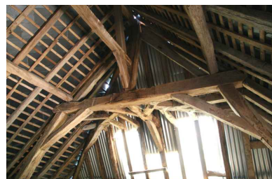
La grange-étable : la croupe de la charpente. Phot. Jean-Baptiste Darrasse IVR52_20067205702NUCA
