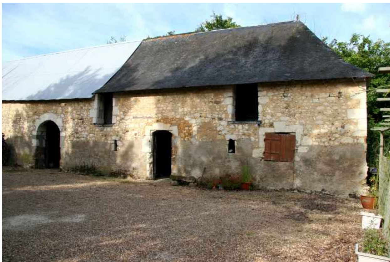
La grange-étable : partie la plus ancienne.
