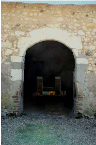
La grange-étable : porte de la grange. Phot. Jean-Baptiste Darrasse IVR52_20067205708NUCA
