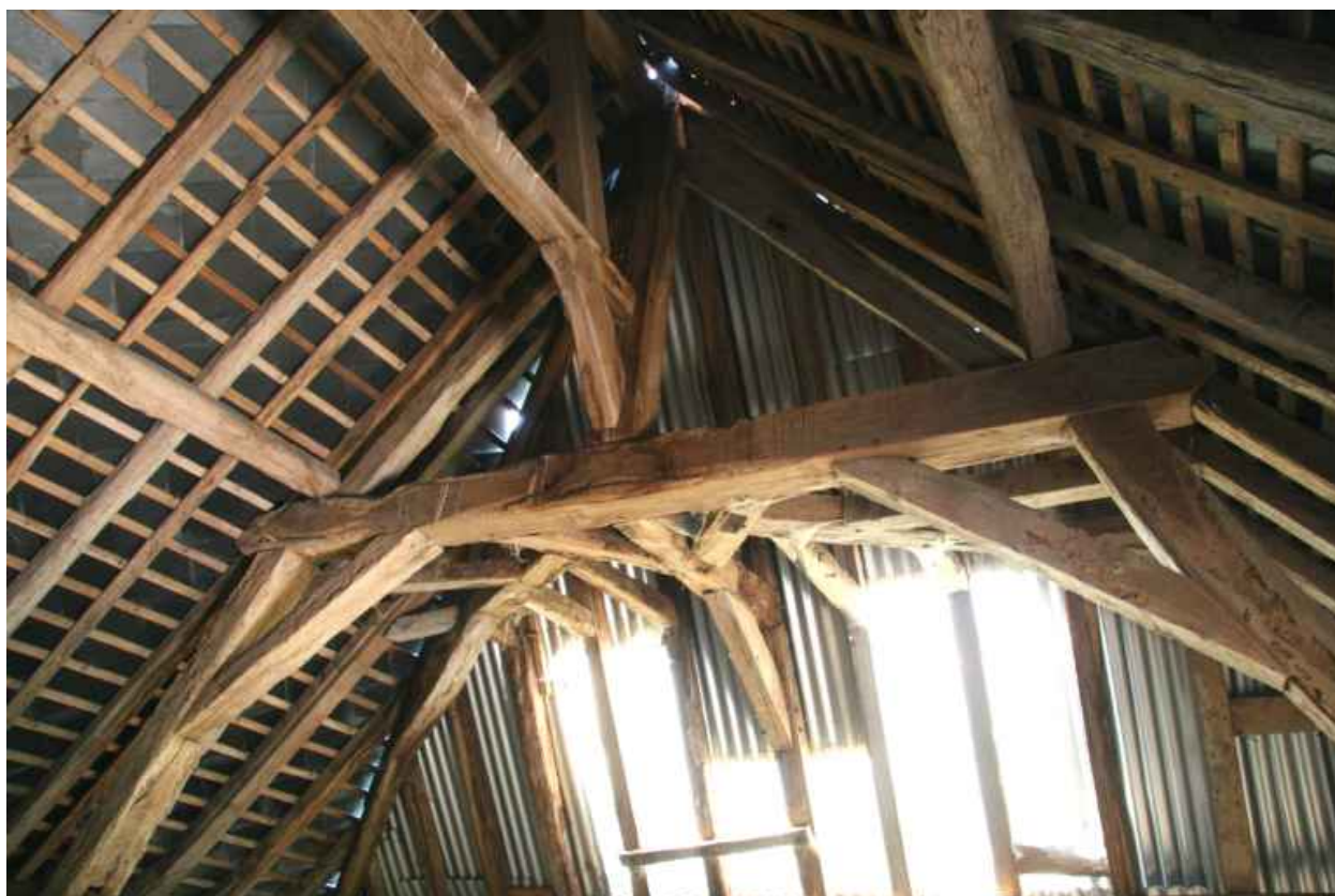
La grange-étable : la croupe de la charpente.
