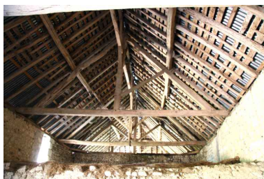
La grange-étable : la charpente. Phot. Jean-Baptiste Darrasse IVR52_20067205698NUCA
