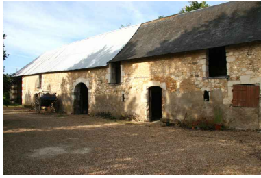
La grange-étable : détail de la façade. Phot. Jean-Baptiste Darrasse IVR52_20067205710NUCA
