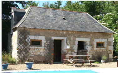
Bâtiment dits des soues à cochons (fin XIXe s.). Phot. Jean-Baptiste Darrasse IVR52_20067205695NUCA
