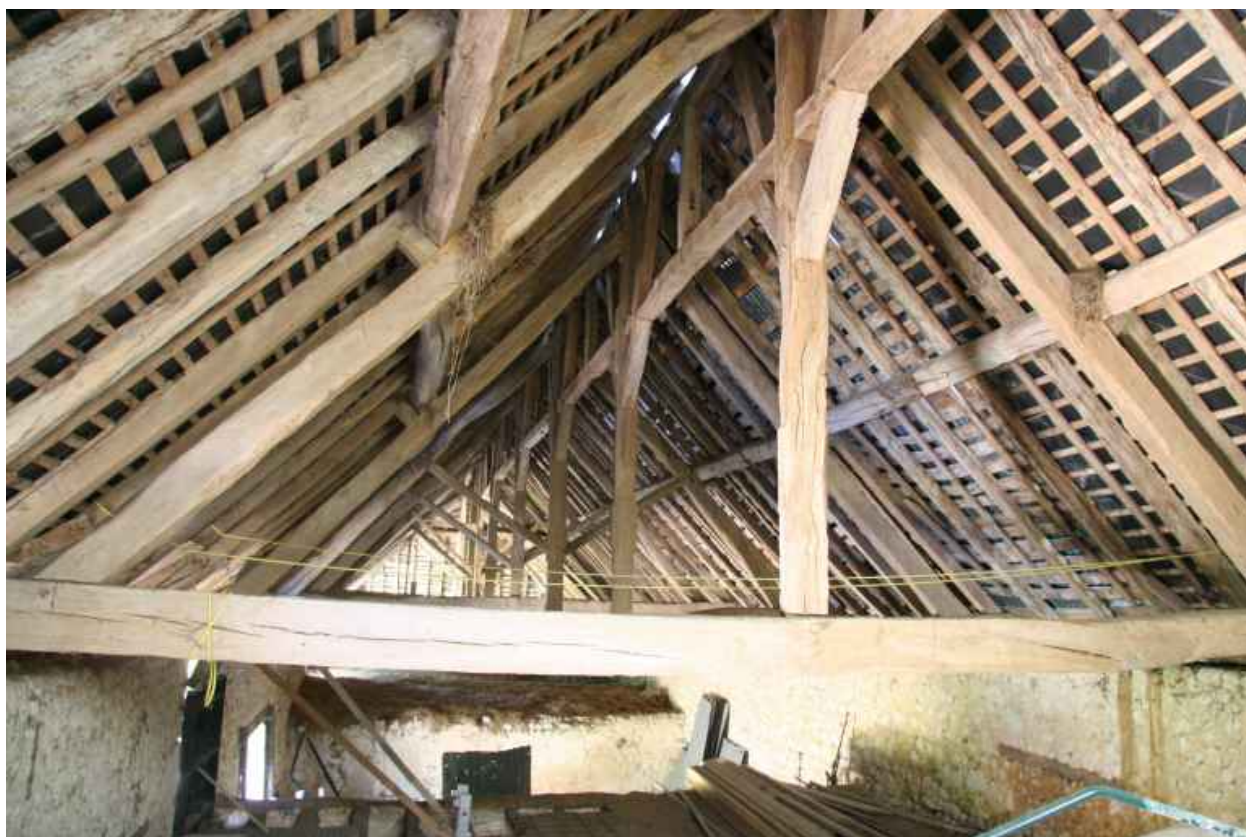
La grange-étable : vue d'ensemble de la charpente.
