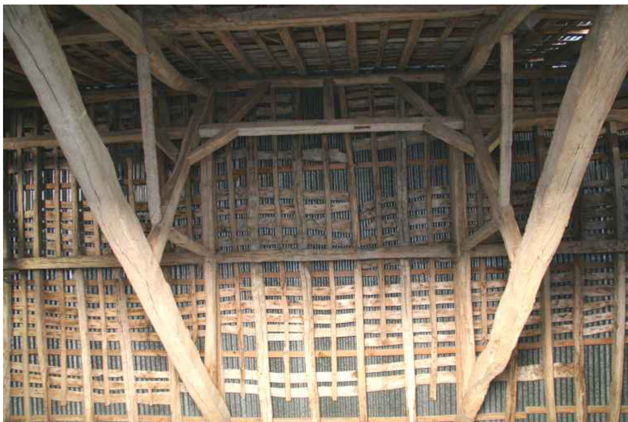
la grange-étable : travée centrale de la charpente.
