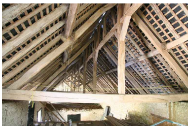
La grange-étable : vue d'ensemble de la charpente. Phot. Jean-Baptiste Darrasse IVR52_20067205697NUCA
