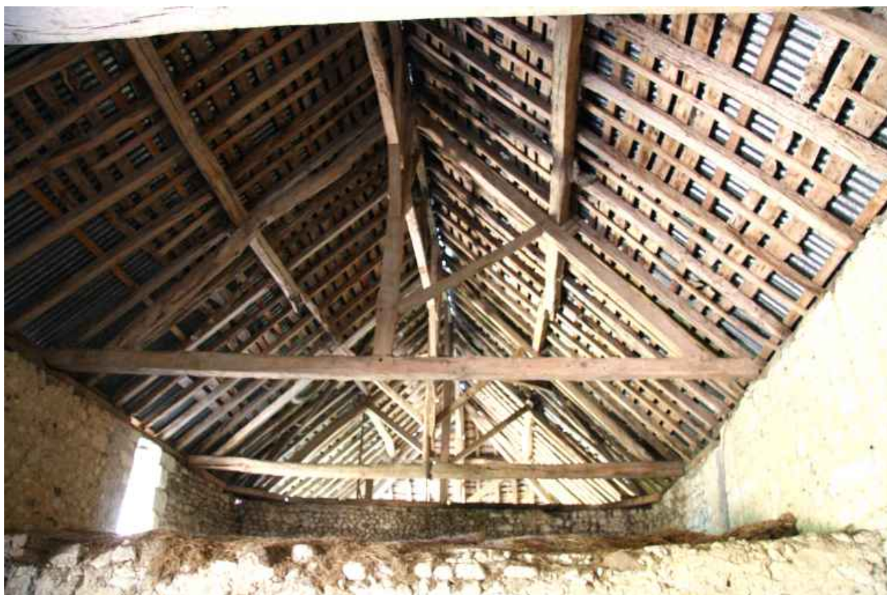
La grange-étable : la charpente.
