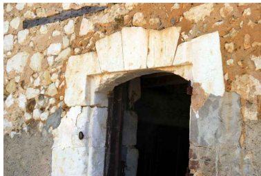
La grange-étable : détail du linteau remanié. Phot. Jean-Baptiste Darrasse IVR52_20067205703NUCA
