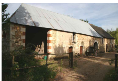
La grange-étable. Phot. Jean-Baptiste Darrasse IVR52_20067205711NUCA
