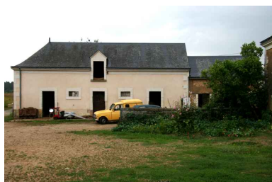
Aile gauche des dépendances : vestiges de la ferme antérieure à 1811. Phot. Jean-Baptiste Darrasse IVR52_20067206476NUCA
