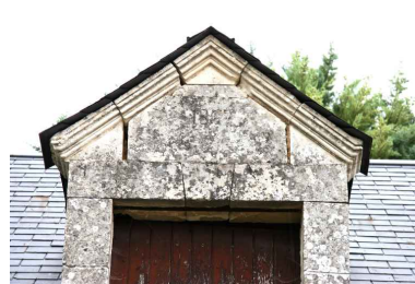
Aile droite des dépendances, lucarne portant la date 1867. Phot. Jean-Baptiste Darrasse IVR52_20067206471NUCA
