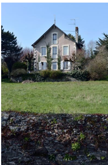
Maison dite le Chalet, 13 rue de la Noë. Phot. Bruno Rousseau IVR52_20164900205NUCA
