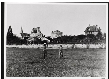
Vue du quai de la Noë. La villa Les Marguerites (à gauche) et Le Chalet (à droite). Photographie. Vers 1900. Repro. Armelle Maugin IVR52_20194900684NUCA
