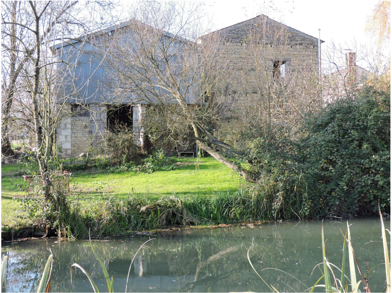
Les dépendances ouvrant sur la rivière, vues depuis le sud-est.
