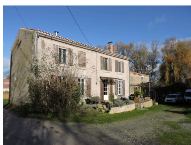
Le logis et le logement dans son prolongement, à droite, vus depuis le sud-ouest. Phot. Yannis Suire IVR52_20218500883NUCA
