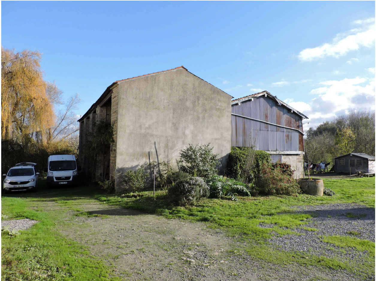
Les dépendances au sud de la cour, vues depuis l'ouest.
