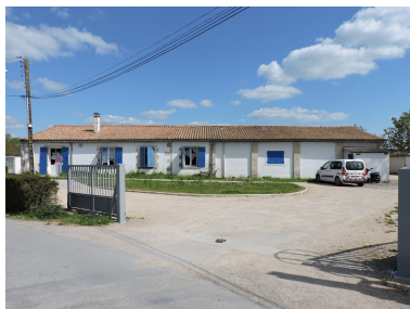
La maison éclésièrre vue depuis l'ouest. Phot. Yannis Suire IVR52_20218501885NUCA
