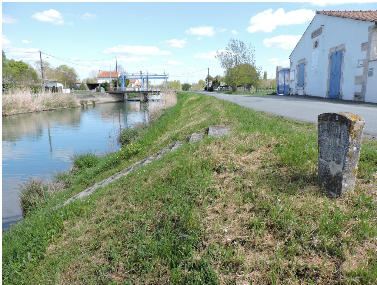
Ancien escalier et emplacement du barrage, au droit de la maison éclésièrre, avant son déplacement en amont.
