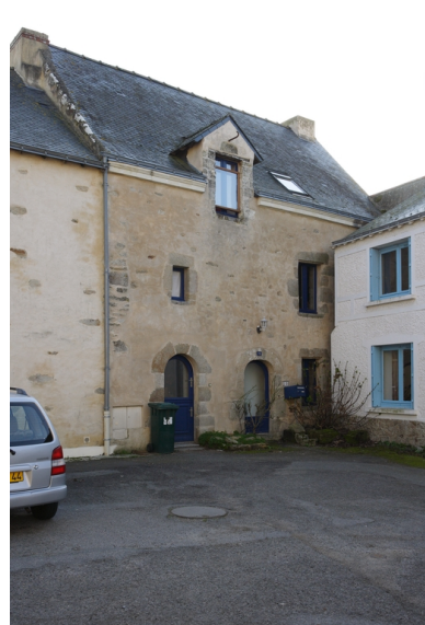
Vue du n° 13 rue François-Thuard. Phot. Denis Pillet IVR52_20084400384NUCA
