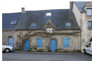
Vue du n° 9 rue François-Thuard. Phot. Denis Pillet IVR52_20084400235NUCA
