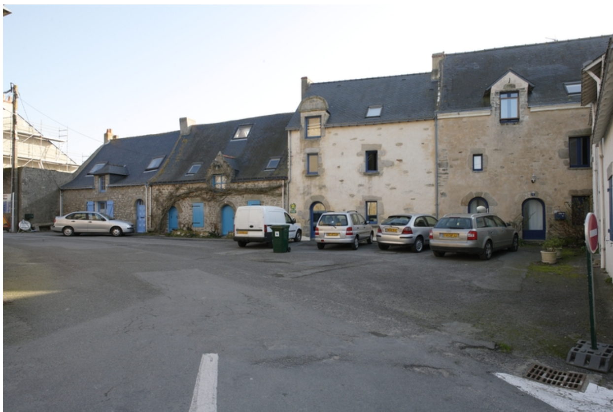
Vue d'ensemble de la rangée depuis l'ouest.
