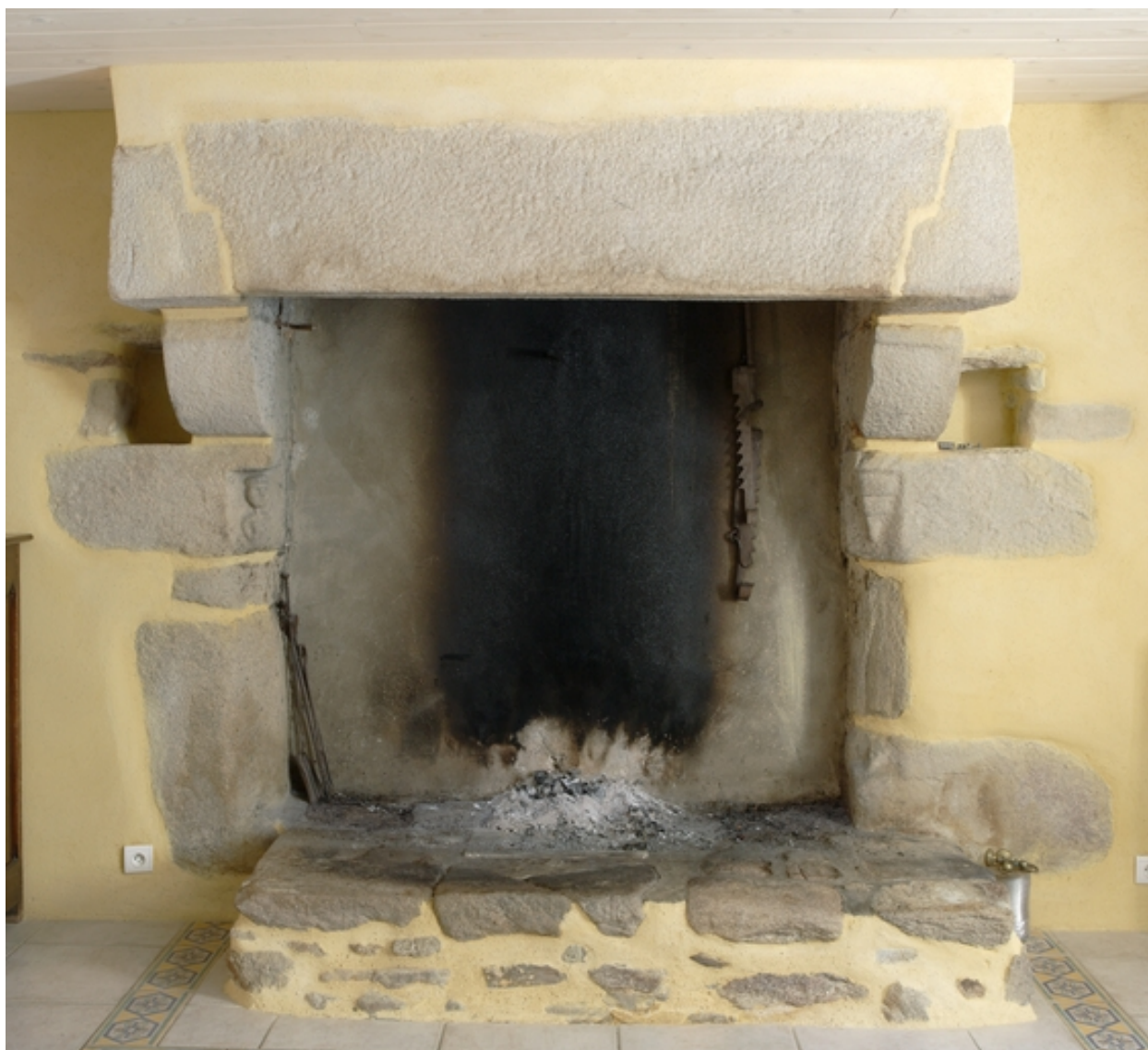
Logis n° 11 rue François-Thuard. Rez-de-chaussée. Cheminée.
