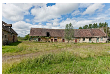
Vue générale depuis l'est. Phot. Yves Guillotin IVR52_20137200491NUCA
