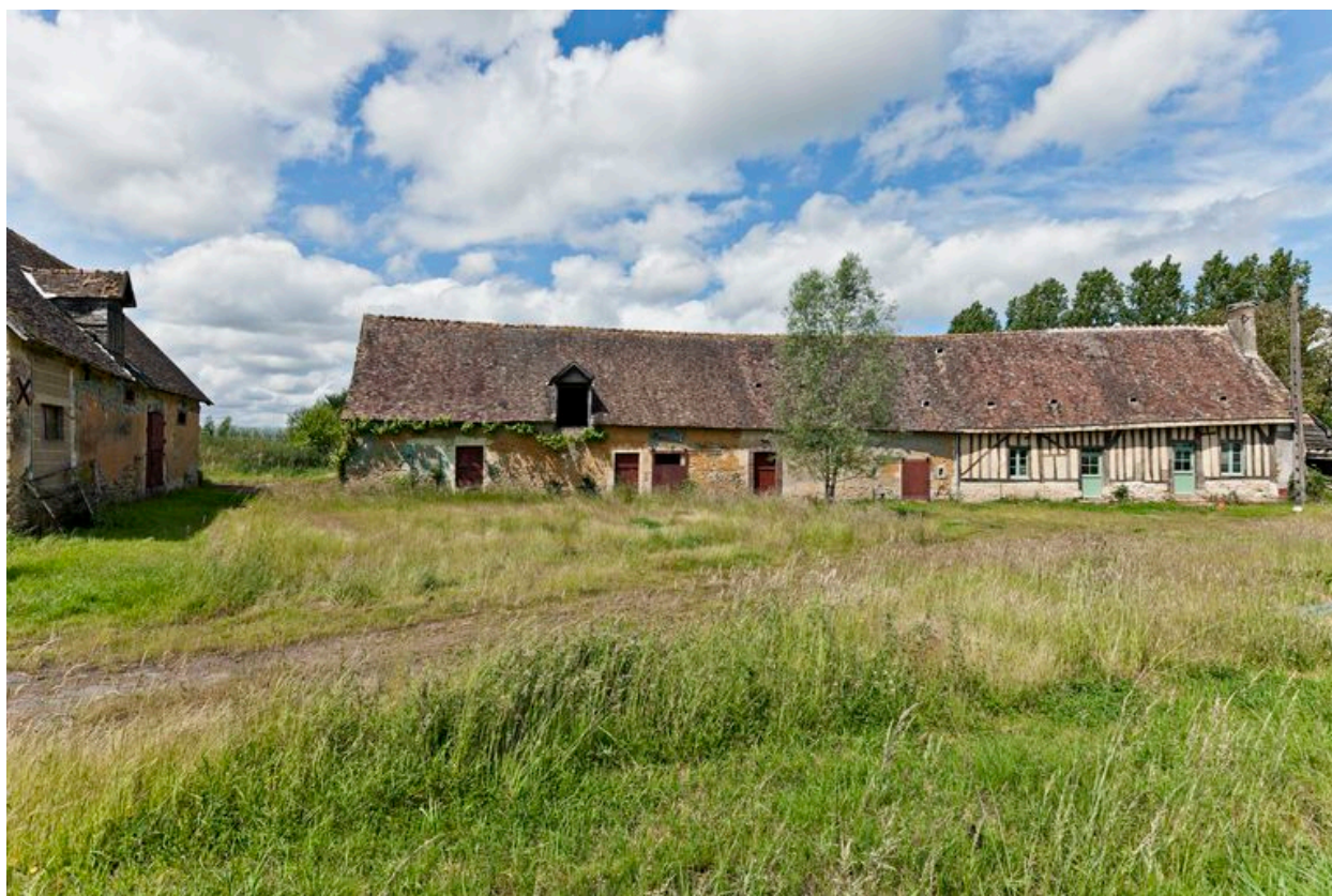
Vue générale depuis l'est.
