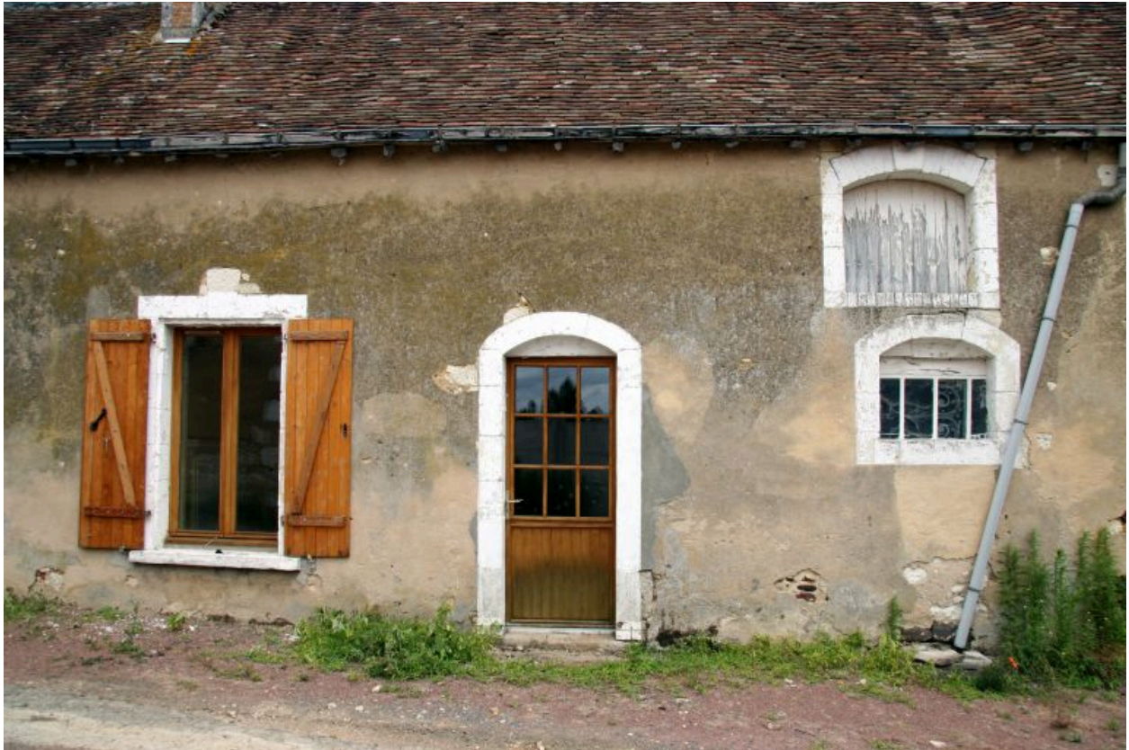
Maison 4 ; baies aux linteaux délardés.
