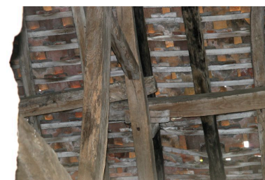
Maison 2 : charpente à pannes. Phot. Jean-Baptiste Darrasse IVR52_20057202622NUCA
