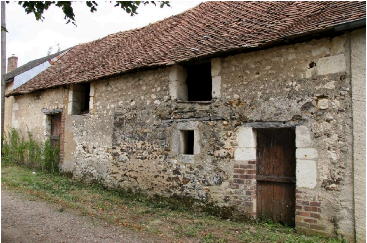
Maison 2 : ancienne maison (pierres noires) transformée en dépendance avec grenier rehaussé en fenil.
