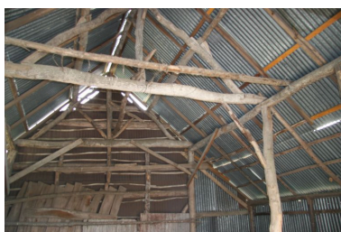
Hangar : charpente. Phot. Jean-Baptiste Darrasse IVR52_20057202623NUCA
