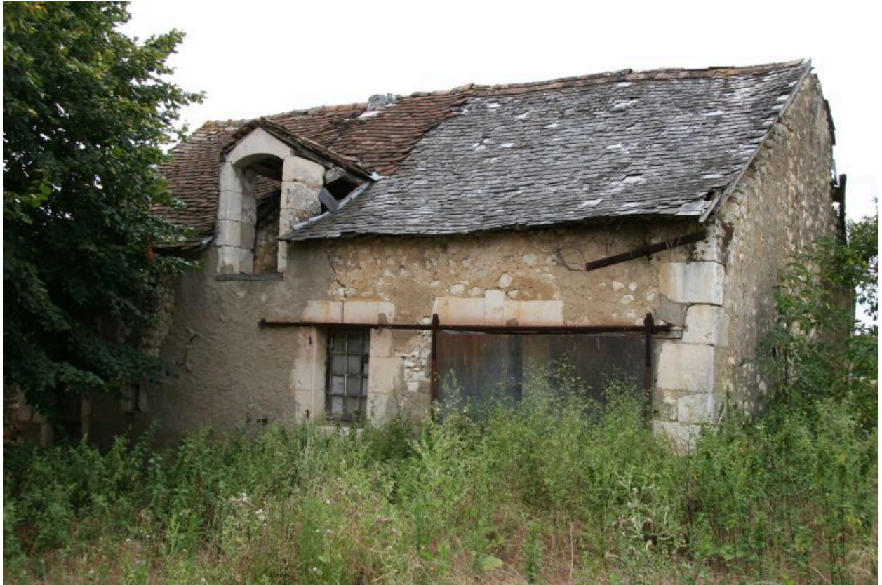
Maison 1 : façade sur cour.
