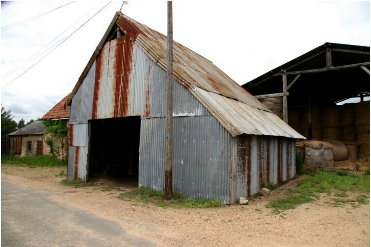
Hangar en bois aujourd'hui recouvert de tôles.
