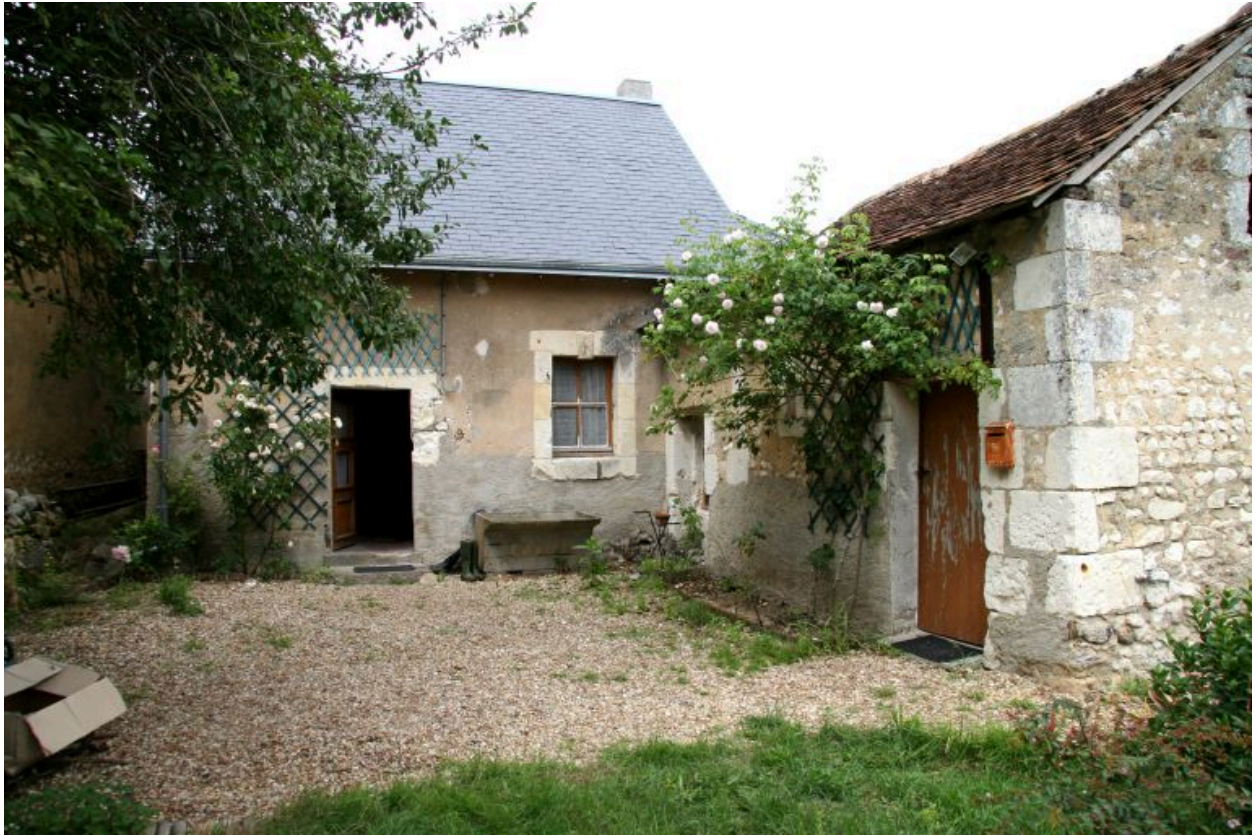
Maison 3 : façade sur cour.
