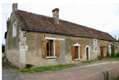
Maison 4 : façade sur rue. Phot. Jean-Baptiste Darrasse IVR52_20057202626NUCA
