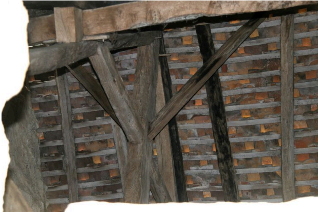
Maison 2 : charpente à pannes.
