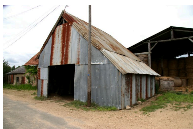
Hangar en bois aujourd'hui recouvert de tôles. Phot. Jean-Baptiste Darrasse IVR52_20057202624NUCA
