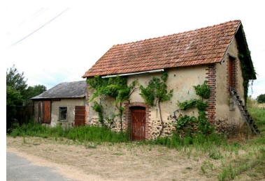
Cellier avec grenier construit dans les années 1900. Phot. Jean-Baptiste Darrasse IVR52_20057202625NUCA
