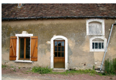
Maison 4 ; baies aux linteaux débardés. Phot. Jean-Baptiste Darrasse IVR52_20057202627NUCA
