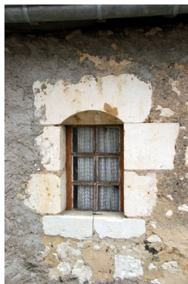
Maison 3 : petite fenêtre au linteau débardé sur la façade postérieure. Phot. Jean-Baptiste Darrasse IVR52_20057202633NUCA
