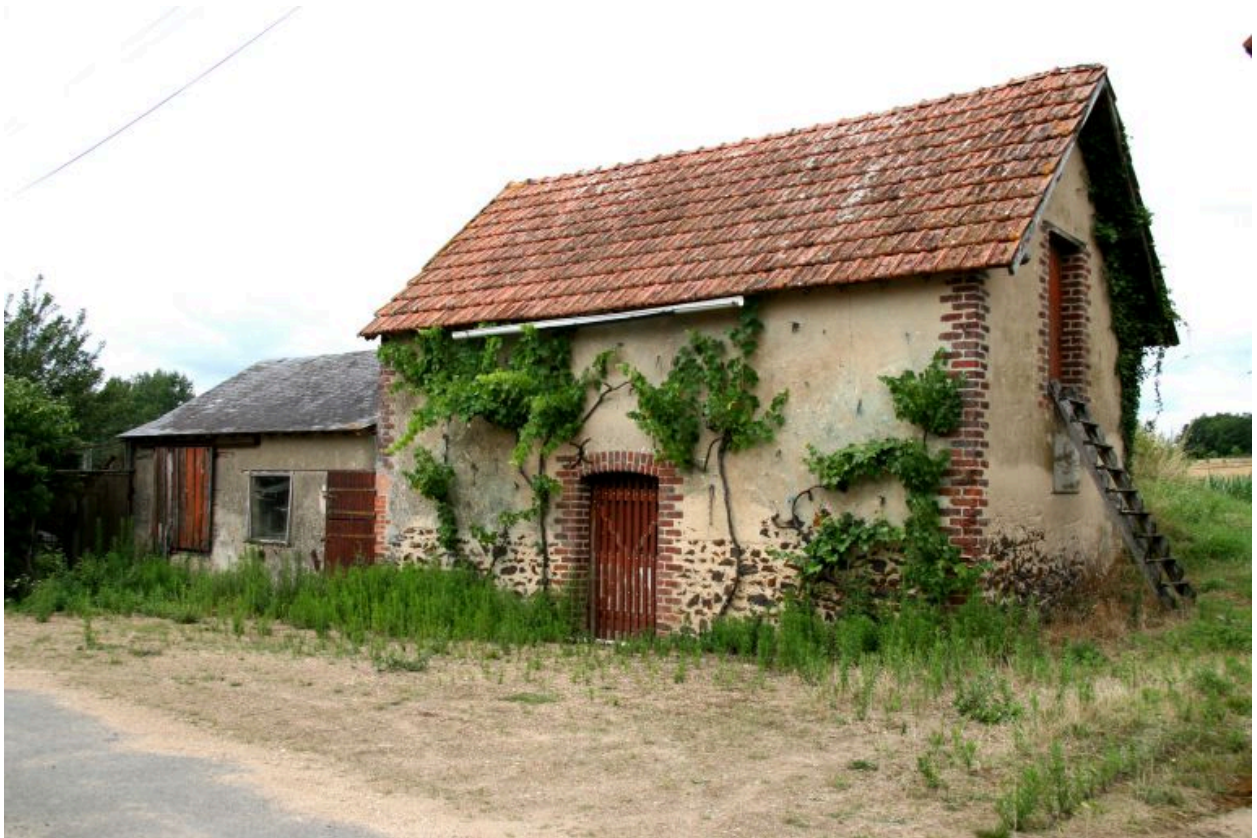
Cellier avec grenier construit dans les années 1900.
