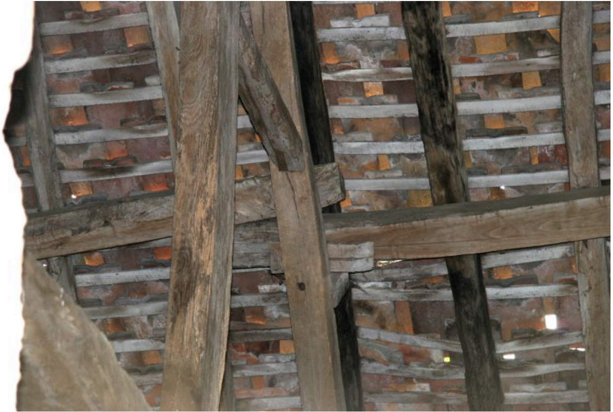
Maison 2 : charpente à pannes.
