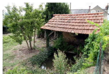
Lavoir ? Phot. Jean-Baptiste Darrasse IVR52_20057202634NUCA
