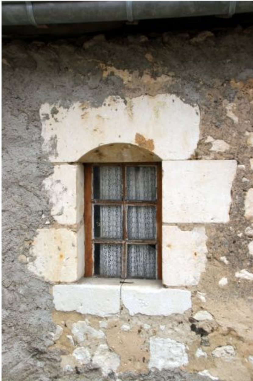
Maison 3 : petite fenêtre au linteau délardé sur la façade postérieure.
