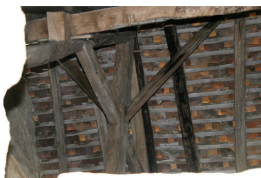
Maison 2 : charpente à pannes. Phot. Jean-Baptiste Darrasse IVR52_20057202621NUCA
