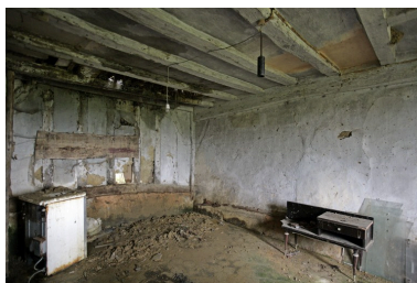
Logis, intérieur : élévation postérieure et mur-pignon de la chambre froide. Phot. François Lasa IVR52_20077200712NUCA
