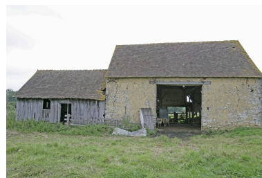
Grange et remise, élévations antérieures. Phot. François Lasa IVR52_20077200709NUCA
