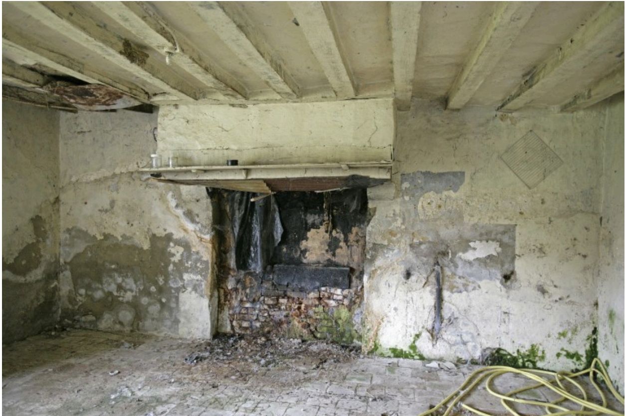
Logis, cheminée du bouge de maison.
