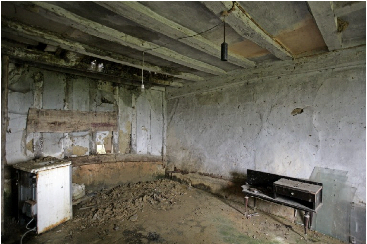
Logis, intérieur : élévation postérieure et mur-pignon de la chambre froide.
