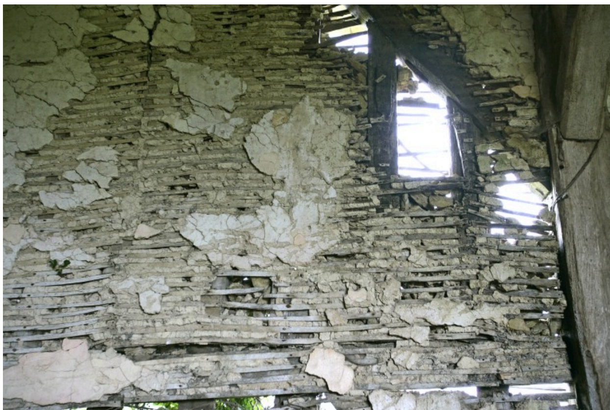
Grange, intérieur : détail de l'élévation postérieure en pan de bois hourdé de moellons.
