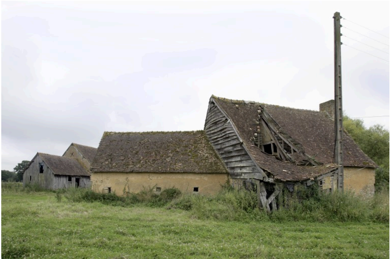
Logis et étables, élévations postérieures avec le ravallement.
