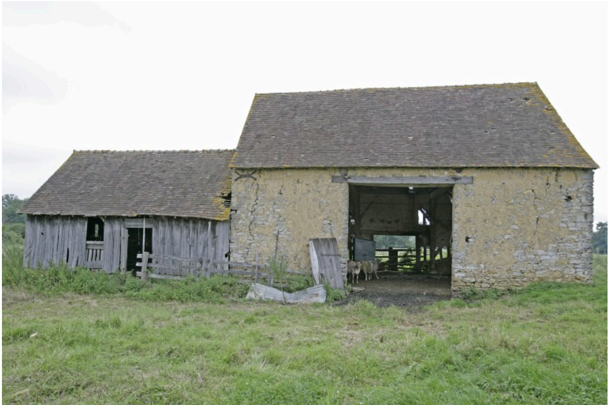
Grange et remise, élévations antérieures.
