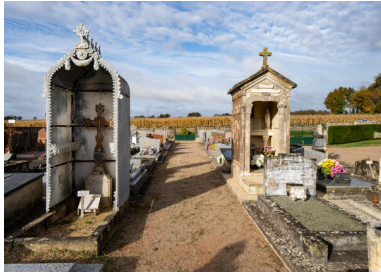
Cimetière. Phot. Thierry Seldubuisson IVR52_20247200323NUCA
