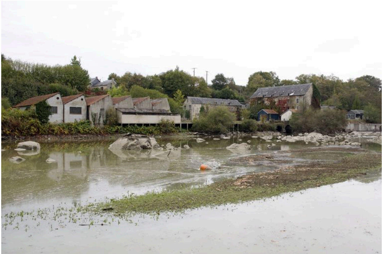
Vue d'ensemble de l'ancienne usine depuis la rive gauche en aval, pendant les écourues de 2009.
