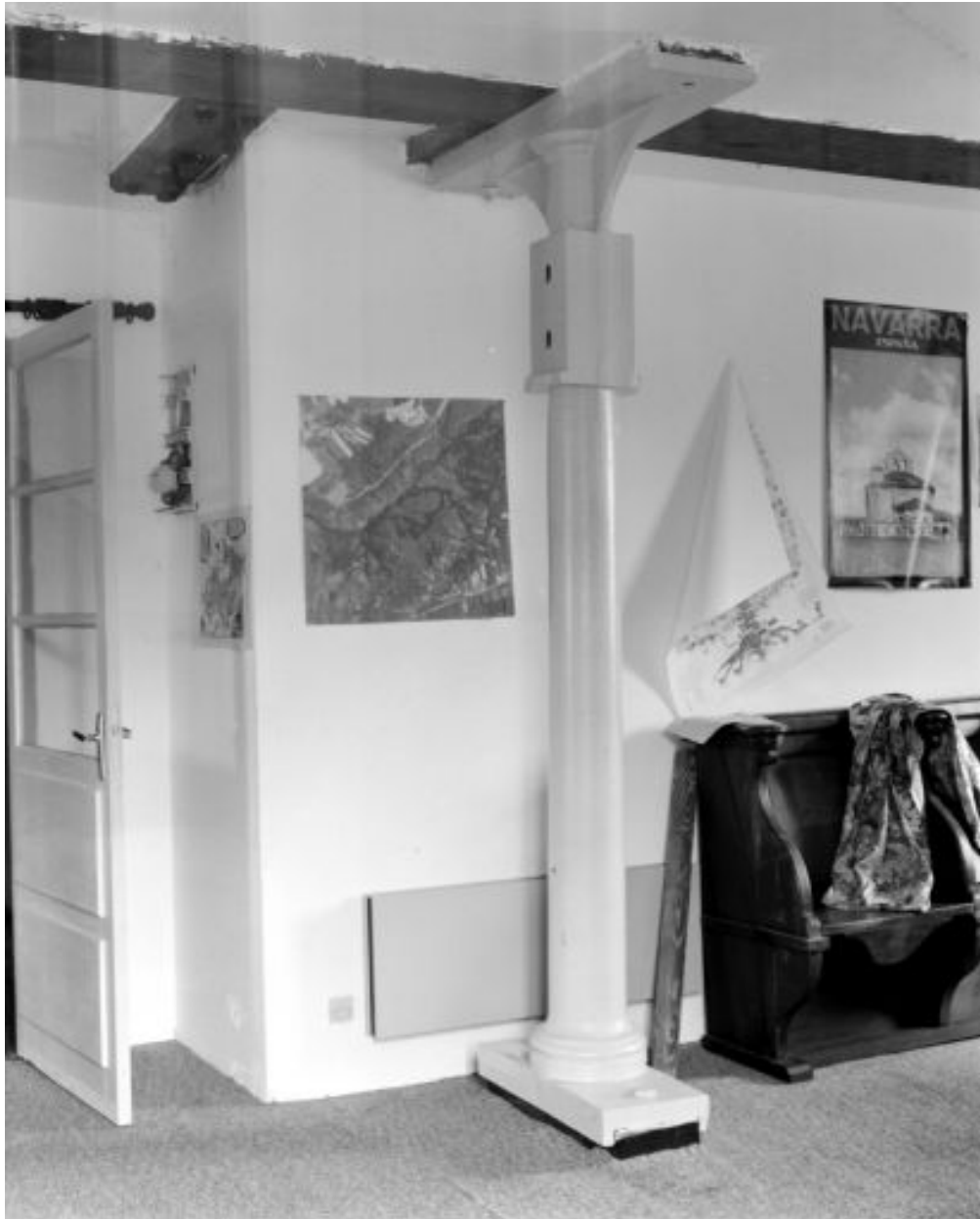
Colonne en fonte, fabriquée par les usines Chappée à Port-Brillet ou Antoigné, et située au premier étage de l'ancien moulin.
