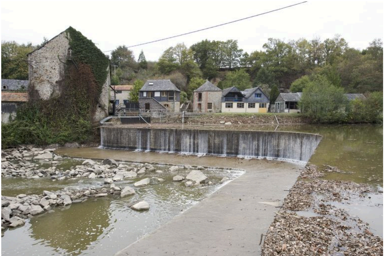
Ensemble des bâtiments nord de l'ancienne usine, vus depuis la rive gauche, pendant les écourues de 2009.
