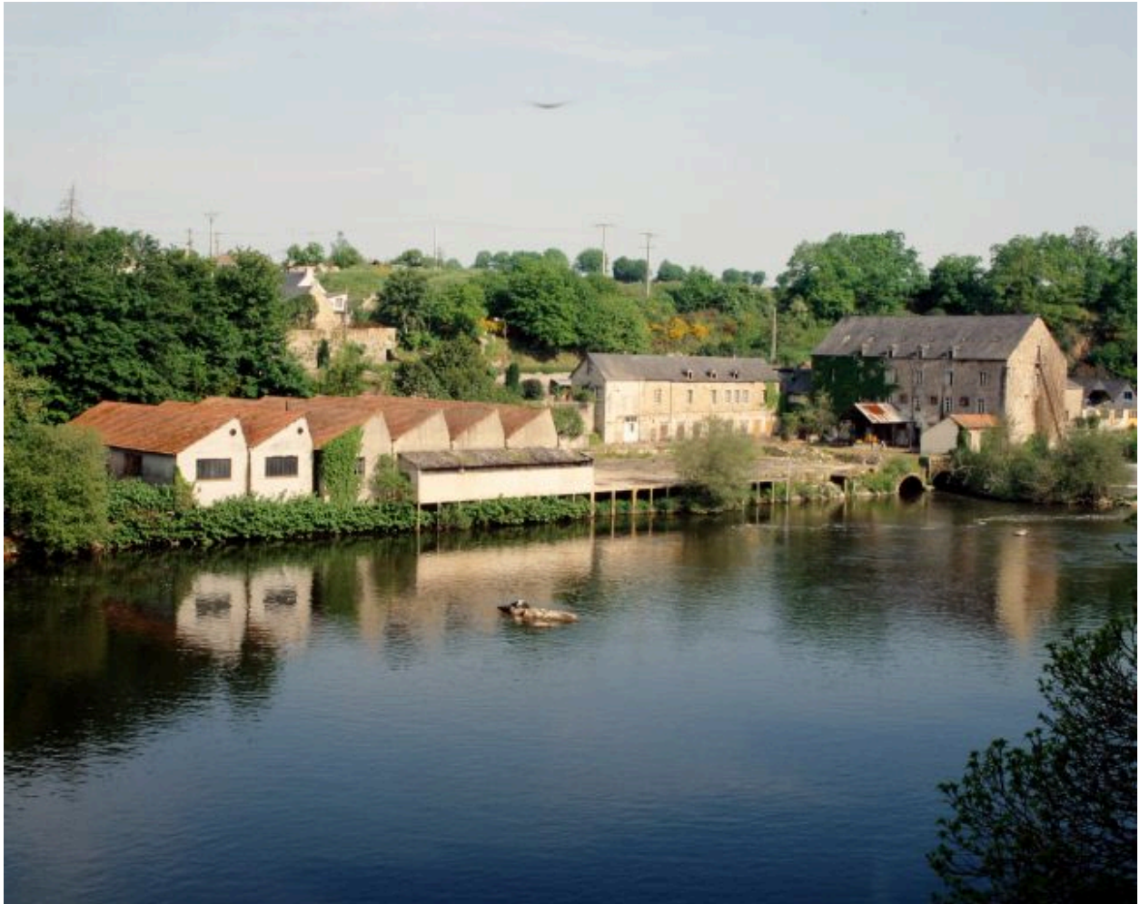
Vue d'ensemble de l'ancienne usine depuis la rive gauche en aval.
