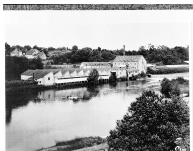
Vue d'aval depuis la rive gauche. Autr. Jean Combier, Repro. François Lasa IVR52_20025300035X
