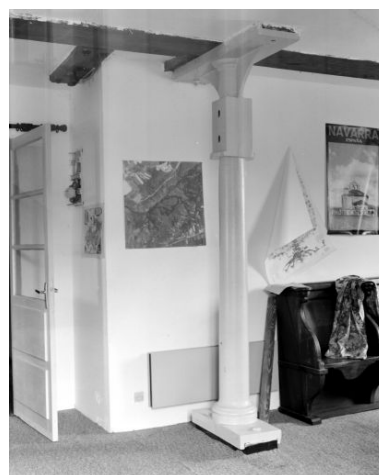
Colonne en fonte, fabriquée par les usines Chappée à Port-Brillet ou Antoigné, et située au premier étage de l'ancien moulin. Phot. François Lasa IVR52_19985300078X
