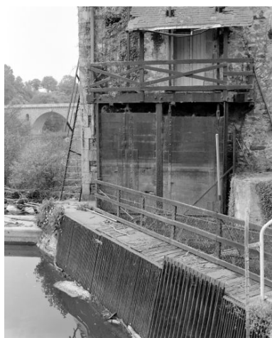
Vanne motrice controlant l'alimentation en eau de la turbine est située sous l'ancien moulin.
