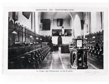
Choeur des religieuses, vu de la grille. Phot. François Lasa IVR52_20025302082X
