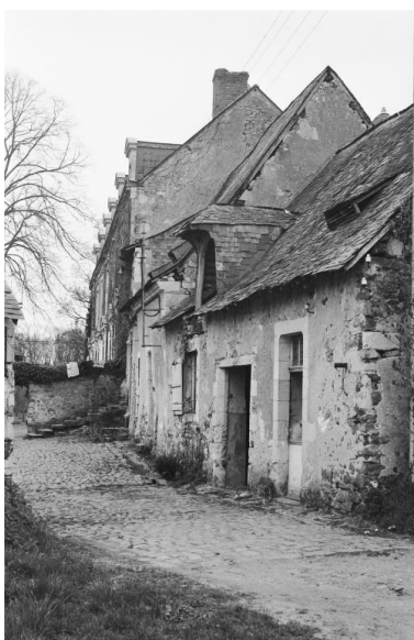
Vue du château et des communs, côté ouest. Phot. Dominique Letellier- d'Espinose, Phot. Bruno Rousseau IVR52_19764900596Z
