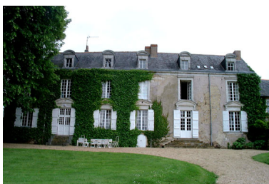
Façade principale. Phot. Rébecca Duée IVR52_20004901919NUCA
