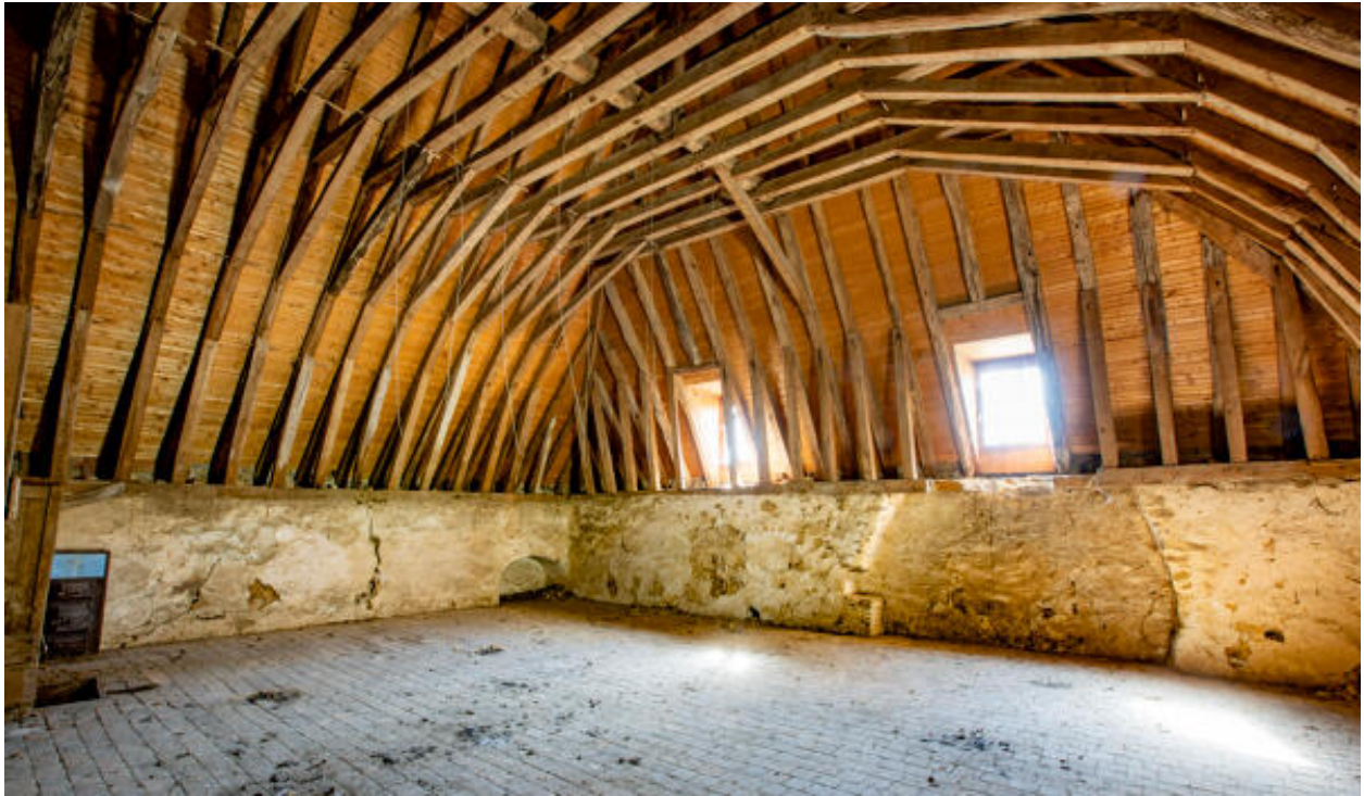
Le comble et la charpente.
