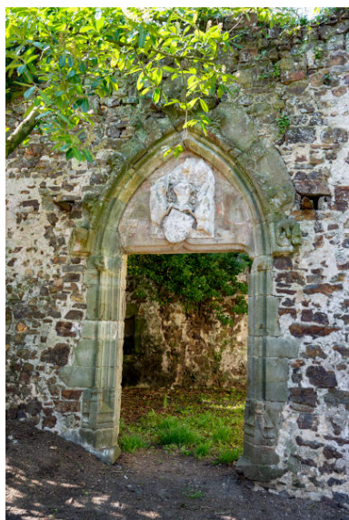
La porte de la chapelle. Phot. Pierre-Bernard Fourny IVR52_20225300378NUCA
