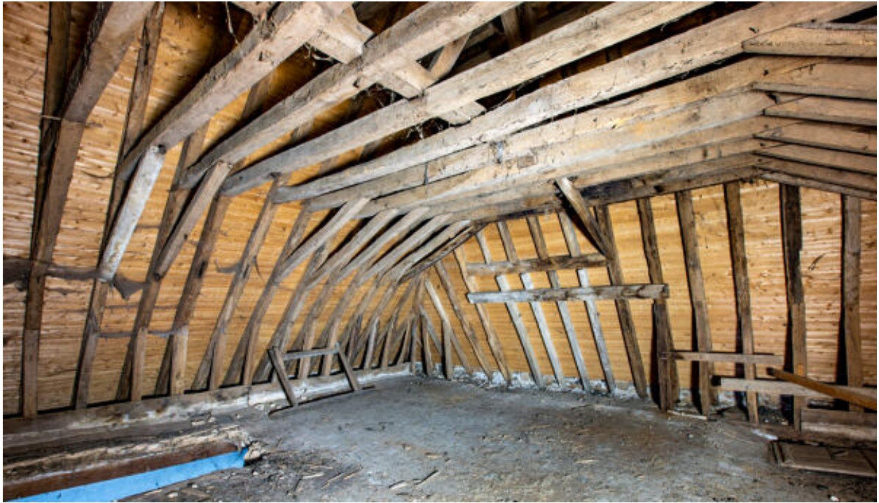
Le comble et la charpente.
