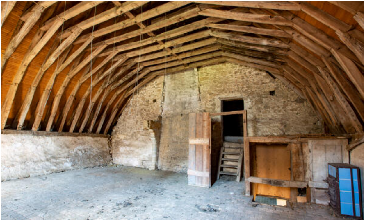
Le comble et la charpente.
