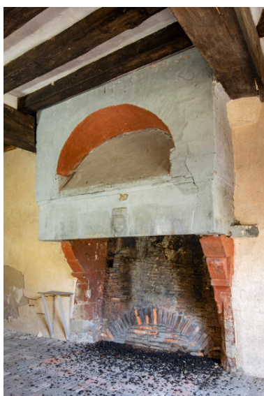
La cheminée de la salle du rez-de-chaussée. Phot. Pierre-Bernard Fourny IVR52_20225300417NUCA
