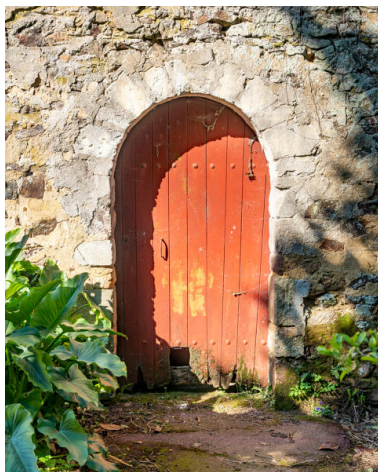
La porte secondaire. Phot. Pierre-Bernard Fourny IVR52_20225300392NUCA
