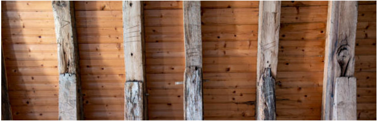
La charpente du comble, détail des marques d'assemblage.
