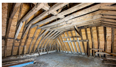
Le comble et la charpente. Phot. Pierre-Bernard Fourny IVR52_20225300429NUCA
