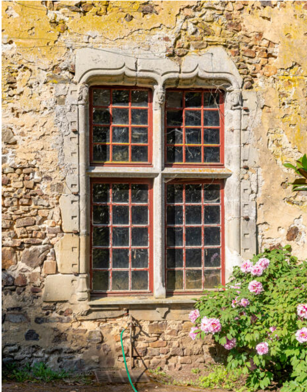
La grande fenêtre du rez-de-chaussée.
