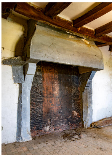
La cheminée de la pièce à l'étage.
