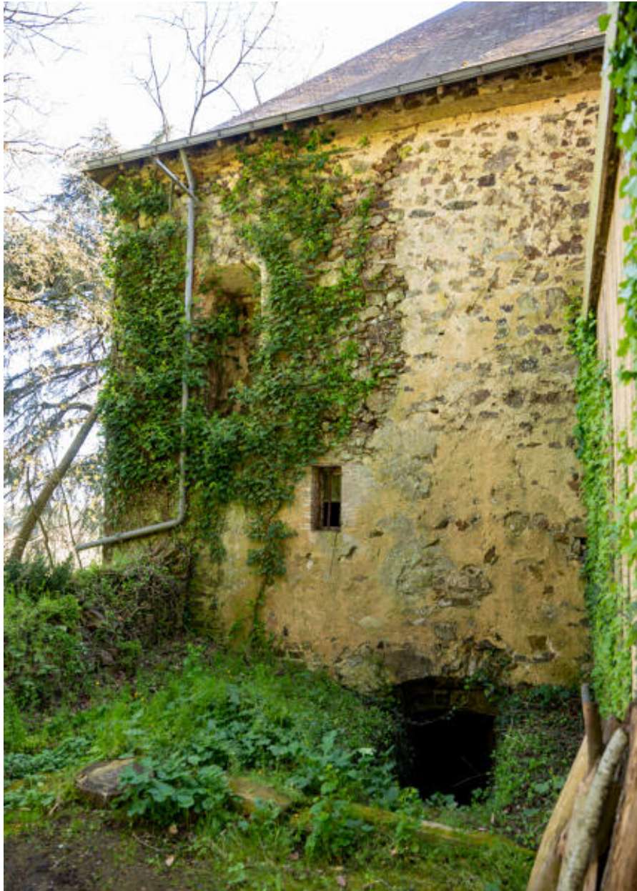
La façade postérieure (vue partielle) et l'accès à la cave.
