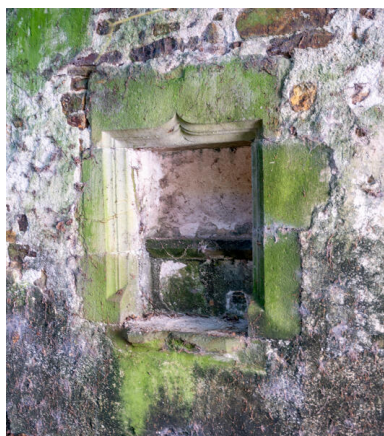
Le lavabo de la chapelle. Phot. Pierre-Bernard Fourny IVR52_20225300383NUCA
