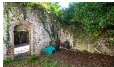
L'intérieur de la chapelle. Phot. Pierre-Bernard Fourny IVR52_20225300384NUCA
