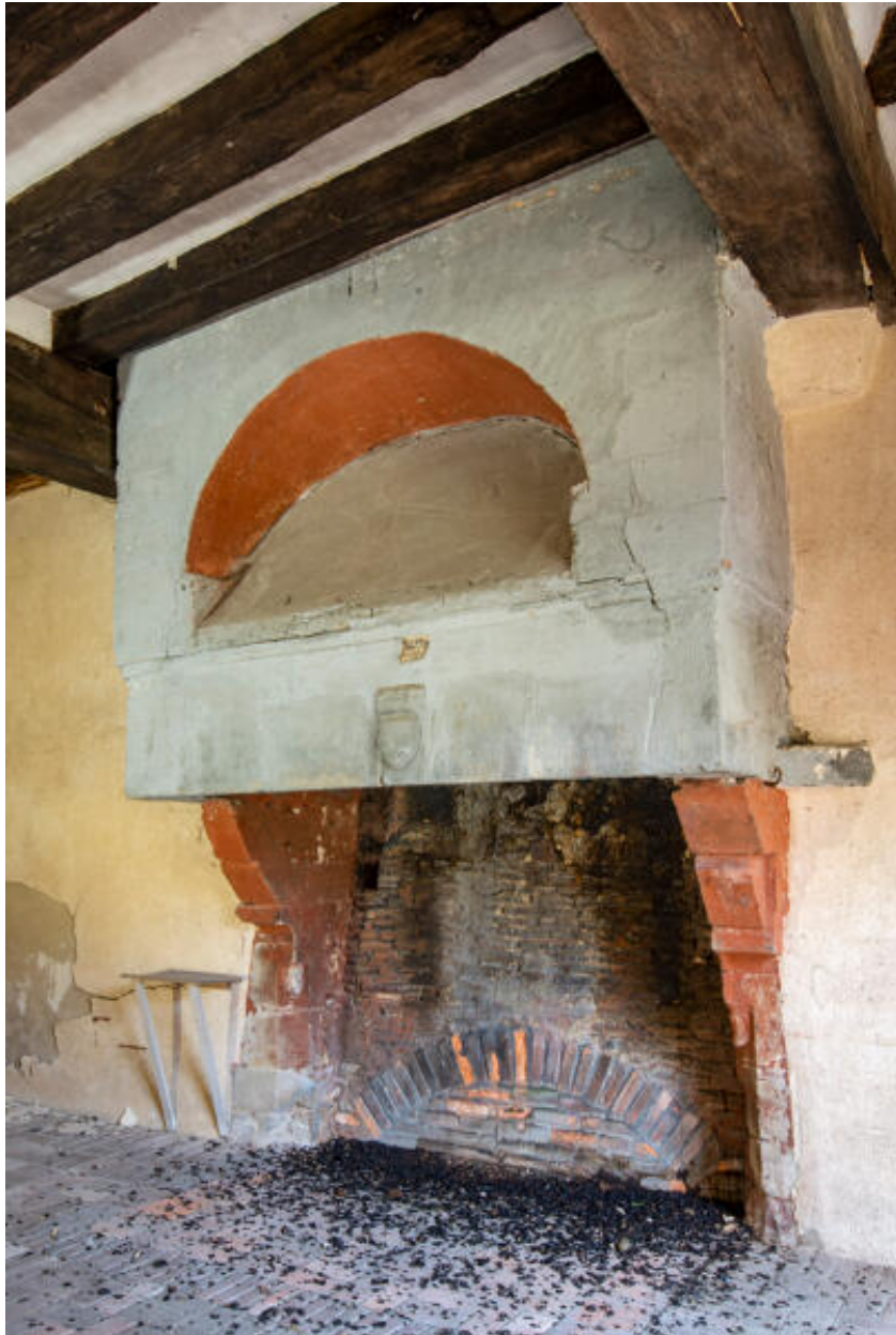
La cheminée de la salle du rez-de-chaussée.
