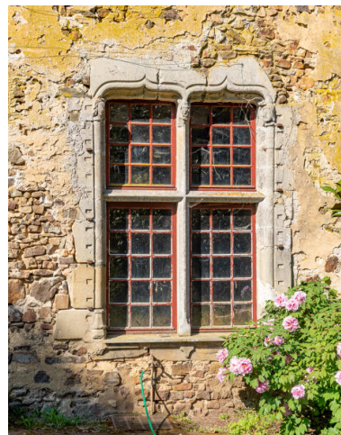
La grande fenêtre du rez-de-chaussée. Phot. Pierre-Bernard Fourny IVR52_20225300390NUCA
