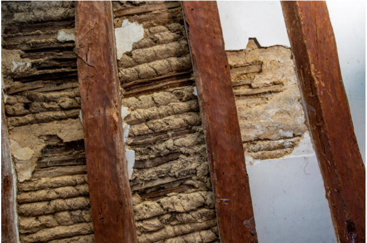
Un détail du plafond de la pièce à l'étage.
