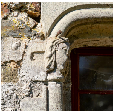
La grande fenêtre du rez-de- chaussée, détail d'une tête sculptée. Phot. Pierre-Bernard Fourny IVR52_20225300410NUCA
