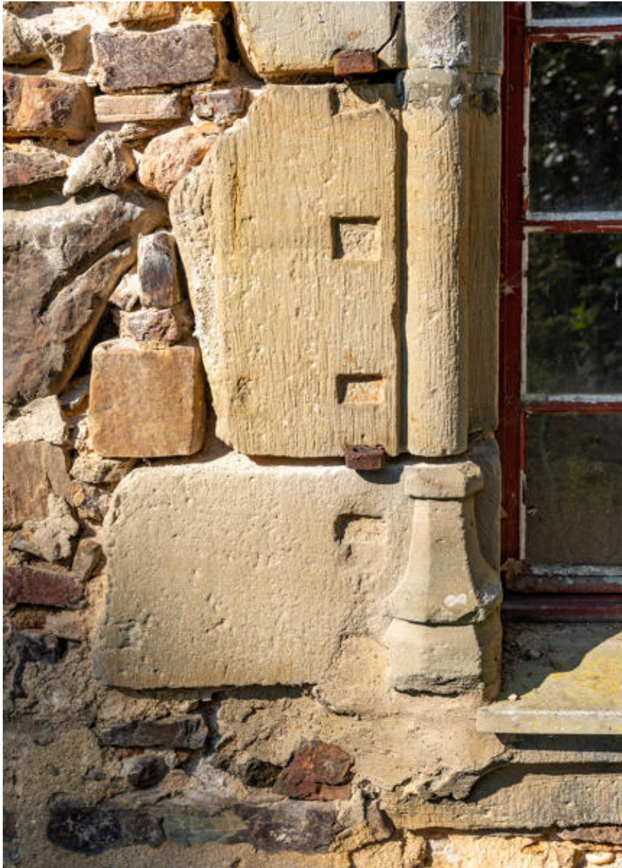
La grande fenêtre du rez-de-chaussée, détail de l'encadrement.
