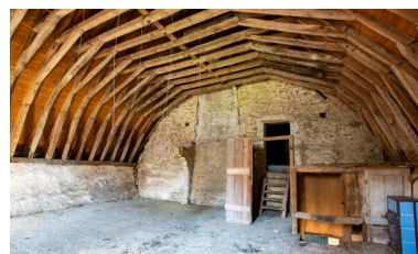
Le comble et la charpente.
