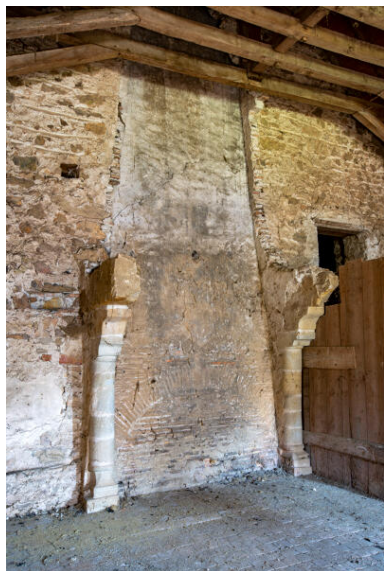
La cheminée du comble. Phot. Pierre-Bernard Fourny IVR52_20225300426NUCA
