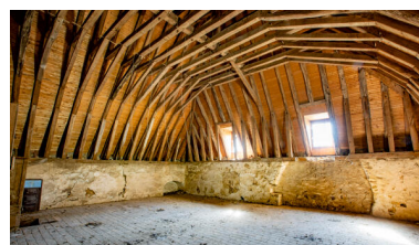
Le comble et la charpente. Phot. Pierre-Bernard Fourny IVR52_20225300425NUCA
