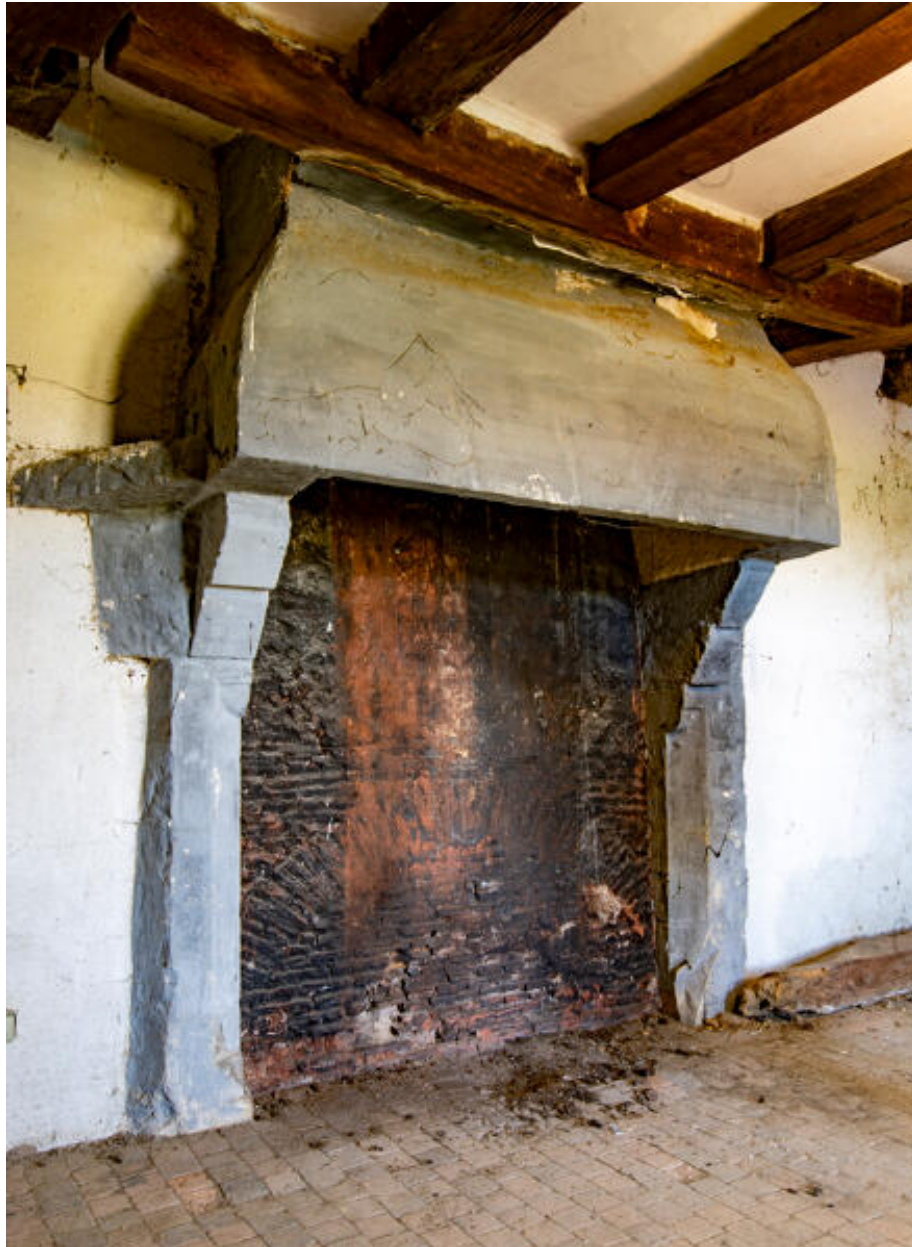
La cheminée de la pièce à l'étage.
